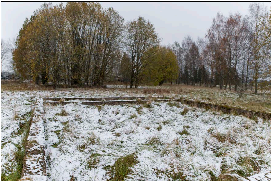
Foto 14 (031). Ollepa (Võhma) lennuväli. Hoone [4] vundament, taga puudesalus vundament [3]. Foto Mart Mõniste 25.10.2016.
