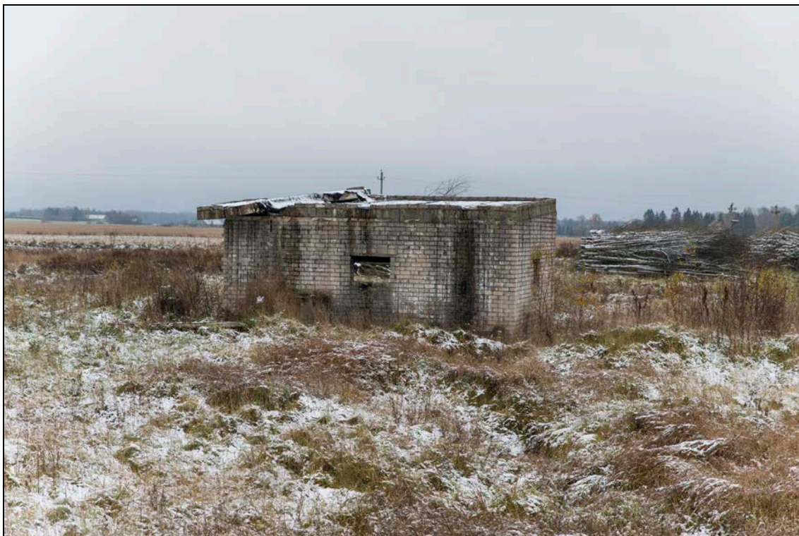
Foto 23 (063). Ollepa (Võhma) lennuväli. Katlamaja [5]. Foto Mart Mõniste 25.10.2016.
