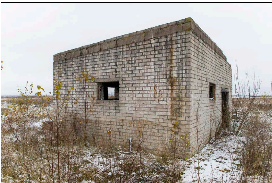
Foto 18 (046). Ollepa (Võhma) lennuväli. Katlamaja [5]. Foto Mart Mõniste 25.10.2016.
