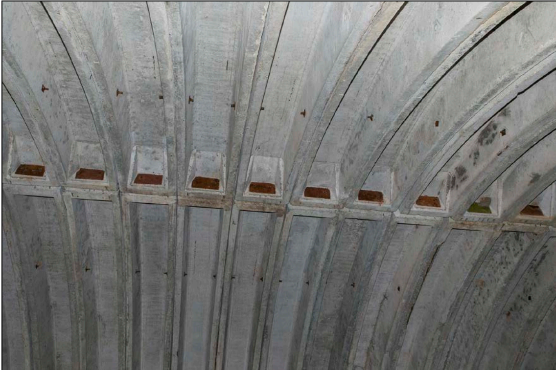
Foto 51 (193). Ollepa (Võhma) lennuväli. Angaar [9]. Kõik paneelide kinnituspoldid on alles. Foto Mart Mõniste 25.10.2016.
