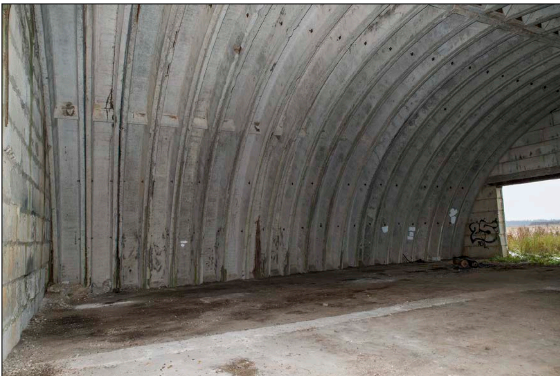
Foto 50 (190). Ollepa (Võhma) lennuväli. Angaari [9] sisemõõtmed: pikkus 19, laius 16 m, kõrgus 7 m. Foto Mart Mõniste 25.10.2016.
