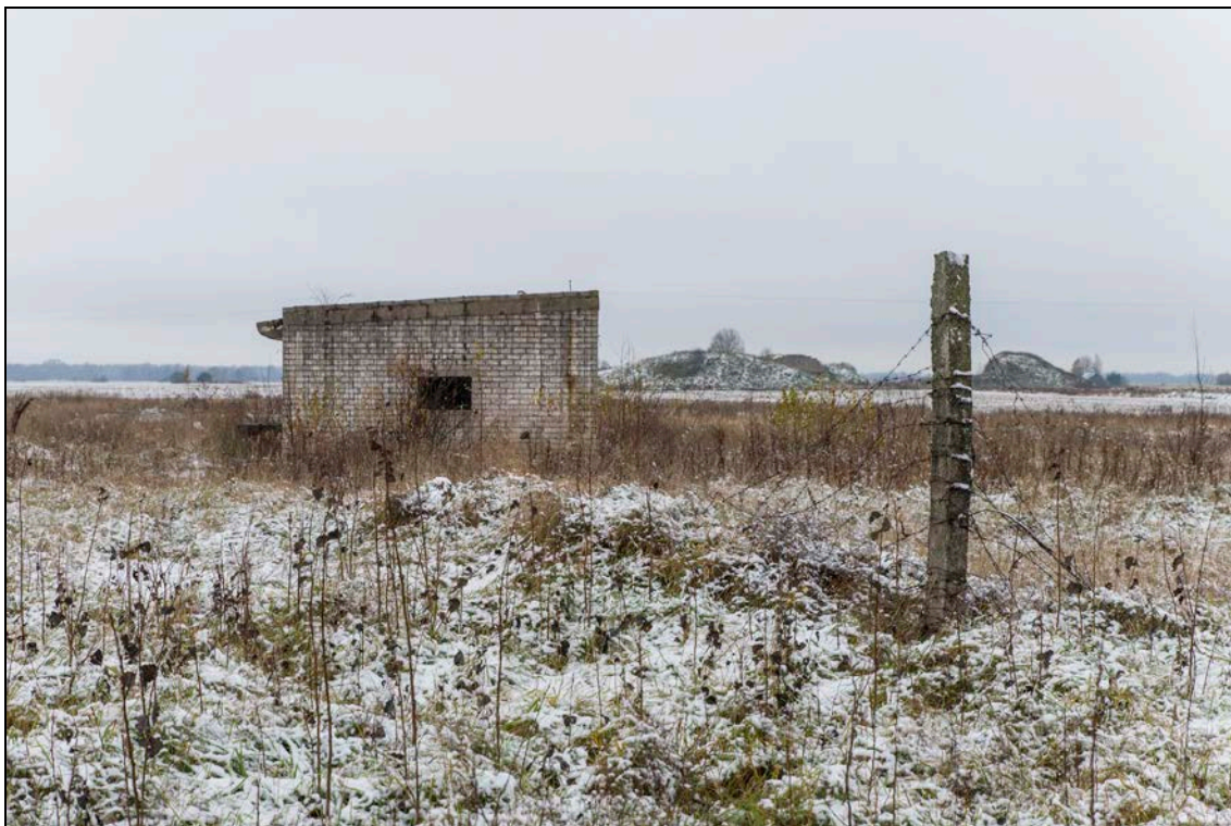
Foto 17 (041). Ollepa (Võhma) lennuväli. Katlamaja [5]. Foto Mart Mõniste 25.10.2016.
