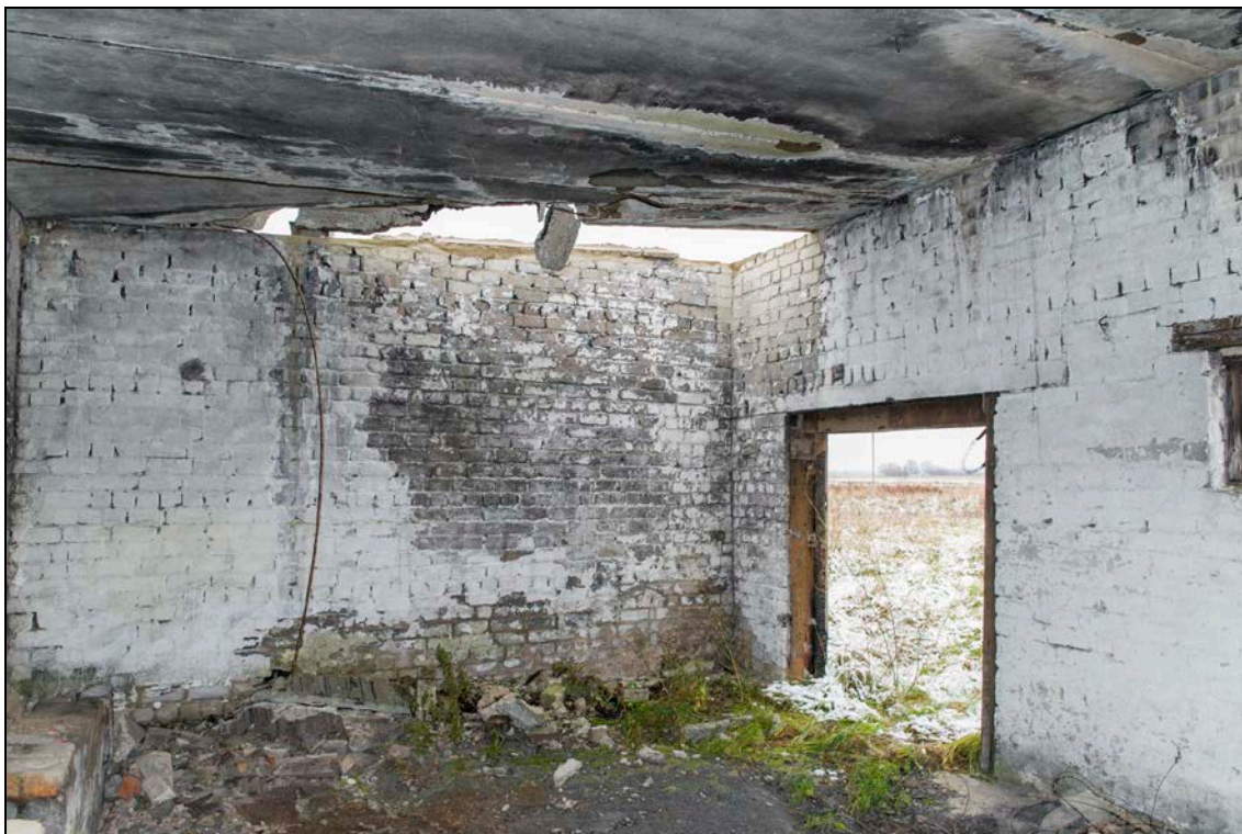
Foto 21 (052). Ollepa (Võhma) lennuväli. Katlamaja [5]. Foto Mart Mõniste 25.10.2016.
