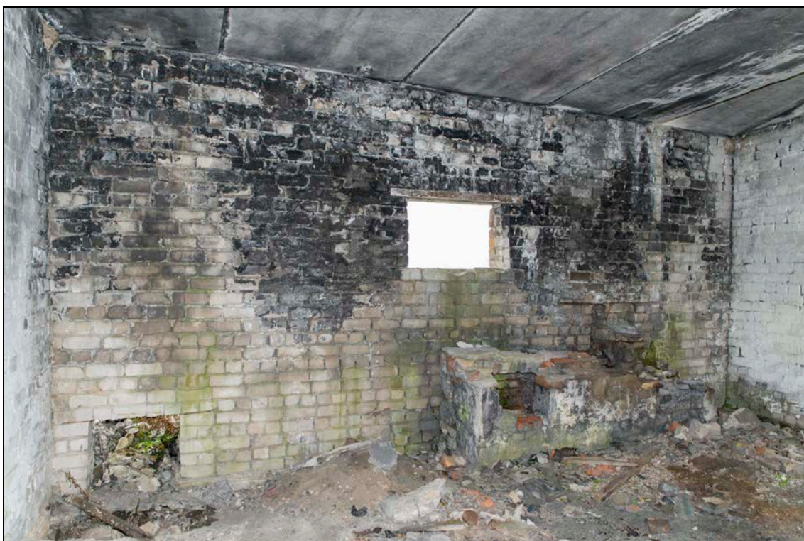
Foto 20 (050). Ollepa (Võhma) lennuväli. Katlamaja [5]. Foto Mart Mõniste 25.10.2016.
