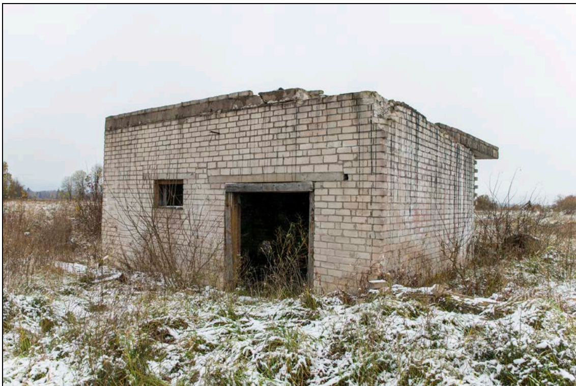
Foto 19 (048). Ollepa (Võhma) lennuväli. Katlamaja [5]. Foto Mart Mõniste 25.10.2016.
