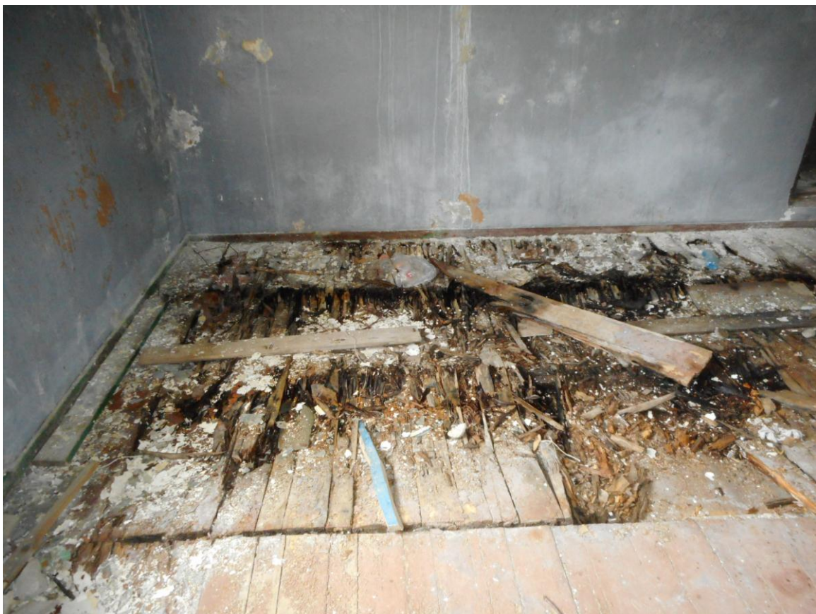
Foto 16. Komplekshoone II korruse suurema ruumi sisevaade (14.09.2017). Laudpõrandast umbes pool on hästi säilinud, pool ära pehkinud.
