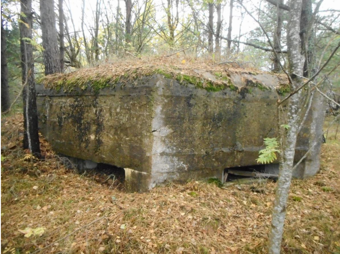
Foto 27. Dott (joonis 4, nr 4), vaade kagust (14.09.2017). Üsna erandlikult on selle katuseservad valatud kumeratena, tavaliselt on need kas täisnurksed või sirge faasiga. Sees on säilinud kahe ambrasuuri terasluugid, seintel on piirivalvurite demblikirjeid alates 1976. a-st. Dott on seest lubjatud, oli kahe uksega, millest sisemise piidad on hästi säilinud.
