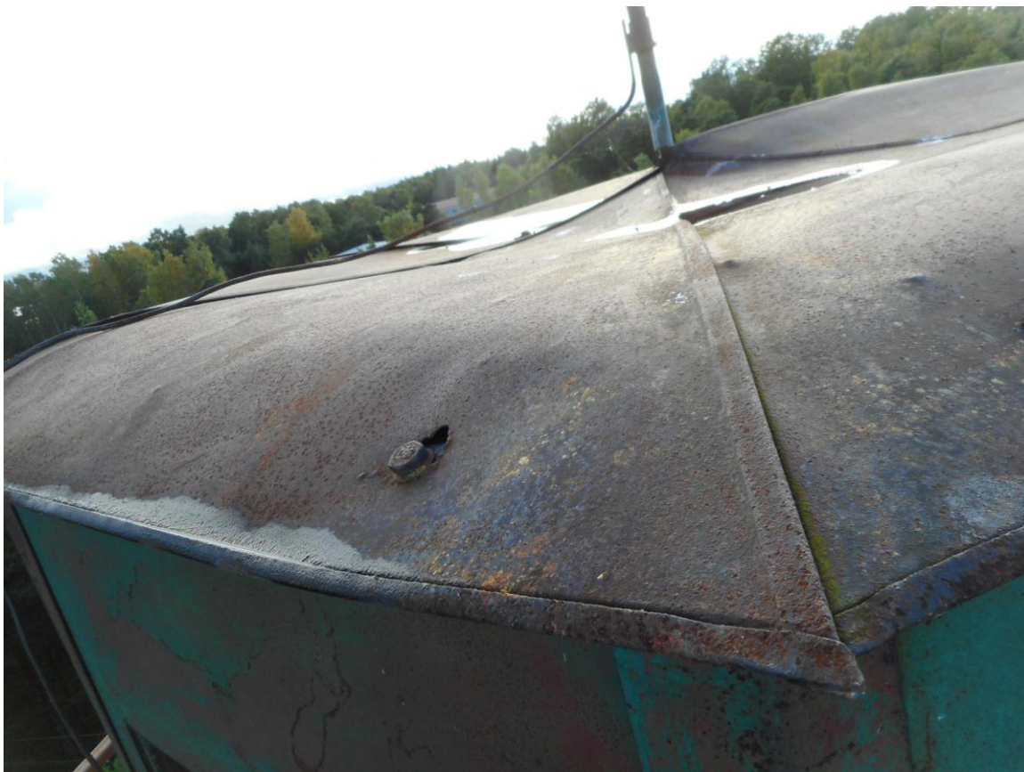
Foto 26. Tornis (joonis 4, nr 2) plekk-katus (14.09.2017). Katusel on u 2,5 m pikkune piksevarras.
