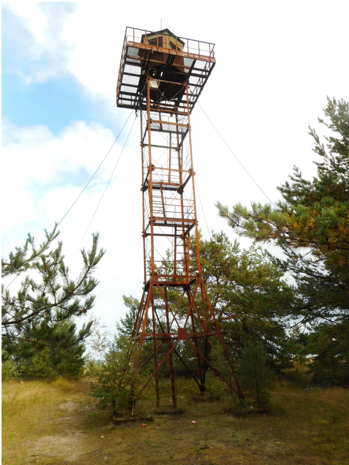
Foto 22. Vaatlustorn (joonis 4, nr 2), vaade läänest (14.09.2017). Radarialuseid pole tornis olnud.
