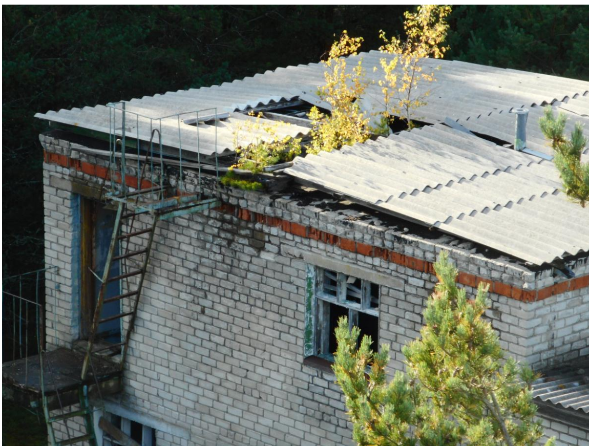
Foto 18. Komplekshoone katuse vaade kagust (tornist, 14.09.2017). Ülal paremal binokulaari BMT-110 alus. Eterniitkatuse ehitamisel on harjaplekk jäänud paigaldamata (selle kinnitusjälgi pole).
