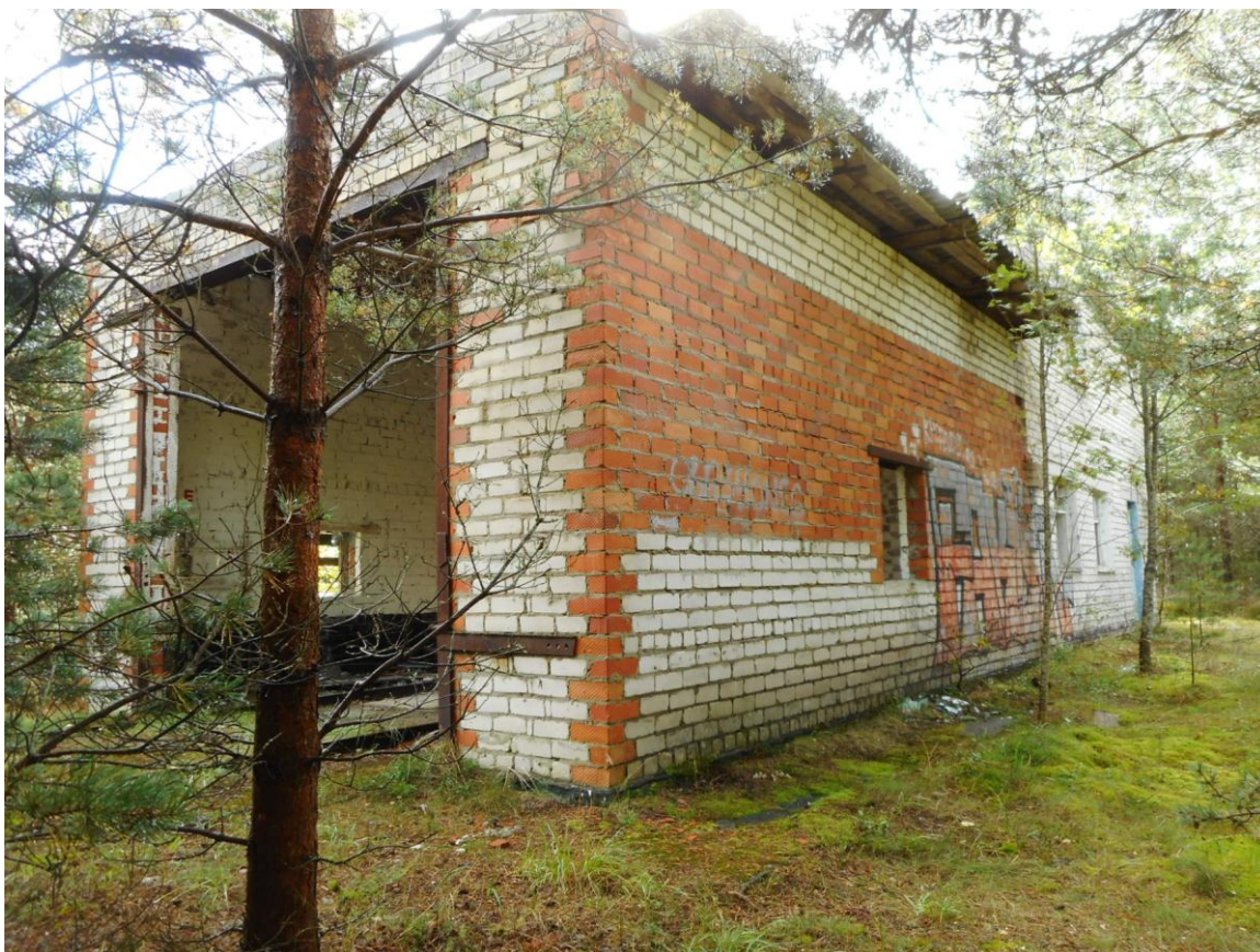
Foto 10. Komplekshoone vaade kirstest (14.09.2017). Esiplaanil prožektoriruum, mille põhjasein on 1,8 m kõrguses osas laotud punastest tellistest.
