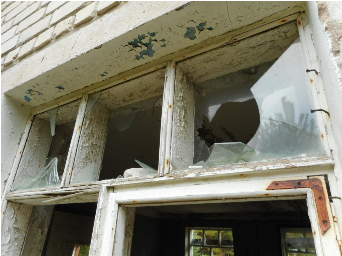
Foto 15. Komplekshoone aken lähivaates (14.09.2017). Tervena on säilinud õhutusakna raam (neid on veel kahel aknal).
