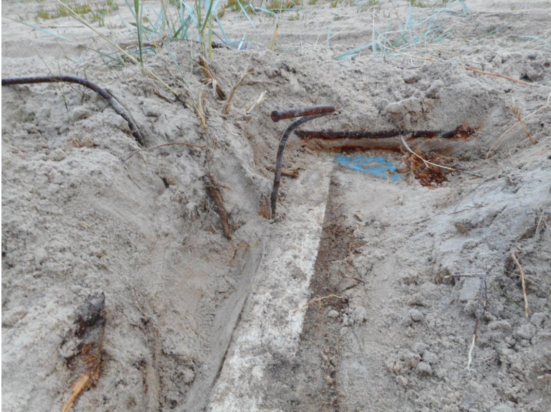
Foto 21. Prožektoripositsiooni merepoolse otsa värvimärgised liiva all kuni 50 cm sügavusel (14.09.2017). Valge joon tähistab betooni äärt, sinine ilmakaari. Liivast ulatuvad välja 1 cm jämedused kõverad vardad, kummalgi pool kaks.
