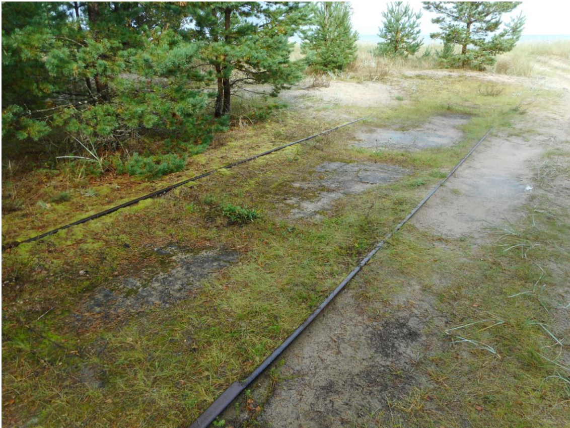
Foto 20. Prožektoripositsiooni merepoolne ots (14.09.2017). Näha on relsside üleminek I-taladelt vagonetirööbasteks. Relsiotsad on mattunud väikese liivaluute alla ja selle peale on kasvanud noor mänd.
