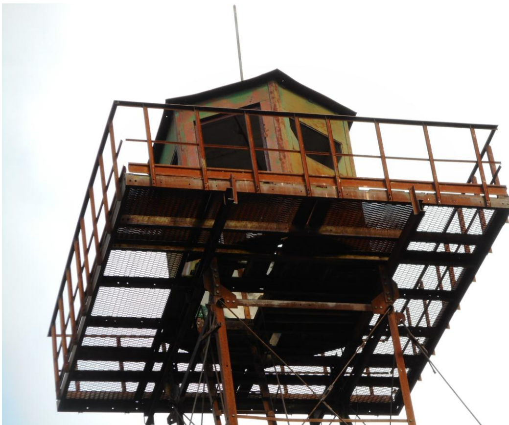
Foto 25. Tornis (joonis 4, nr 2) vaatlusruum ja üleni metallist rõdu (14.09.2017). Viies kuusnurksest aknast kolmel on avatavad plekkraamid säilinud (hinged kinni roostetanud). Säilinud on ka enamus u 25 cm pikkusi akende seinte külge kinnitamise haake.
