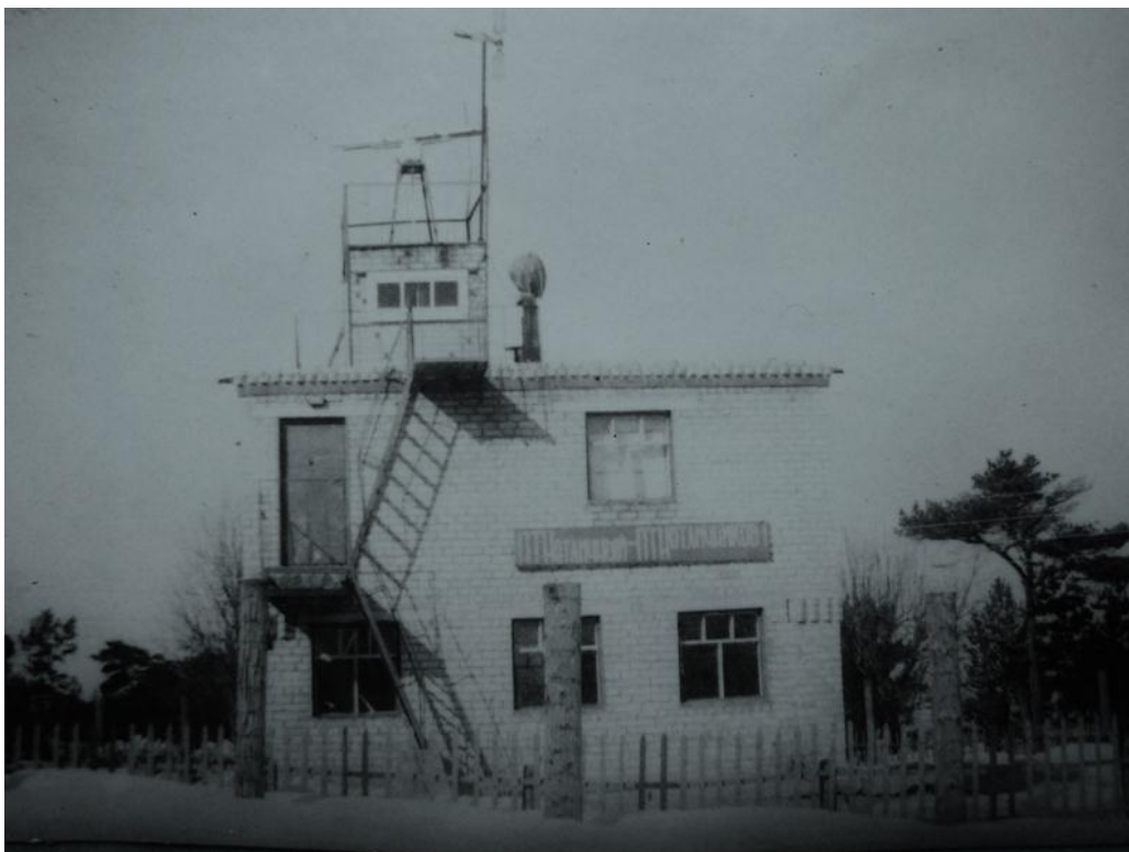
Foto 1. Lehtma TVP 1982. aastal või varem. Katusel on vaid üks vaatlusruum ja radariantenn, samuti raadioantenn ja binokulaar või laevaprožektor (alus on tänaseni alles), veel aga pole prožektorikorpust ega sõrestik-raadiomasti. Okastraataia taga on puitlippidest aed. Seinal on loosung: „ПТН отличный – ПТН отличников!” Foto valdaja Эрнст Калимуллин (teenistusaeg 1980-1982 sügis), http://pogran-zastava.ru/album_pic.php?pic_id=432 .
