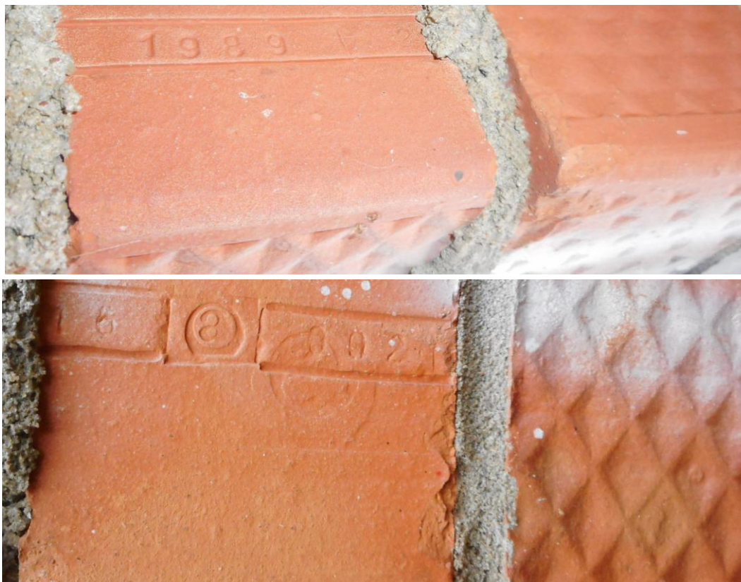
Foto 11. Märgised prožektoriruumi seinatellistel (14.09.2017): „1989” ning „a”. Tellised on toodetud Lätis, arvatavasti Alūksne tehases (samasugused märgised on Hiiumaal Suuremõisas 1988–89 ehitatud hoonetele paigaldatud katusekividel).
