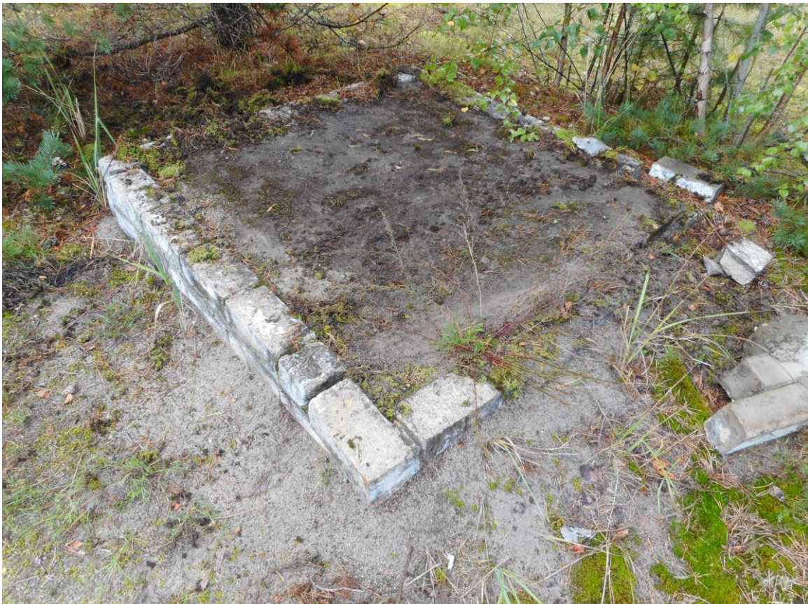
Foto 28. Silikaatkividega ääristatud betoonalus (joonis 4, nr 5) väravakoha kõrval (14.09.2017).
