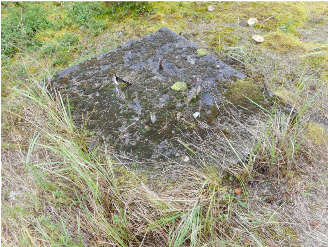
Foto 29. Raadiomasti alus (joonis 4, nr 6) (14.09.2017).
