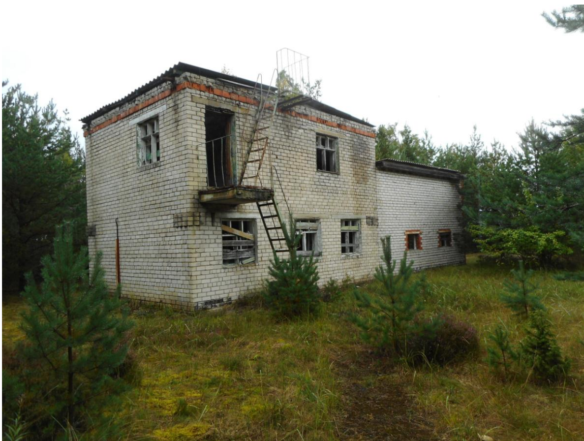
Foto 8. Komplekshoone vaade edelast (14.09.2017). Esiplaani betoonkõnnitee.
