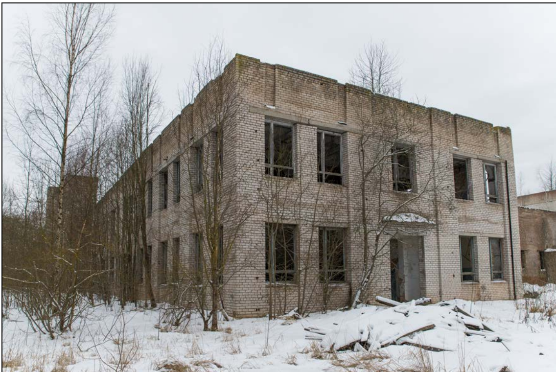
Foto 28 (115). Tartu, Roosi 83. Kahekorruseline osa [3], vaade kirdest. Foto Mart Mõniste 28.01.2015.
