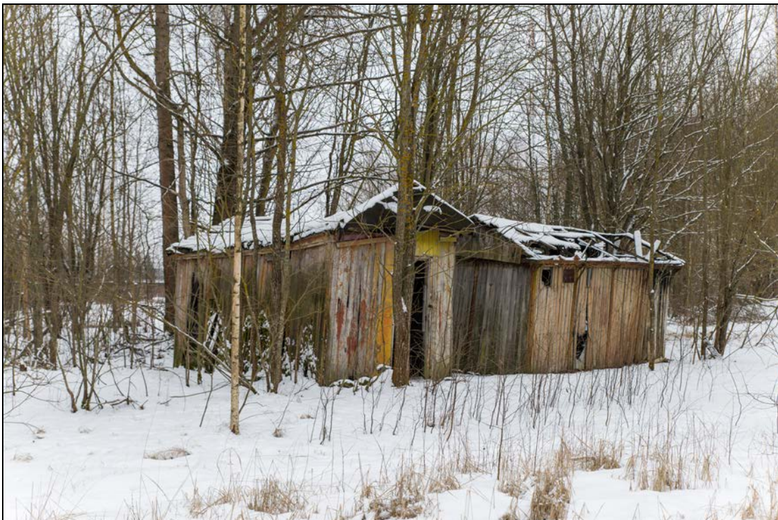
Foto 80 (114). Tartu, Roosi 83. Puidust putkad [9]. Foto Mart Mõniste 28.01.2015.
