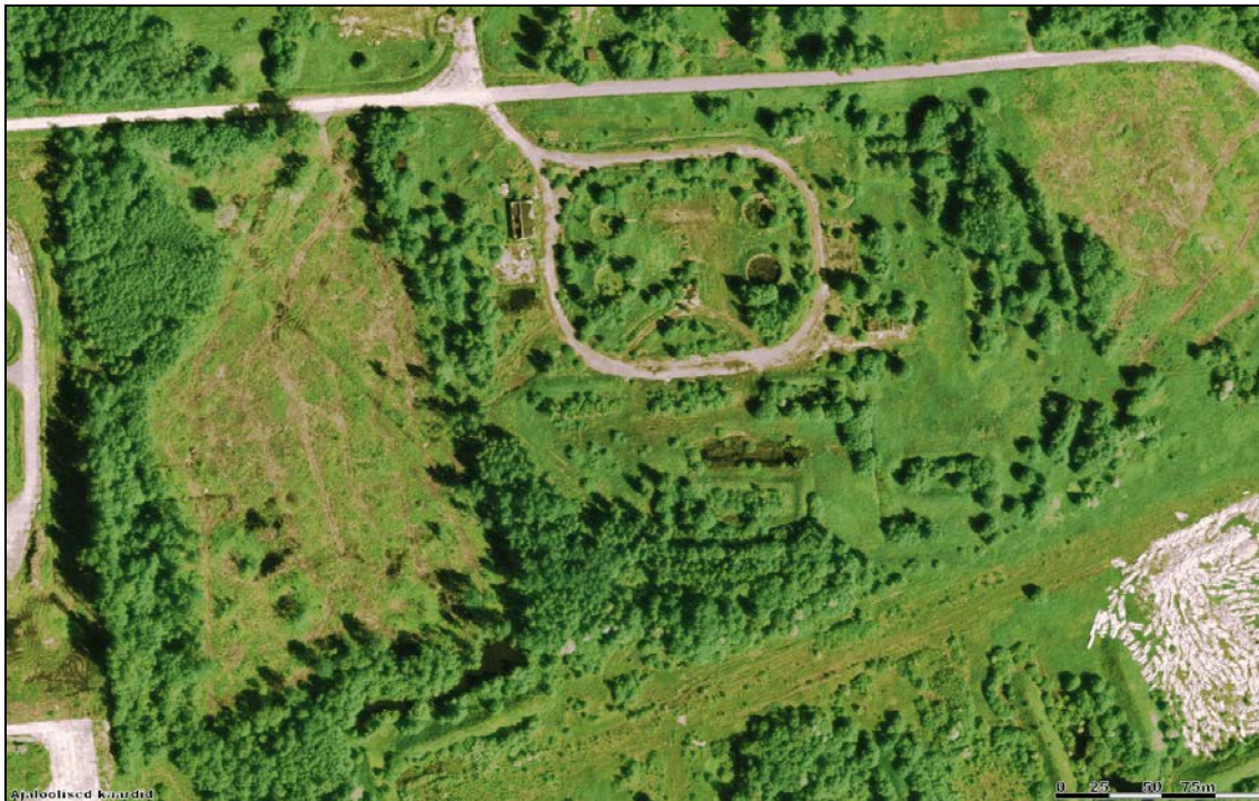
Skeem 11. Tartu Raadi lennuväli. Naftabaas. Aerofoto 2010. aastast. Naaberkinnistul on tehtud lageraiet.
