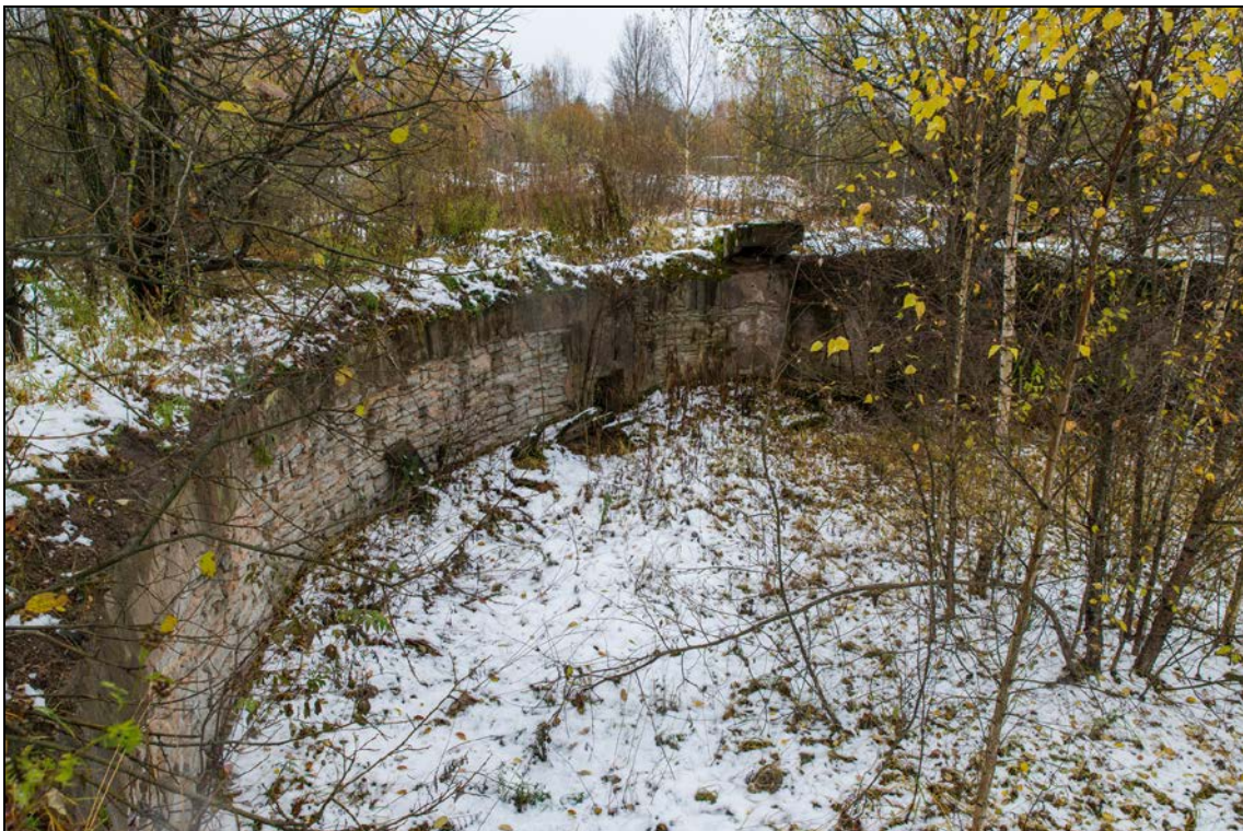
Foto 30 (550). Tartu Raadi lennuväli (aruanne 3, naftabaas). Reservuaar [44]. Tugiseinad on osaliselt laotud paekivist. Foto Mart Mõniste 26.10.2016
