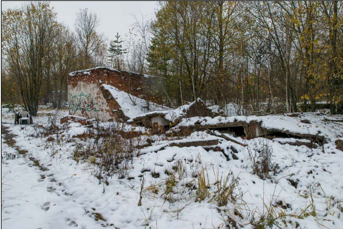
Foto 43 (529). Tartu Raadi lennuväli (aruanne 3, naftabaas). Hoone [48] tagumine pool on lammutatud. Foto Mart Mõniste 26.10.2016
