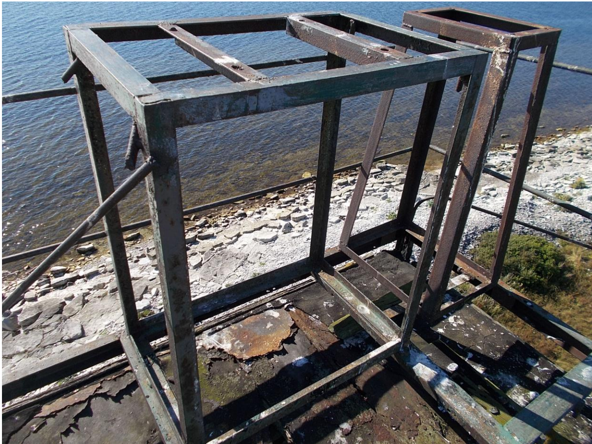
Foto 29. (284) Atla tehnilise vaatluse post. Torn [9]. Radariantenni alusraam (vasakul). Parempoolse kitsama raami otstarve on autorile teadmata (võimalik, et mõne vanema radari alus). Foto Jüri Pärn 19.08.2015.
