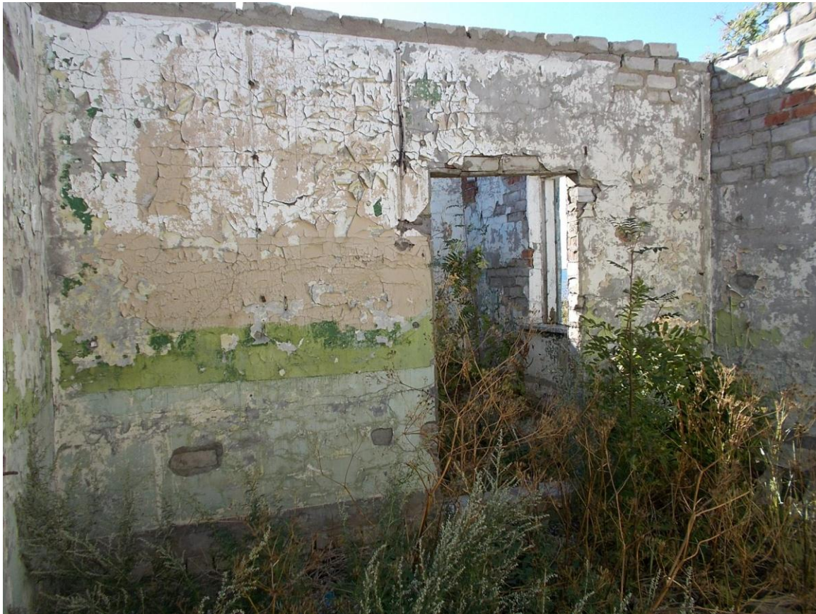
Foto 13. (200) Atla tehnilise vaatluse post. Operaatorihoone [7] sisevaade. Foto Jüri Pärn 19.08.2015.
