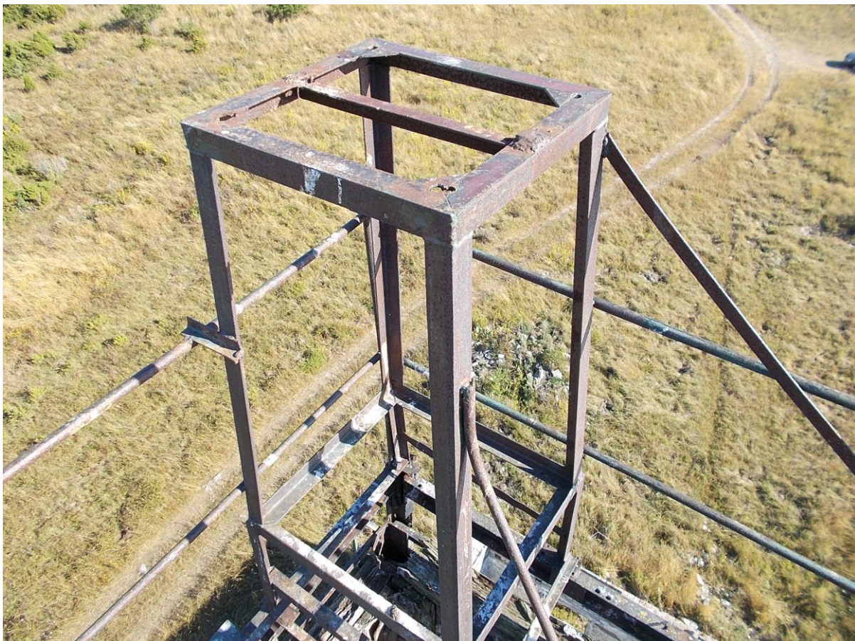
Foto 28. (269) Atla tehnilise vaatluse post. Torn [9]. Radariantenni alusraam. Foto Jüri Pärn 19.08.2015.
