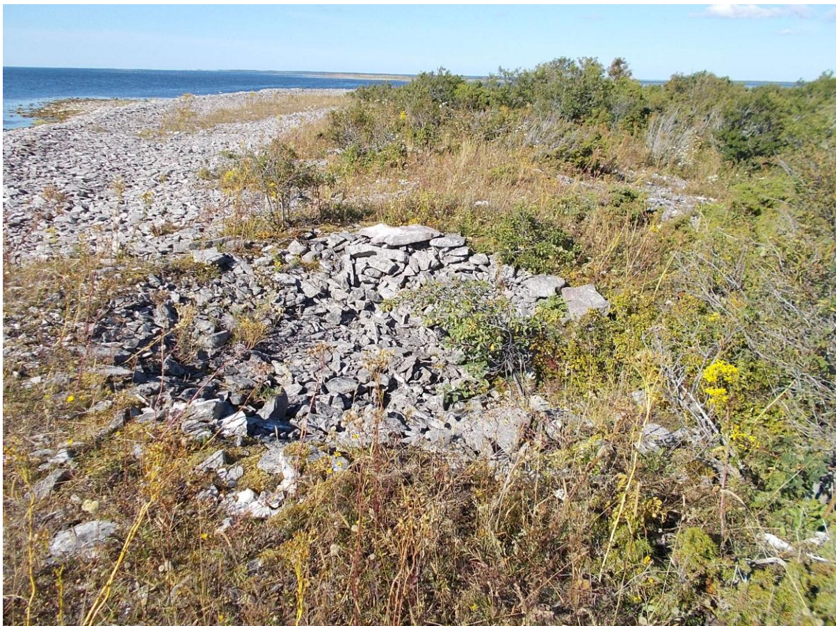
Foto 30. (160) Atla tehnilise vaatluse post. Paekividest kaitserajatis [13]. Foto Jüri Pärn 19.08.2015.
