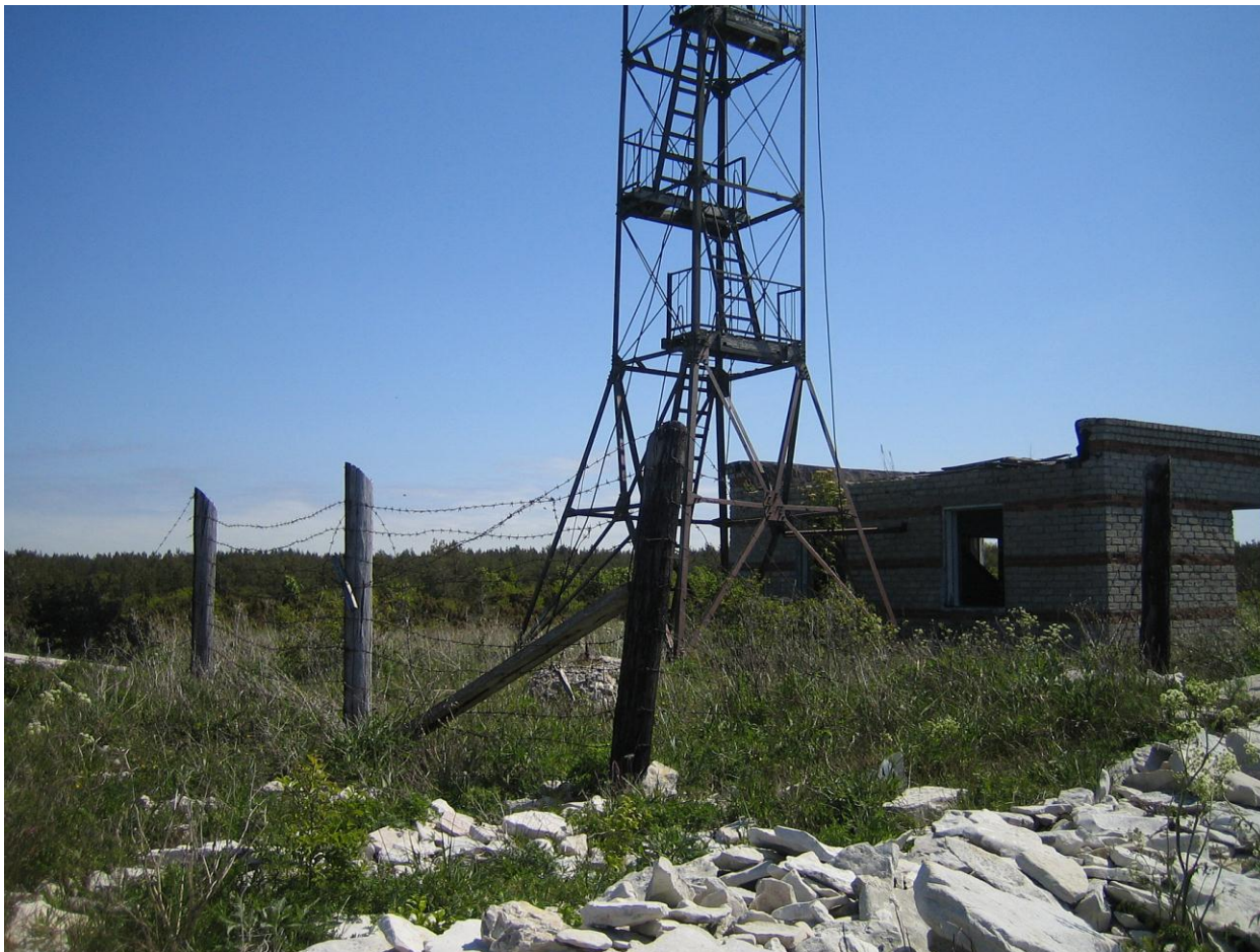
Foto 45. (IMG_1832) Atla tehnilise vaatluse post. Torn [9] ja operaatorihoone [7]. Piirdeaed on veel alles, samuti operaatorihoone katus. Teised hooned on arvatavasti juba lammutatud. Foto: kasutaja „dude”, 10.6.2006 (internetifoorum militaar.net).
