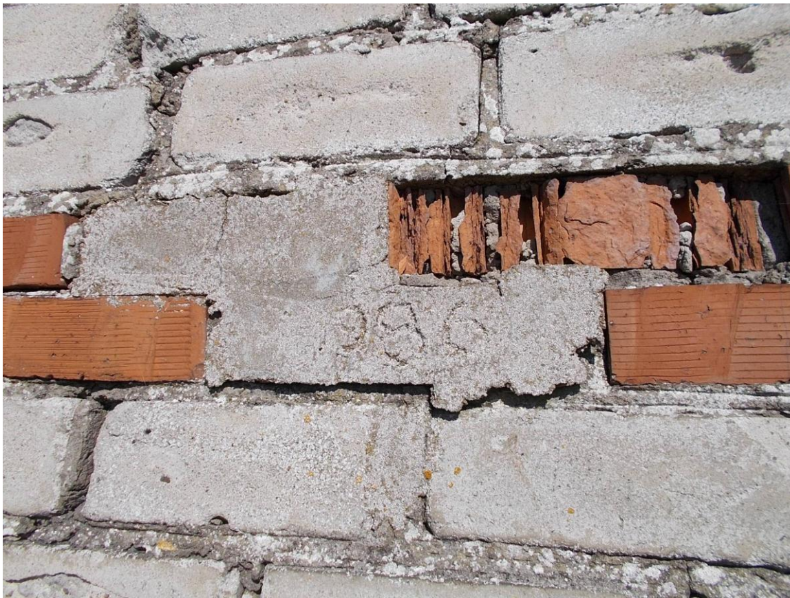
Foto 15. (138) Atla tehnilise vaatluse post. Operaatorihoon [7] merepoolsesse seina on jäädvustatud aastaarv 1986 (seina pisiparanduse aeg?). Foto Jüri Pärn 19.08.2015.
