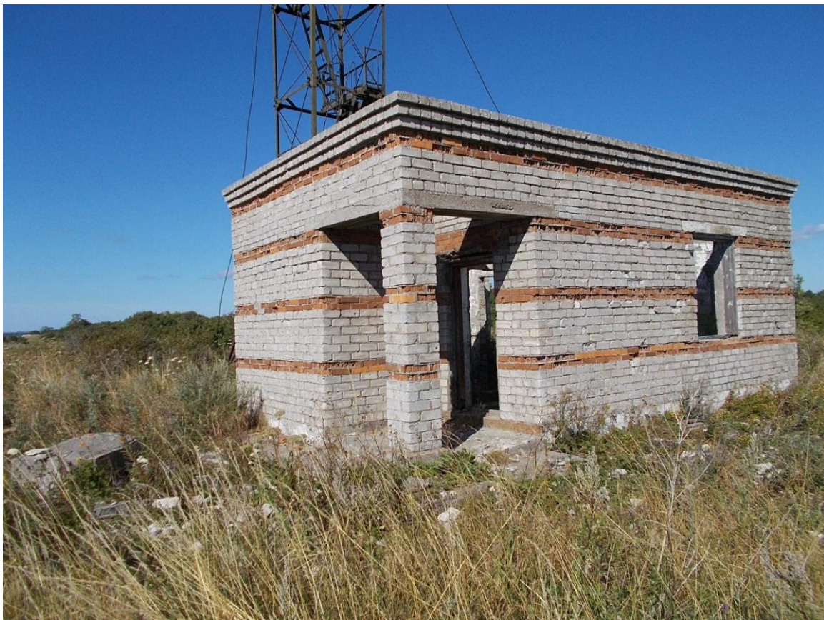
Foto 8. (34) Atla tehnilise vaatluse post. Operaatorihoone [7], vasakul torni [9] ankur. Foto Jüri Pärn 19.08.2015.
