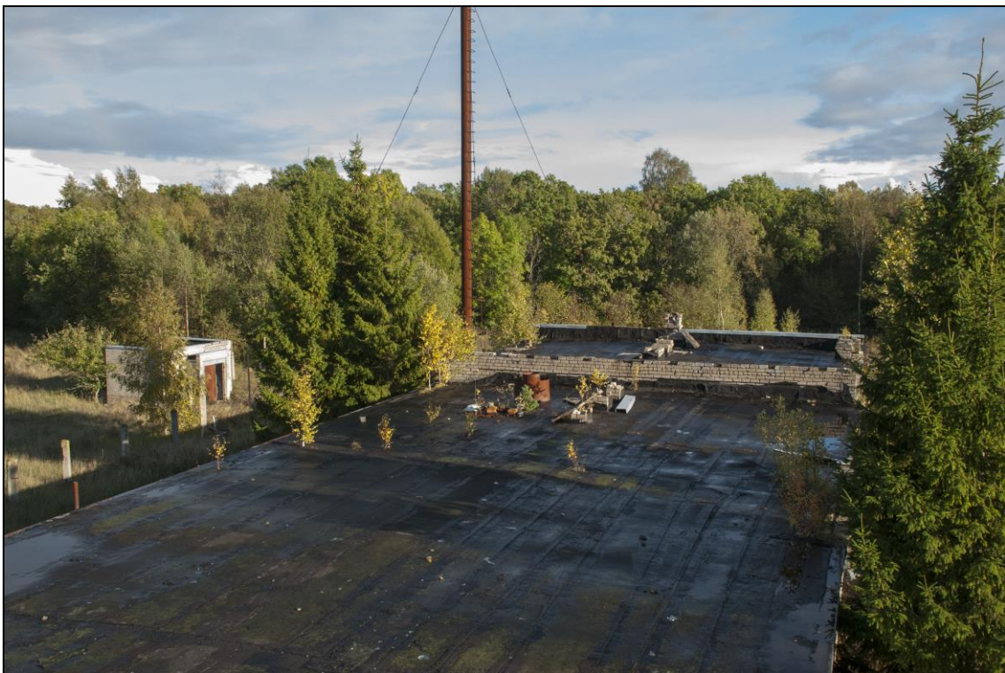
Foto 19. Tammuna kordon. Vaade peahoone [1] katuselt garaažidele [2] ja katlamajale [3], taga vasakul hoone [8].
