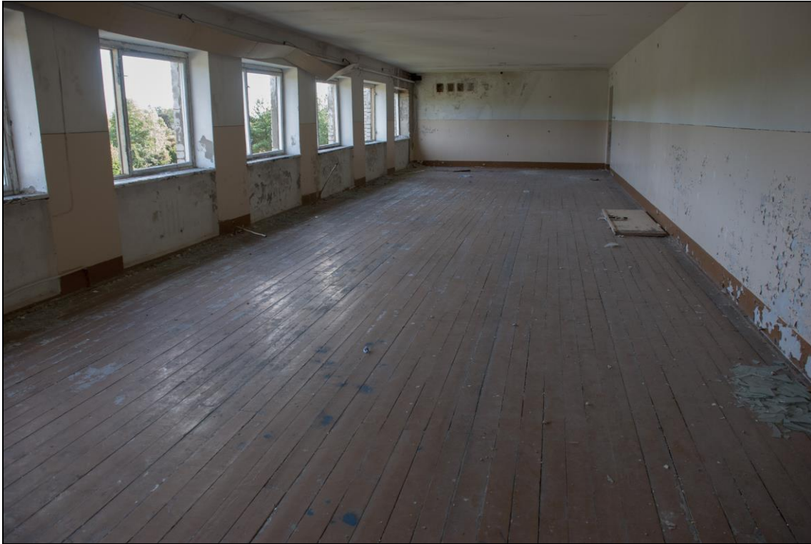
Foto 10. Tammuna kordon. Magala peahoone teisel korrusel. Katus veel peab, läbijooksu pole, põrandalauad on ka alles.
