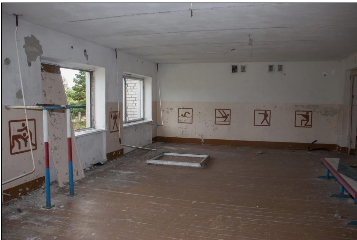
Foto 4. Tammuna kordon. Spordisaal peahoones [1] esimesel korrusel, osa metalltorudest sisseseadet on säilinud, radiaatorid kadunud. Foto Mart Mõniste 27.09.2013.
