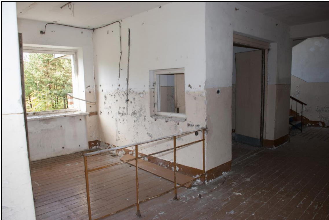
Foto 3. Tammuna kordon. Peahoone [1] sissepääs ja korrapidaja koht, taha paremal trepikoda. Foto Mart Mõniste 27.09.2013.
