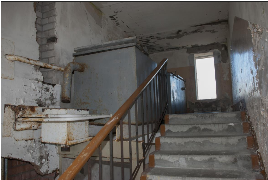
Foto 11. Tammuna kordon. Peahoone tagumine (sisehoovi poolne) trepikoda. Hoone kolmanda korruse moodustab väike väljaehitus katusel, kus asub küttesüsteemi paak. Paremal väljapääs katusele.
