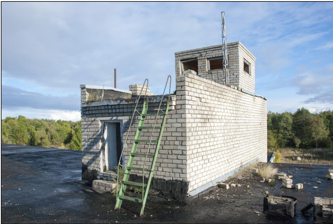
Foto 12. Tammuna kordon. Peahoone katusele küttesüsteemi paagiruumile on otsa ehitatud veel üks (neljas!) korrus - väike vaatluspost, selle kõrval raadiomast.
