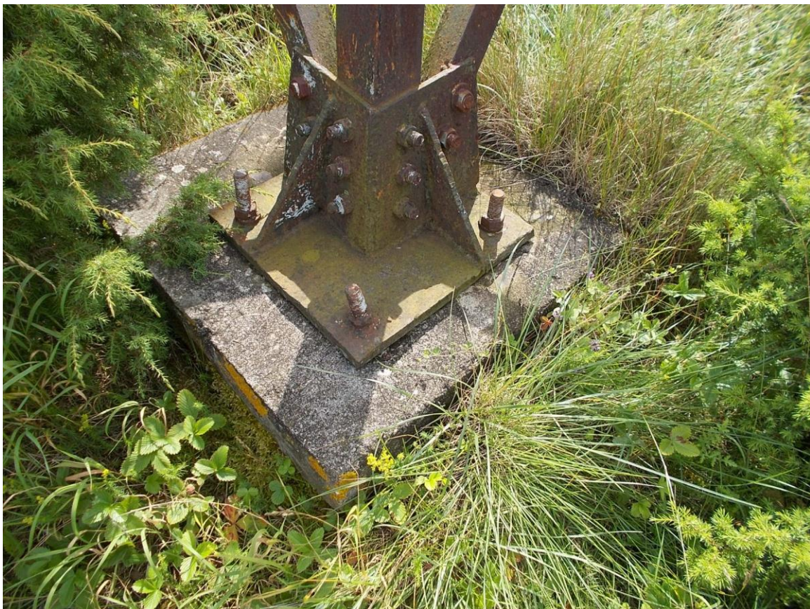
Foto 28. (106) Norrby tehnilise vaatluse post. Väike-Tjuka vaatlustorni [24] betoontallad (u 70x70 cm) on väga hästi säilinud. Foto Jüri Pärn 18.07.2015.
