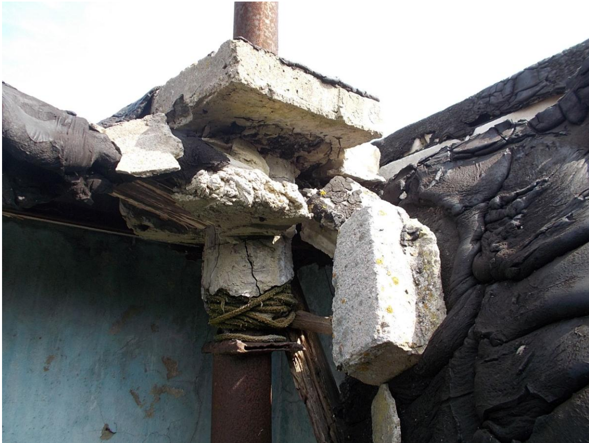
Foto 39. (136) Norrby tehnilise vaatluse post. Hoone [25] korsten läbi katuse. Foto Jüri Pärn 18.07.2015.
