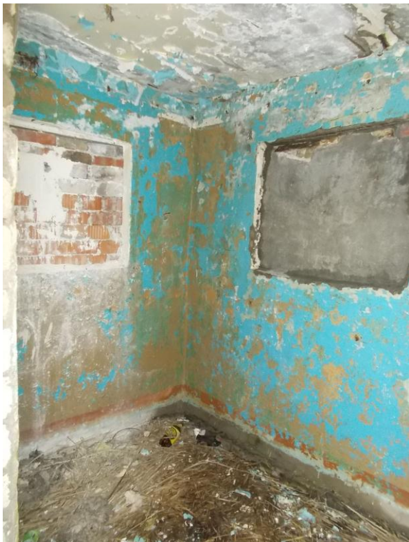
Foto 15. (42) Norrby tehnilise vaatluse post. Hoone [6] sisevaade. Foto Jüri Pärn 18.07.2015.
