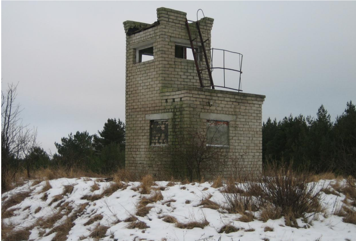
Foto 42. (20060109_0298.jpg) Norrby radiolokatsiooniposti hoone [6] 2006.a jaanuaris. Foto: Margus Hergauk 09.01.2006.
