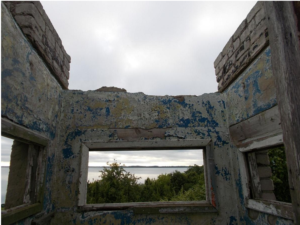
Foto 7. (13) Hoone [6], II korruse sisevaade. Katus on täiesti taastatav. Foto Jüri Pärn 18.07.2015.
