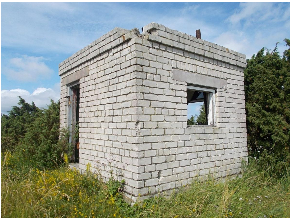
Foto 36. (144) Norrby tehnilise vaatluse post. Hoone [25], vaade kagust. Mõõtmed u 3,2x3,2x2,5 m. Foto Jüri Pärn 18.07.2015.
