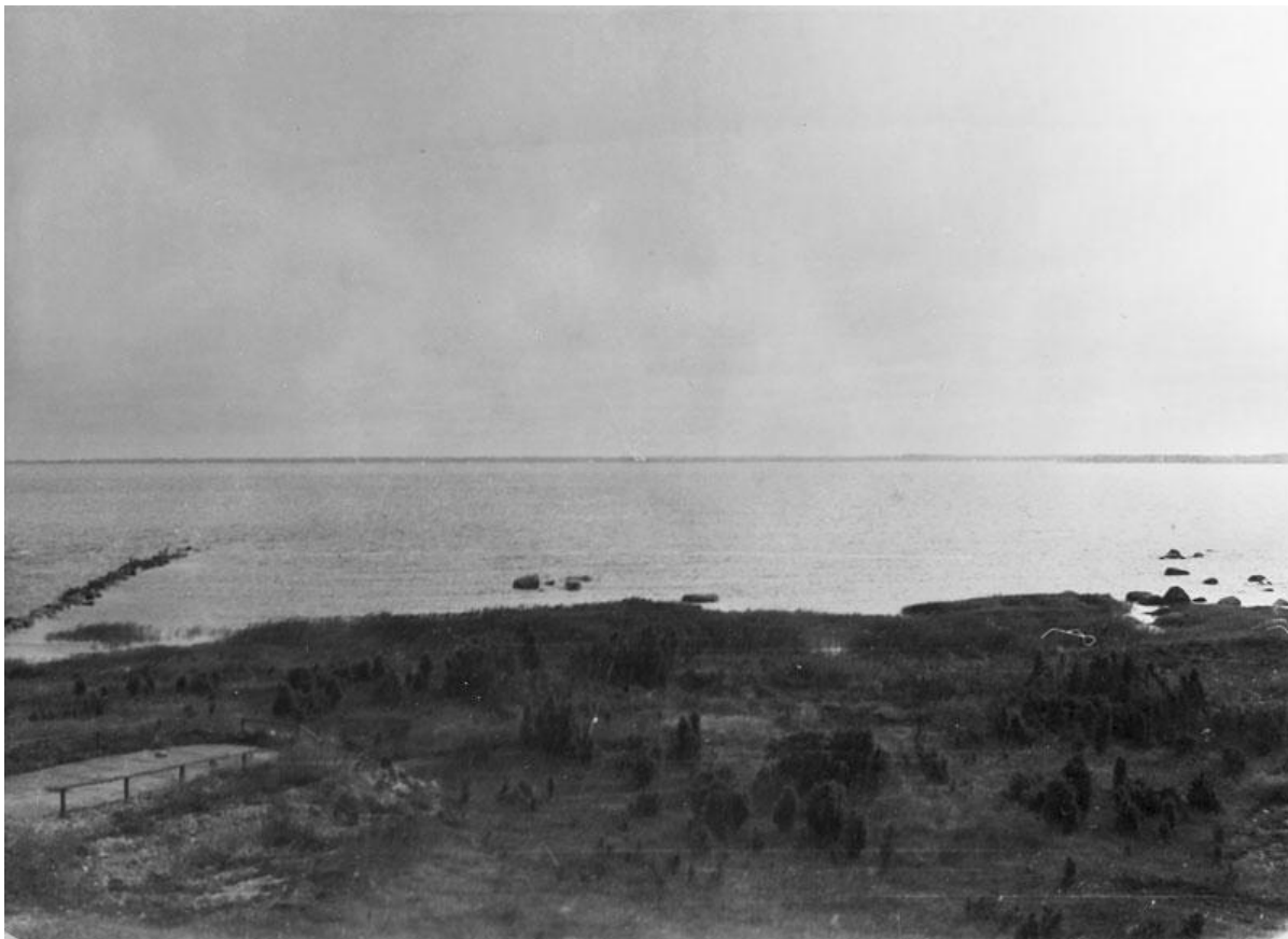
Foto 48. (norbivozikurk.jpg) Norrby raadiolokatsioonipost, pildistatud tornist [11] u 1985?.a. Vasakul betoonist prožektoripositsioon [7] käsipuudega. Allikas: http://vormsi-17.narod.ru/andrew_ph.html , Фотоальбом Андрея (teenistusaeg 1983–1985), vaadatud 28.09.2016.
