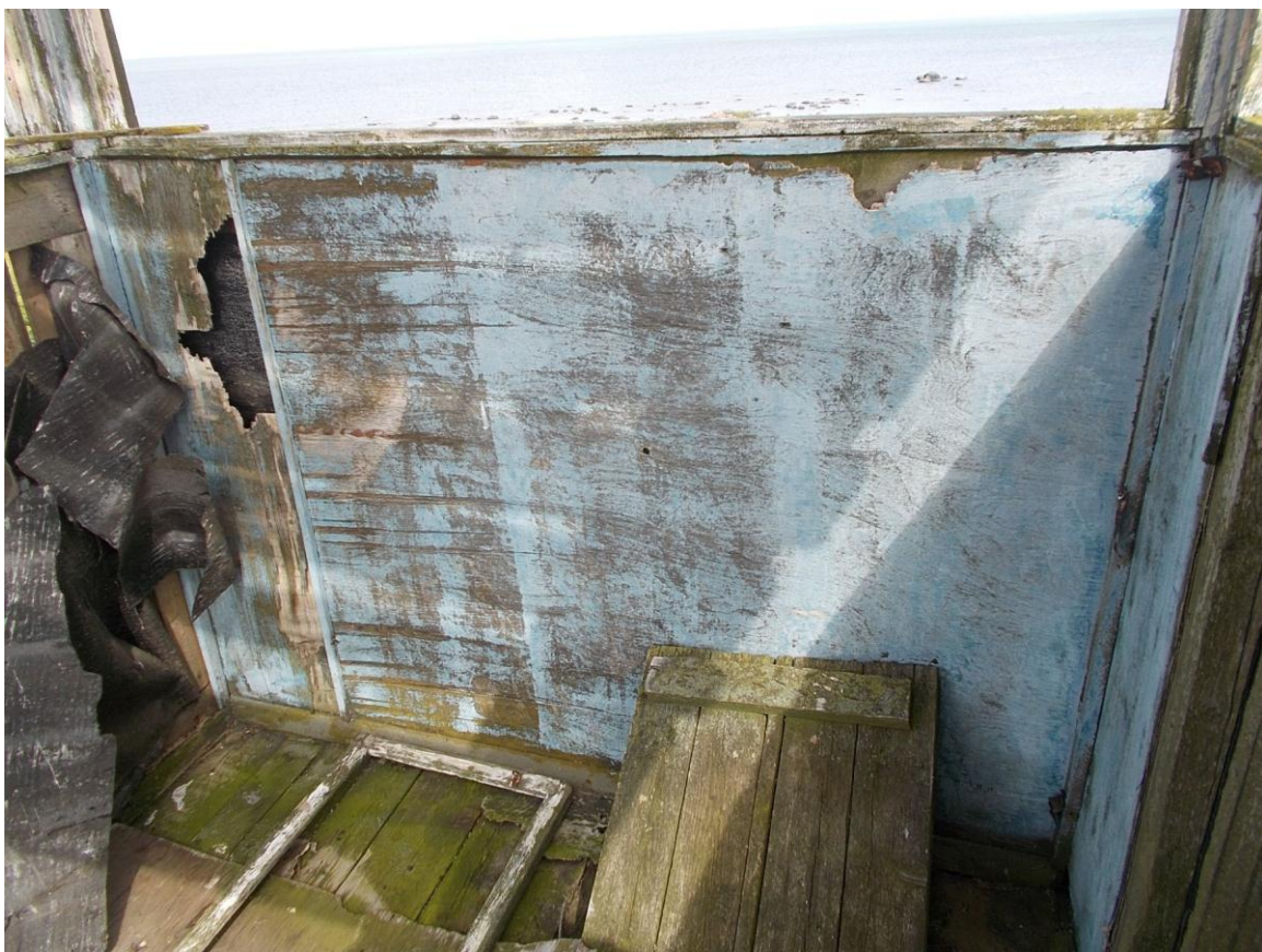
Foto 32. (162) Norrby tehnilise vaatluse post. Väike-Tjuka vaatlustorn [24]. Sisevaade (tõrvapapist tuuletõke, ilma soojustuseta, siseviimistluseks vineertahveldis, maas aknaraam, luuk oma kohal). Foto Jüri Pärn 18.07.2015.
