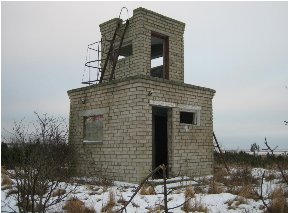
Foto 43. (20060109_0296.jpg) Norrby radiolokatsiooniposti hoone [6] 2006.a jaanuaris. II korruse katus on veel paigas, kuigi laetahveldis on veidi viltu vajunud. Foto: Margus Hergauk 09.01.2006.
