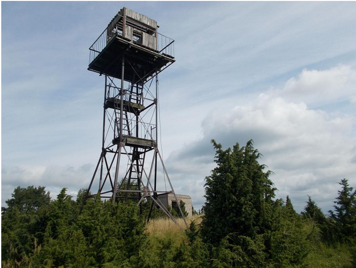
Foto 27. (104) Norrby tehnilise vaatluse post. Väike-Tjuka vaatlustorn [24] (kõrgus u 10 m), selle taga meeskonnahoone [25]. Tornil puuduvad pingutustrossid ja nende ankrud. Foto Jüri Pärn 18.07.2015.
