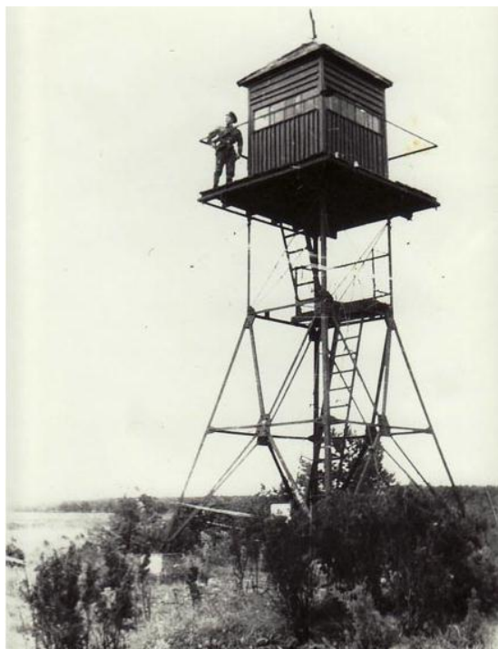
Foto 51. (page08.jpg) Norrby raadiolokatsiooni- ja prožektoripost u 1985? a. Tornil [11] ongi ainult üks vahekorros. Väike-Tjukale kolides (või veidi hiljem) lisati üks juurde. Pingutustrosse ei paista, võib-olla neid nii madalal tornil ei olnudki. Kuna aga Norrby sadama juures nende ankrud on olemas, on torn üsna tõenäoliselt olnud varasematel aegadel kõrgem. Allikas: http://vormsi-17.narod.ru/andrew_ph.html , Фотоальбом Андрея (teenistusaeg 1983–1985), vaadatud 27.09.2016.
