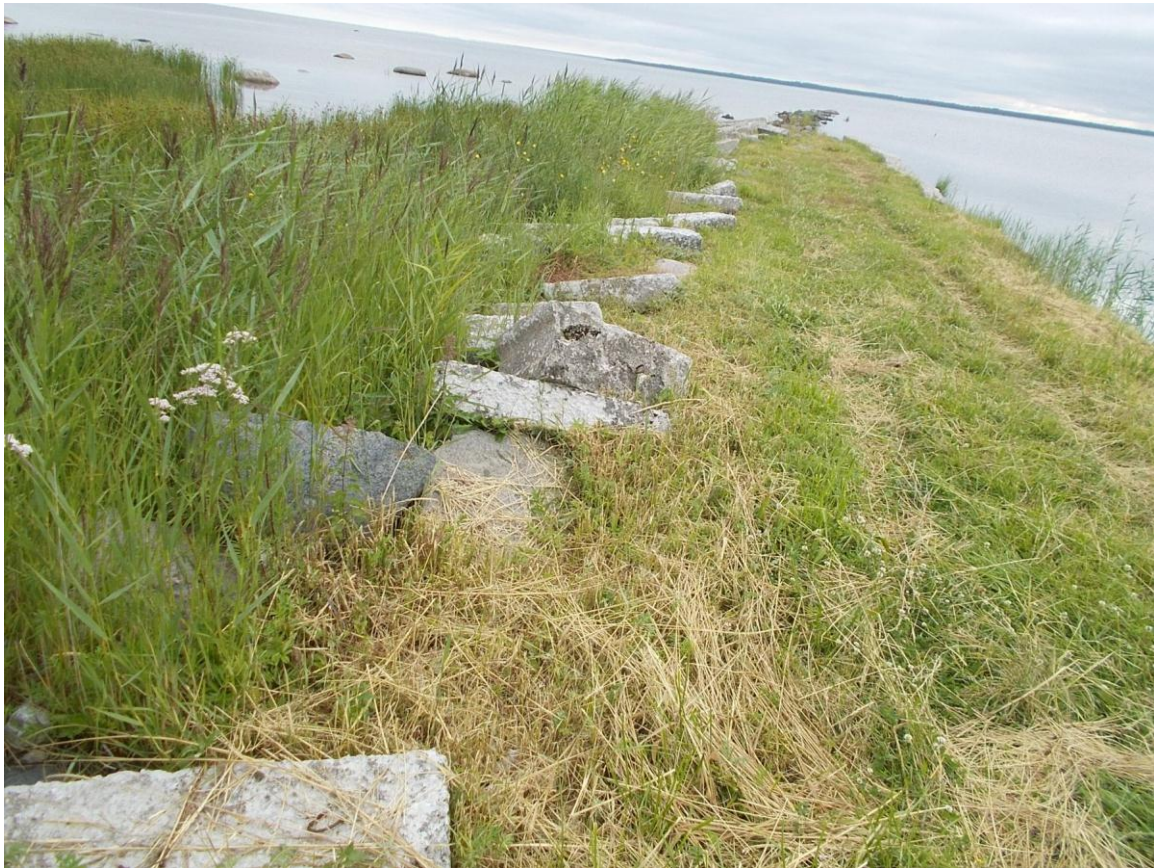
Foto 3. (66) Norrby tehnilise vaatluse post. Sadama muul [5a], mille äärde on veetud vanu vundamendiblokke. Foto Jüri Pärn 18.07.2015.
