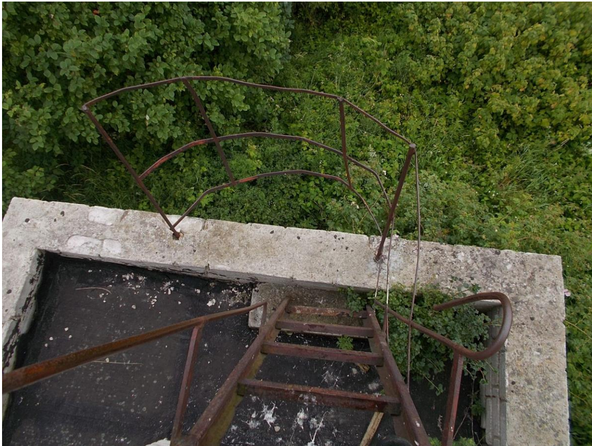
Foto 12. (28) Norrby tehnilise vaatluse post. Hoone [6], vaade II korruselt, trepist alla. Foto Jüri Pärn 18.07.2015.
