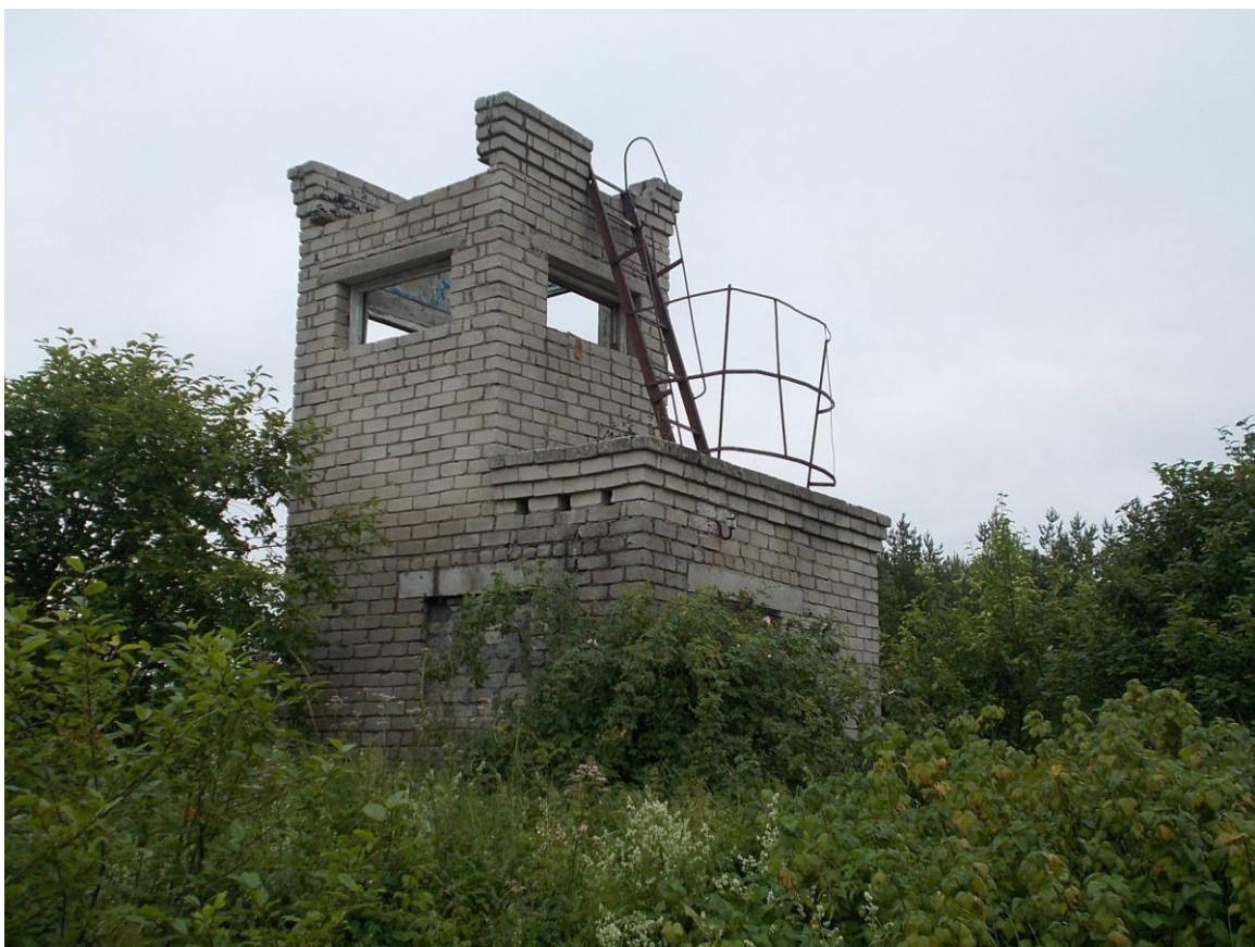
Foto 4. (65) Norrby tehnilise vaatluse post. Raadiolokatsiooniposti hoone [6] (u 3x3x6 m), vaade kirdest. I korruse aknad on kinni müüritud. Foto Jüri Pärn 18.07.2015.
