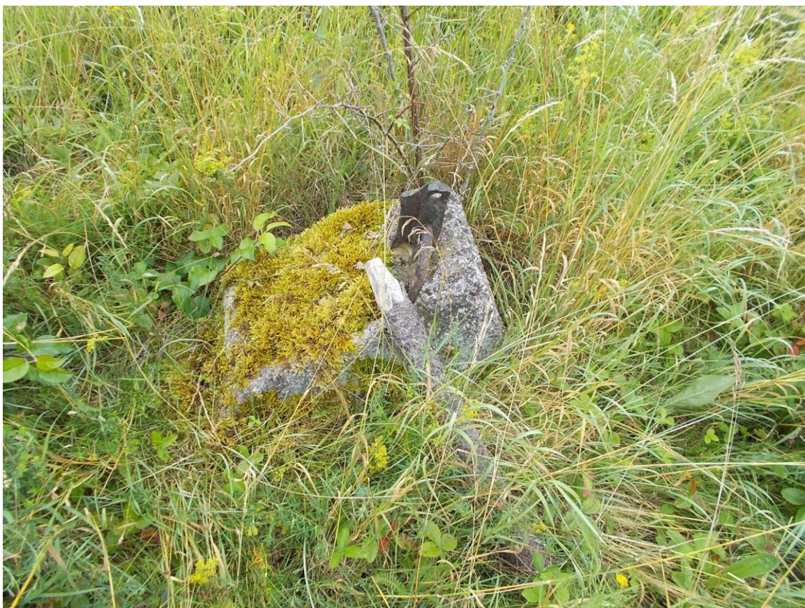
Foto 22. (53) Norrby tehnilise vaatluse post. Torni tõmmitsaankrud (4 tk) [12] on hästi säilinud. Foto Jüri Pärn 18.07.2015.
