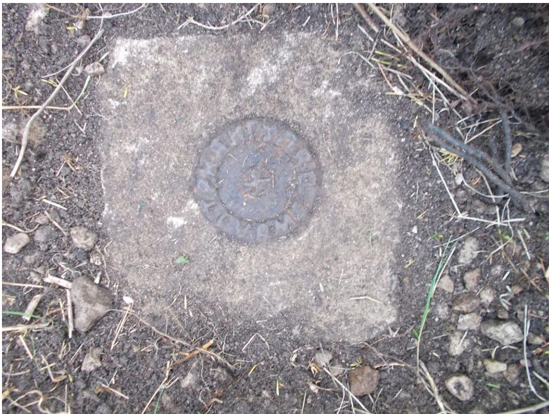
Foto 20. (69) Norrby tehnilise vaatluse post. Triangulatsioonipunkti [9] betoonposti tsentril on rist ja kiri „ТРИАНГУЛЯЦ. ГУВМС” (Merejõudude Hüdrograafiaavalitsuse triangulatsioon; rajatud tõenäoliselt 1950.-il). Tsentier oli 5–10 cm paksuse pinnasekihi ning põõsajuurte all. Foto Jüri Pärn 18.07.2015.
