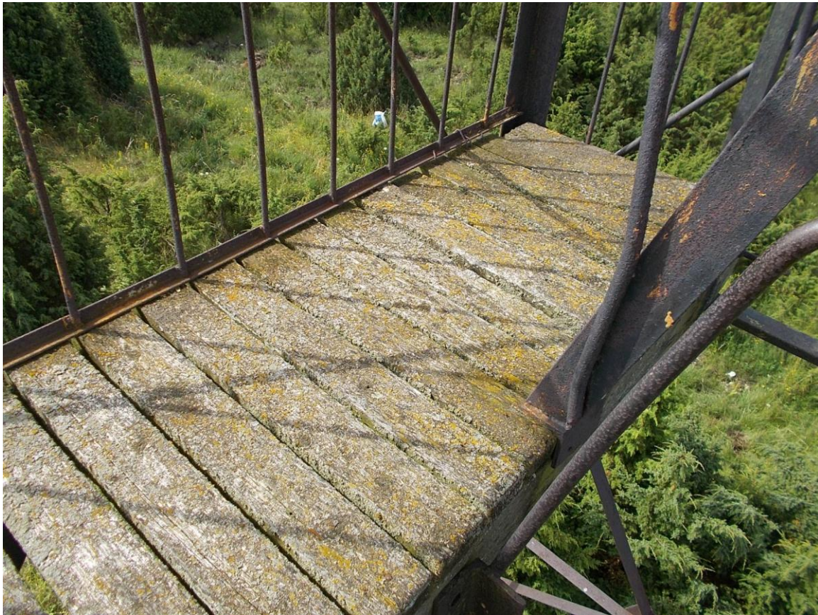
Foto 31. (151) Norrby tehnilise vaatluse post. Väike-Tjuka vaatlustorn [24]. Platvormide laudad on sammaldunud, kuid enamasti veel päris tugevad. Foto Jüri Pärn 18.07.2015.
