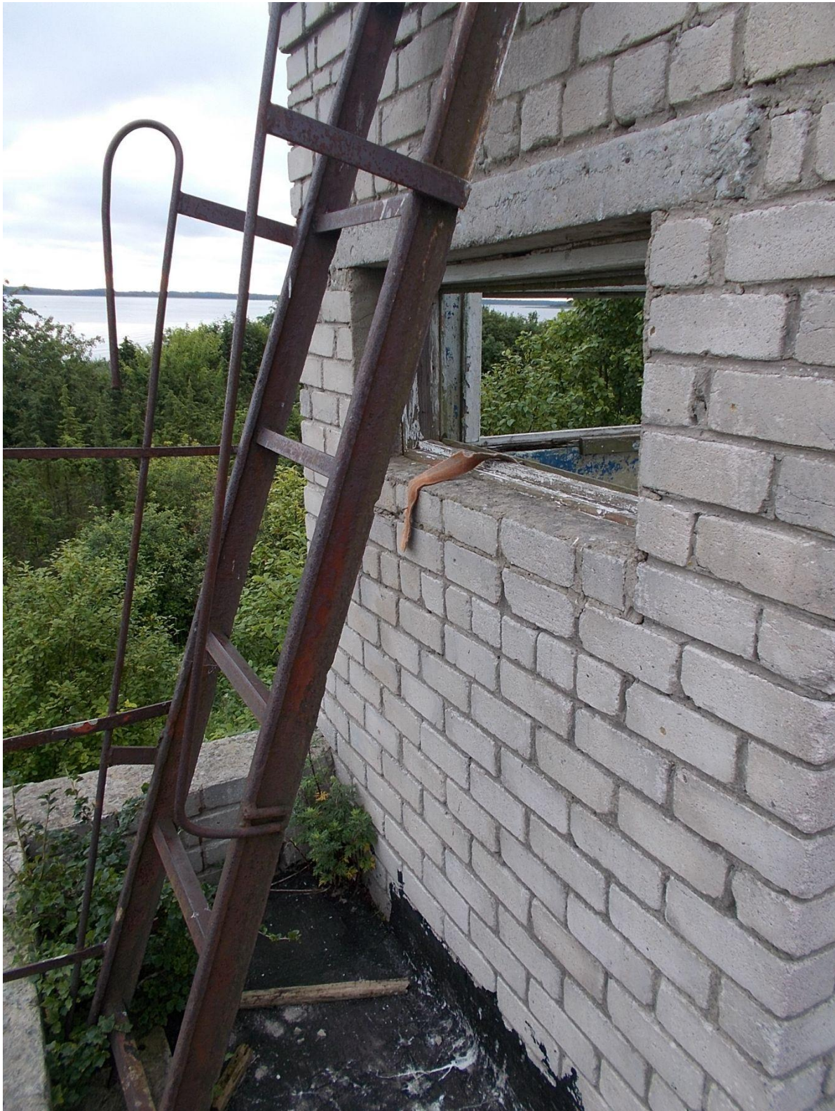
Foto 11. (20) Norrby tehnilise vaatluse post. Hoone [6] trepp II korruse katuse vaateplatvormile on valmistatud trammirööbastest. Foto Jüri Pärn 18.07.2015.
