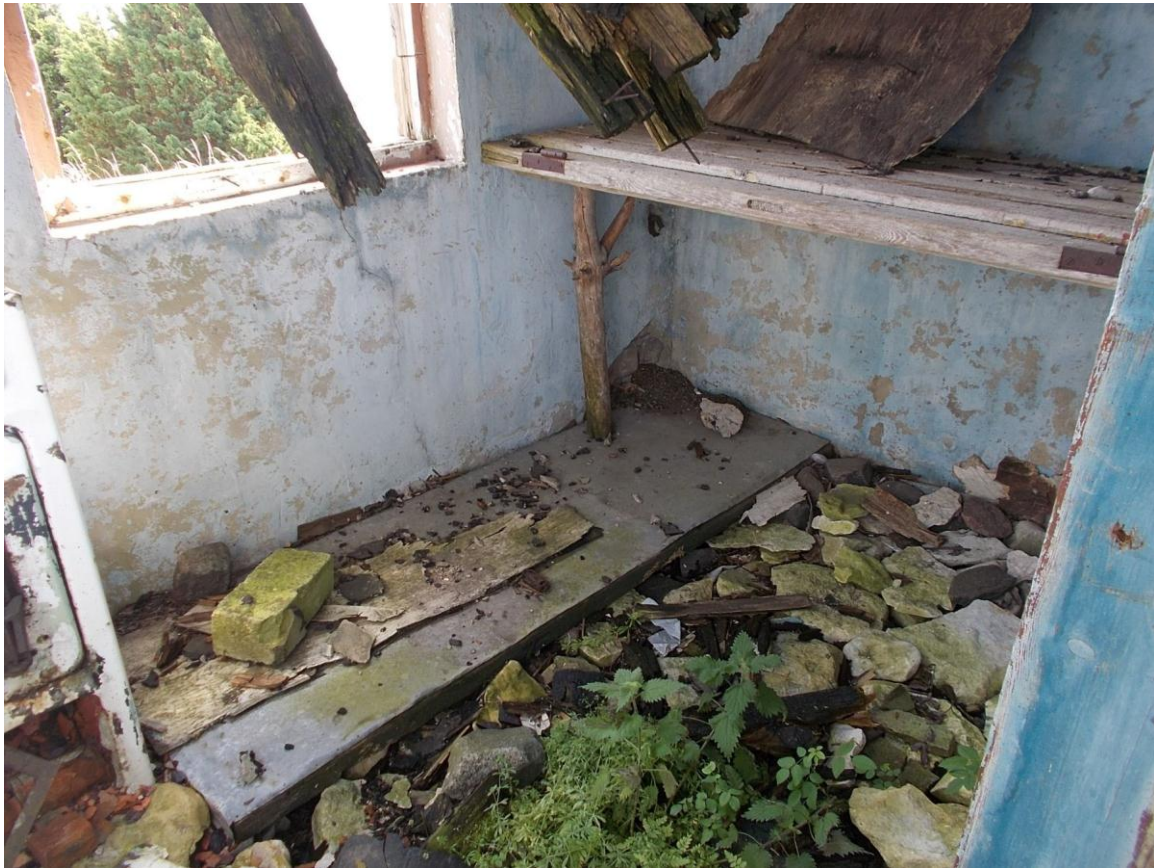
Foto 37. (130) Norrby tehnilise vaatluse post. Hoone [25] lõunaseina ääres on u 1 m kõrgusel uksest tehtud lavats. Foto Jüri Pärn 18.07.2015.
