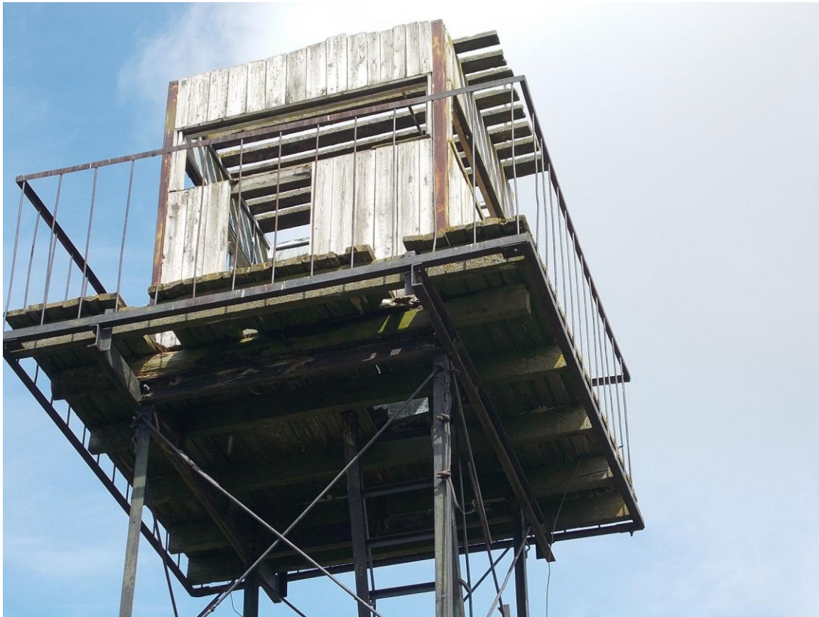
Foto 29. (116) Norrby tehnilise vaatluse post. Väike-Tjuka vaatlustorn [24]. Foto Jüri Pärn 18.07.2015.
