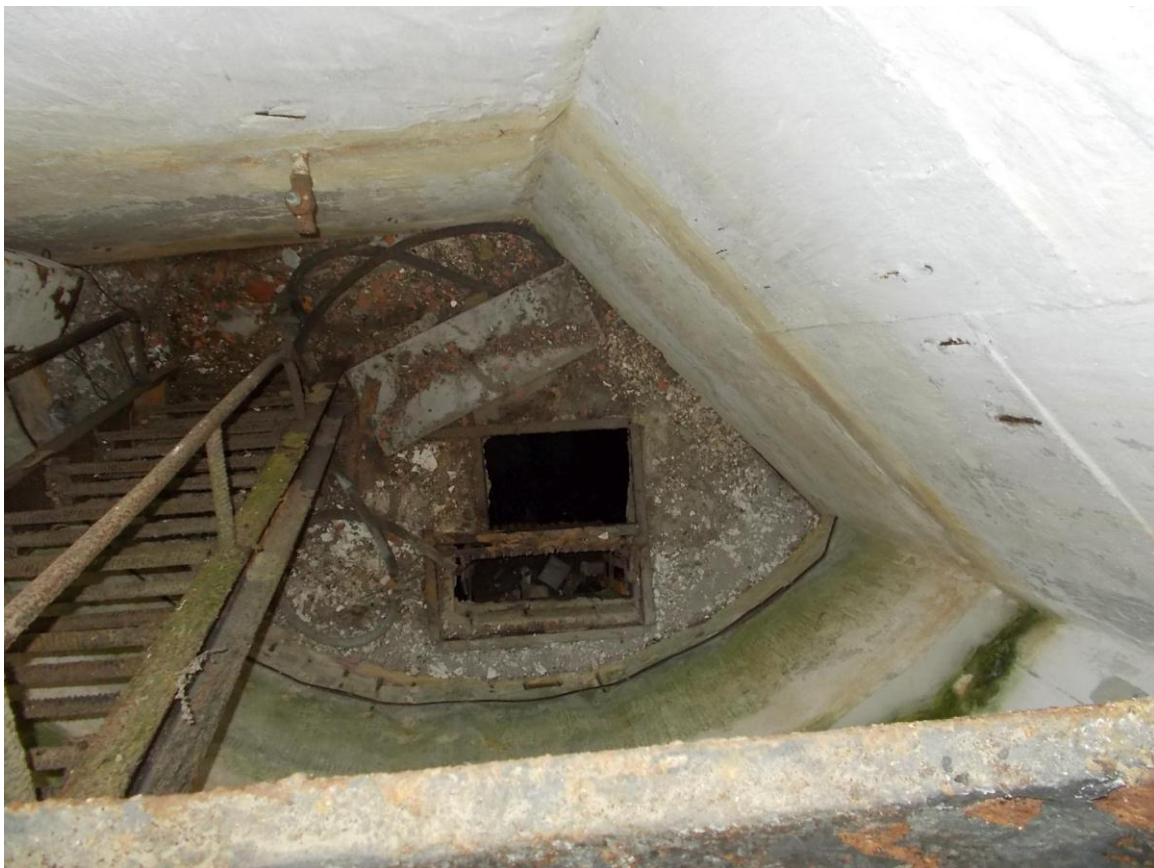
Foto 52. (507) Hullo piirivalvekordon. Kanalisatsiooni pumbamaja [20]. Hoone [1] (põhja-) poolne ruum: alla viib metalltrepp, põrandas on luugiavad. Foto Jüri Pärn 15.07.2015.
