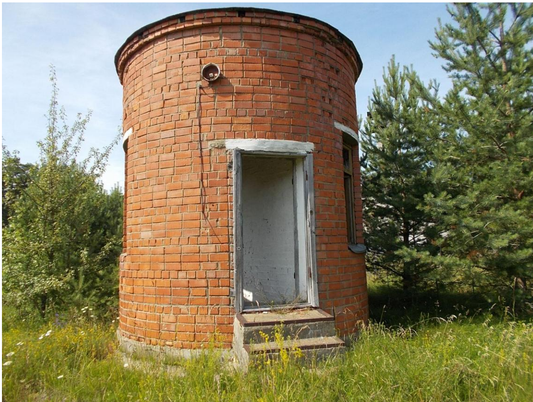
Foto 49. (483) Hullo piirivalvekordon. Kanalisatsiooni pumbamaja [20], arvatavasti toimis ka mingi puhastusseadmestikuna. Silindriline hoone koosneb kahest erineva suurusega sektorikujulisest ruumist. Seest suurem kui väljast: kummaski ruumis viib metalltrepp alumisele korrusele (vähemalt 2,5 m sügavusele), mille all on veel teadmata sügavusega reservuaar. Foto Jüri Pärn 15.07.2015.
