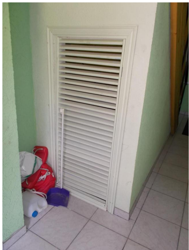
Foto 36. (53) Hullo piirivalvekordon. Elamu [6] keldrikorruse ukseava on sõrestikuna kinni ehitatud. Foto Jüri Pärn 15.07.2015.
