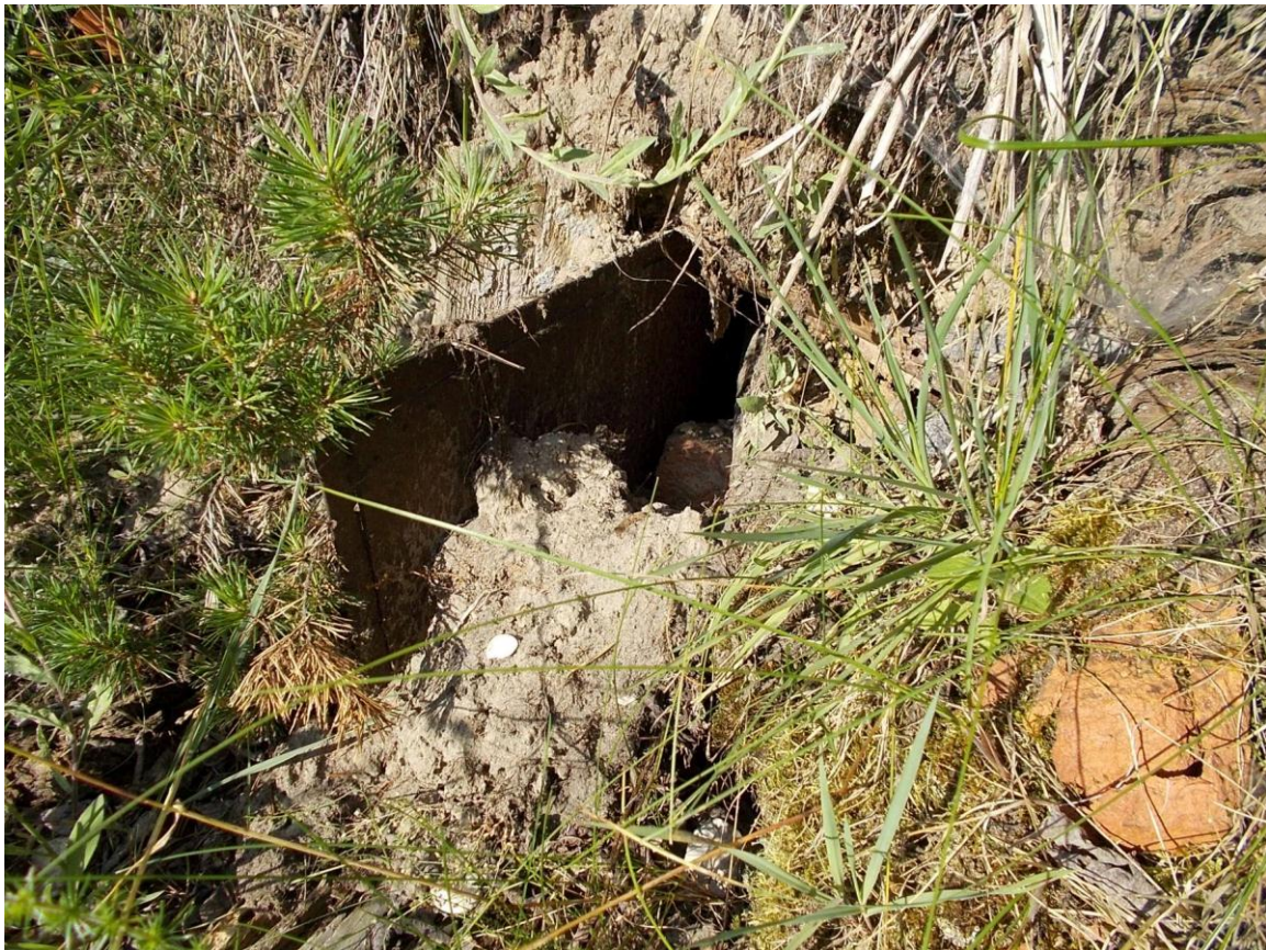
Foto 54. (1206) Hullo piirivalvekordon. Dott SPS-2 [23]. Tänu pinnase alla mattumusele on vähemalt üks doti luuk veel alles. Foto Jüri Pärn 15.07.2015.
