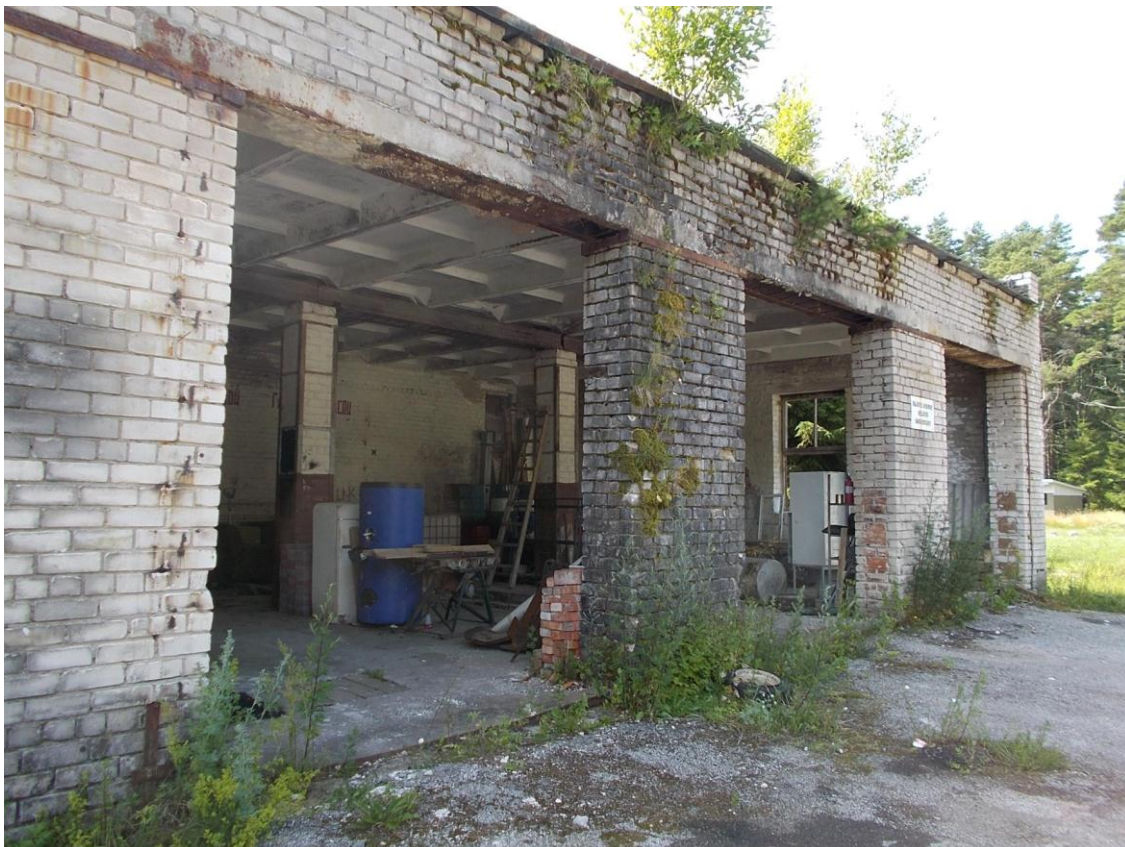
Foto 6. (597) Hullo piirivalvekordon. Hoone [1], vaade veoautogaraažile. Foto Jüri Pärn 15.07.2015.
