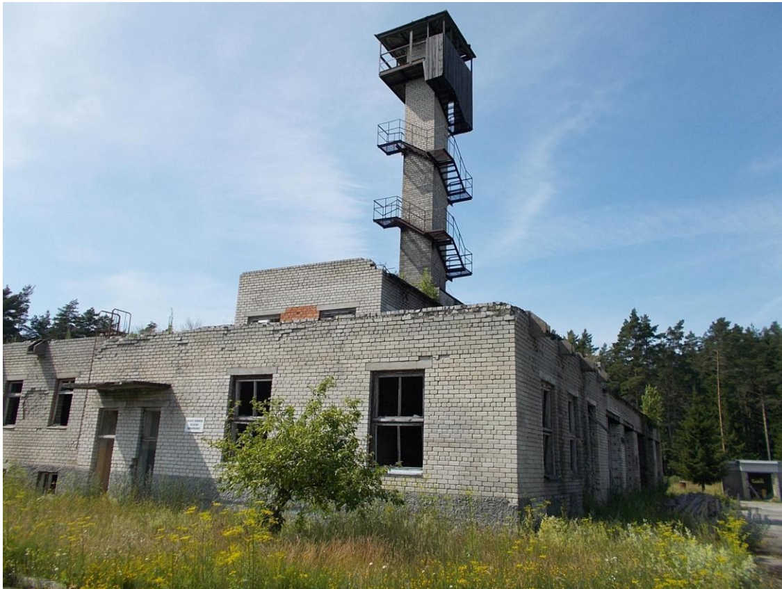
Foto 5. (540) Hullo piirivalvekordon. Hoone [1] vaade lõunast. Parempoolsest uksest saab vaheruumi kaudu katlamajja, vasakpoolsest pääseb soklikorrusele (vasakul pesu- ja tualettruumid, maja keskel spordisaal) ning trepikoja kaudu põhikorrusele. Ustest vasakul on metallredel katusele ronimiseks. Foto Jüri Pärn 15.07.2015.
