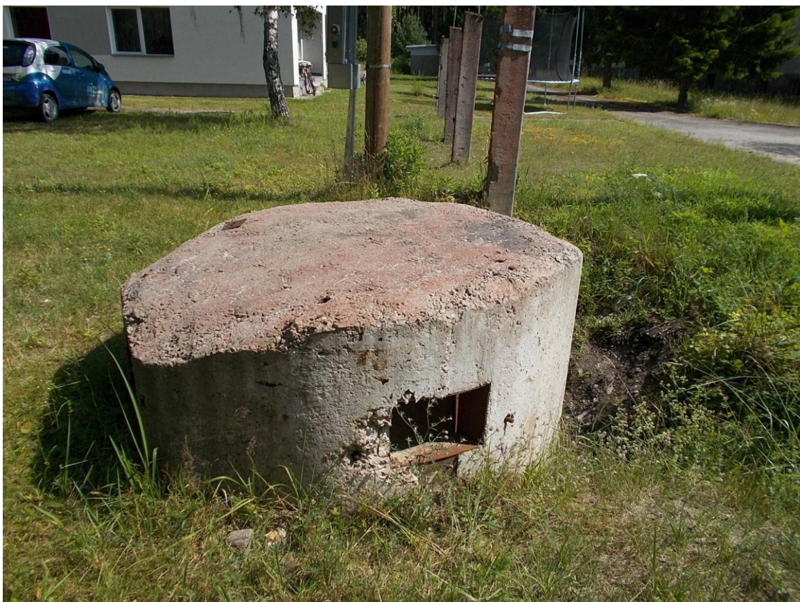
Foto 31. (100) Hullo piirivalvekordon. Dott SPS-2 [3]. „Pealagi” on välja puhastatud ja betoondetailist moodustatud esik eemaldatud (vrd fotod 79 ja 61). Foto Jüri Pärn 15.07.2015.
