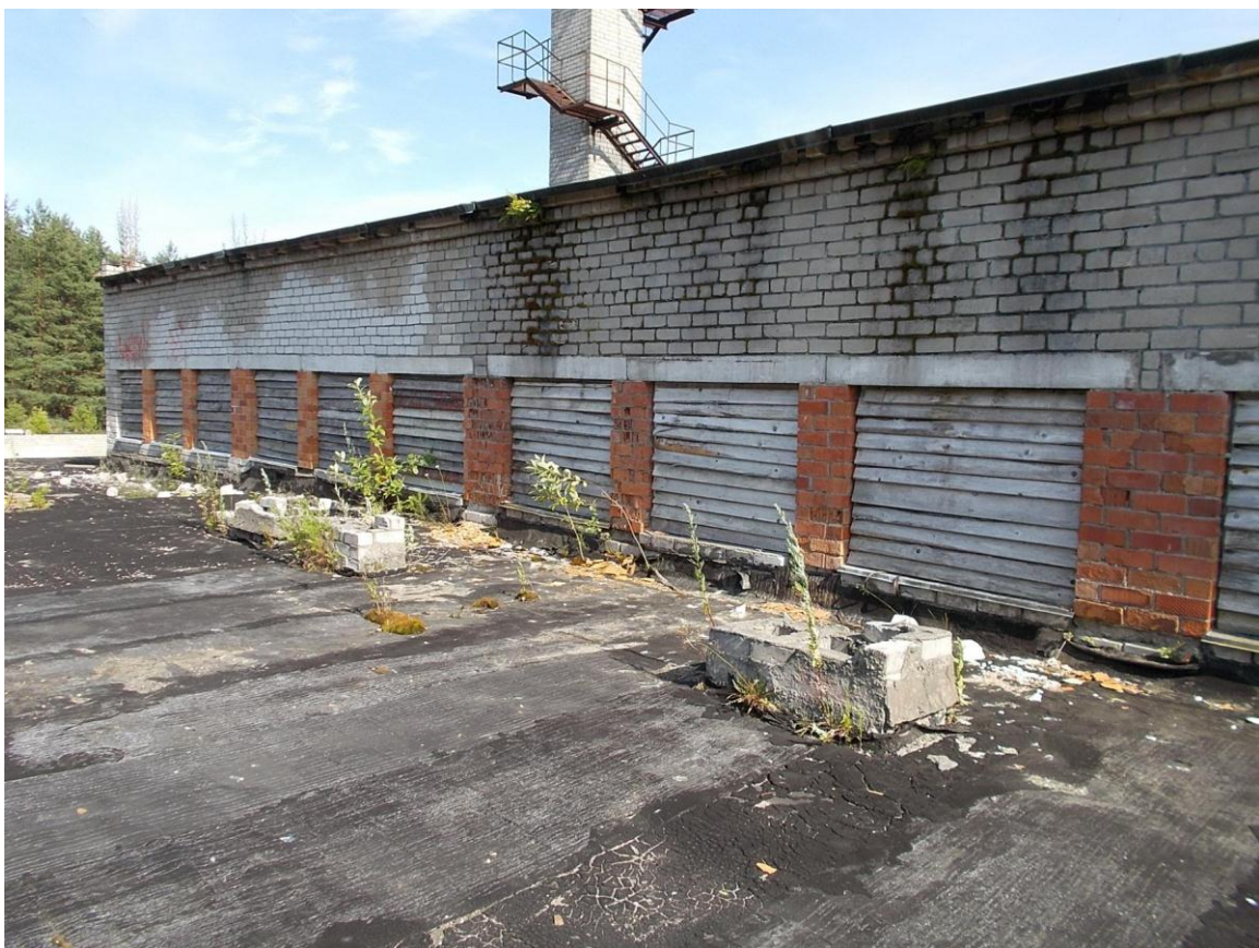
Foto 21. (972) Hullo piirivalvekoridon. Hoone [1] kõõgibloki ventilatsioonivad ja saalide aknad. Foto Jüri Pärn 15.07.2015.
