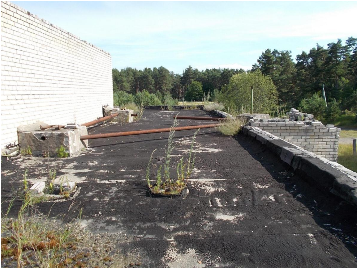
Foto 22. (958) Hullo piirivalvekordon. Hoone [1] põhikorruse katuse lääneküljel on betoonalused kahe raadiomasti jaoks. Nende tõmmitsad olid kinnitatud saalide katusele (pingutid on veel alles). Paremal lipuvarda? alus. Foto Jüri Pärn 15.07.2015.
