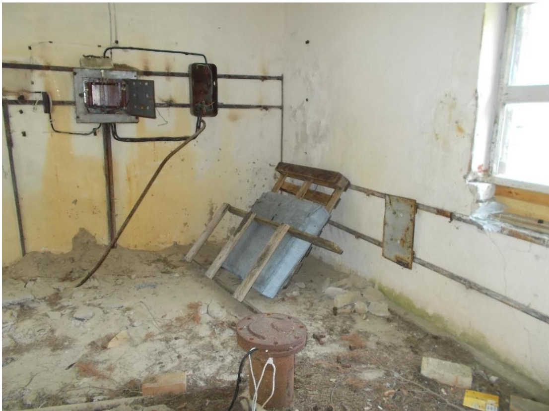
Foto 64. (328) Hullo piirivalvekordon. Pumbamaja [50] sisevaade. Esiplaanil toimiv puurkaev. Foto Jüri Pärn 15.07.2015.
