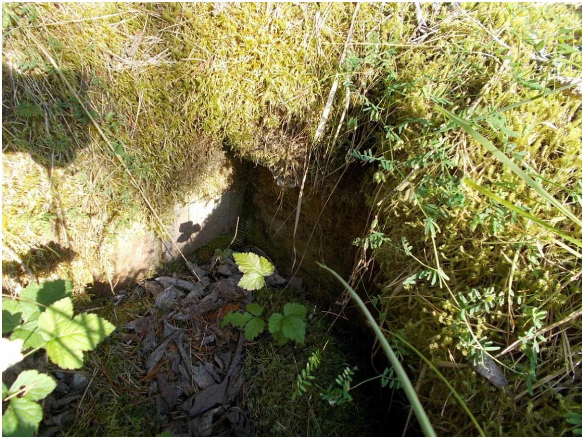
Foto 56. (1179) Hullo piirivalvekordon. Vana kordoni sauna vundament [24]. Hoone [1] poolses nurgas on väike betoonkaev. Sauna ümbruses leidub erinevaid kaeveid ja täketega puid. Foto Jüri Pärn 15.07.2015.
