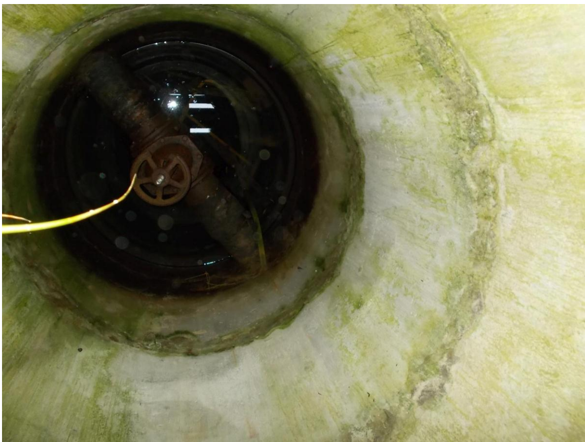
Foto 48. (527) Hullo piirivalvekordon. Siibriga kommunikatsioonikaev [19] pumbamaja [20] kõrval, vesi sees. Foto Jüri Pärn 15.07.2015.
