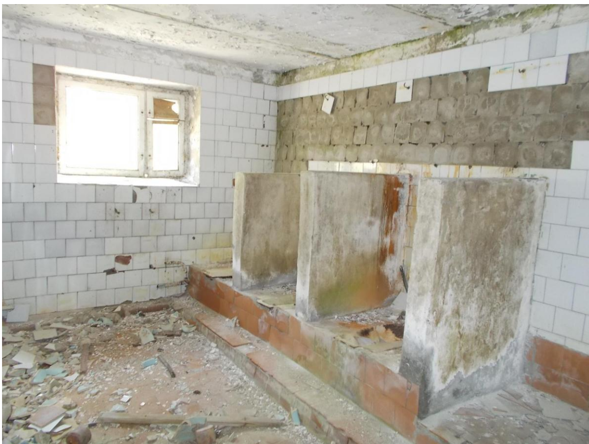
Foto 8. (660) Hullo piirivalvekordon. Hoone [1] WC soklikorrusel, põrand u 1 m allpool maapinda. Foto Jüri Pärn 15.07.2015.
