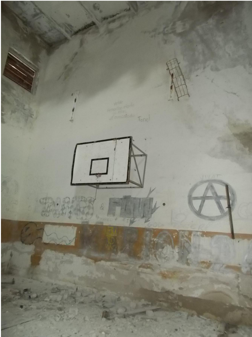
Foto 9. (675) Hullo piirivalvekordon. Hoone [1] keskel on u 8 m kõrgune täismõõdus korvpallisaal. Peale sõjaväelaste lahkumist kasutasid seda kohalikud, ent põrand mädanes varsti ära. Põhjuseks öeldakse olevat asjaolu, et hoone solgivesi tuli pumbata üle mäe merre, süsteem lakkas aga töötamast ning solk ujutas korduvalt spordisaali üle. Foto Jüri Pärn 15.07.2015.
