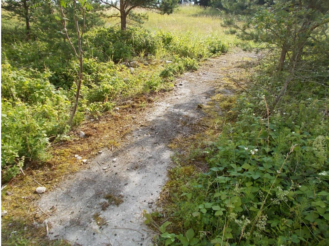
Foto 10. (205) Borrby tehnilise vaatluse post. Betoonkõnnitee [15] peahoonest [16] jälgväravani. Vasakul u 2x2 m laiend, millel on mingi väikeehitise tükid? (Sama, mis on fotol 39?) Foto Jüri Pärn 16.07.2015.
