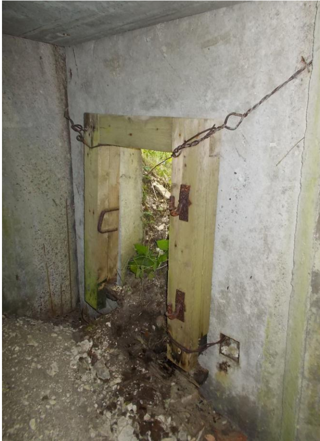
Foto 7. (91) Keskmine dott [12], sisevaade. Leng on terve ning algsel kohal. Foto Jüri Pärn 16.07.2015.
