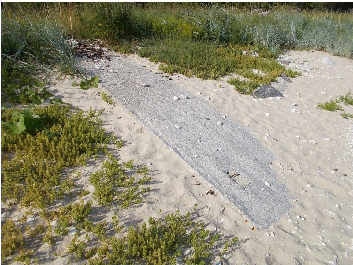
Foto 25. (316) Borrby tehnilise vaatluse post. Betoonpaneel [22] liiva sees, postist [20] 10 m läänes, mõõtmetega 5,5x1 m, paksus üle 15 cm. Vana prožektoripositsiooni osa? Foto Jüri Pärn 16.07.2015.
