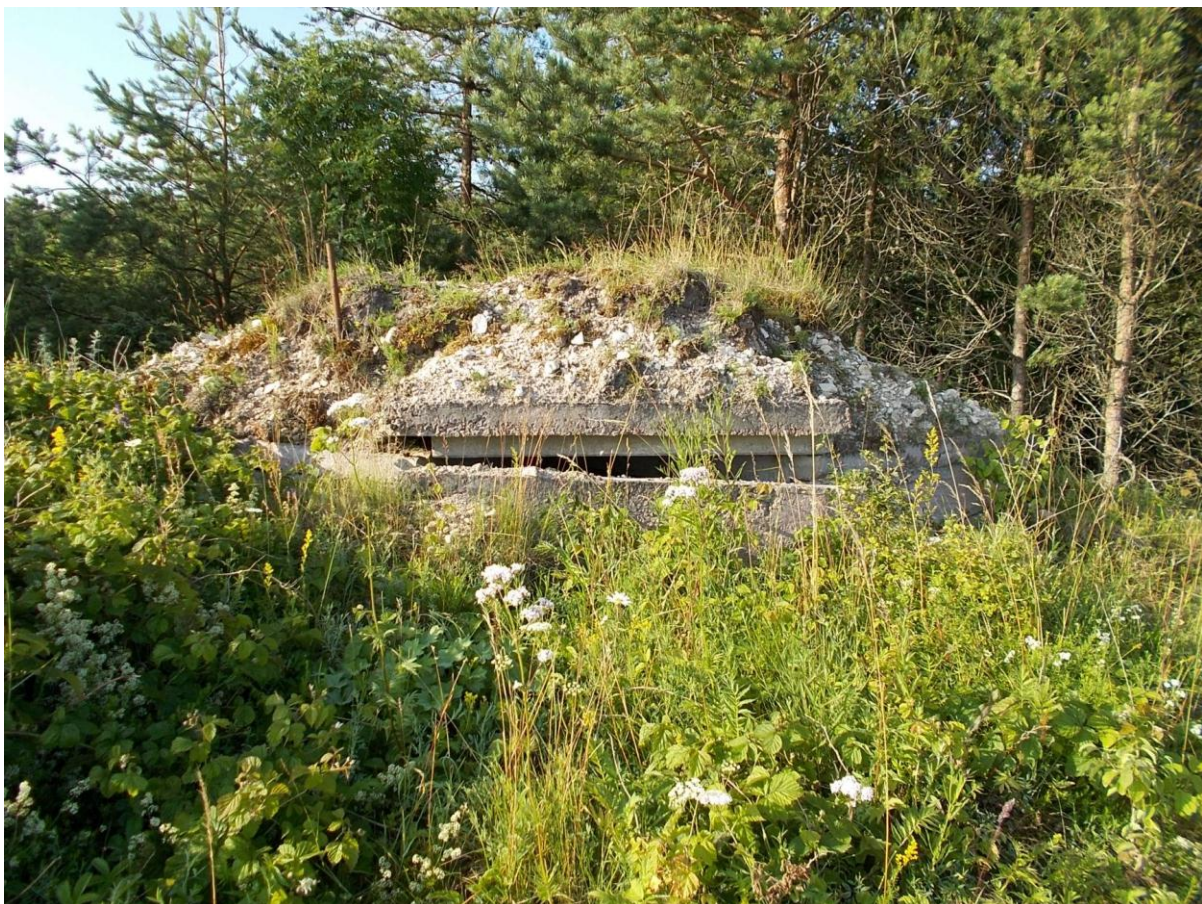
Foto 6. (74) Borrby tehnilise vaatluse post. Keskmine dott [12], merepoolne vaade. Ka siin on keskmine esipaneel vajunud? Foto Jüri Pärn 16.07.2015.
