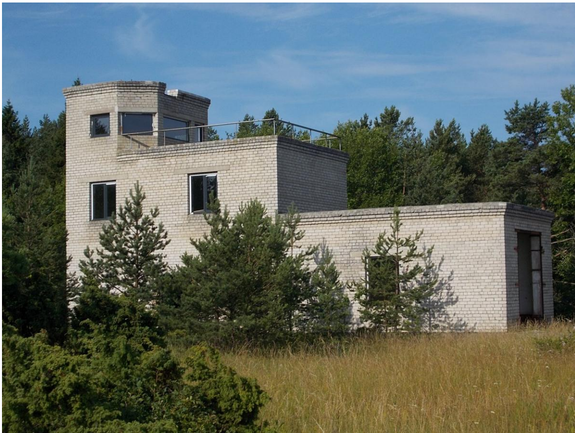
Foto 17. (337) Borby tehnilise vaatluse post. Komplekshoone [16] vaade kirdest. Rõdupiire on asendatud, karniis ära parandatud. Foto Jüri Pärn 16.07.2015.
