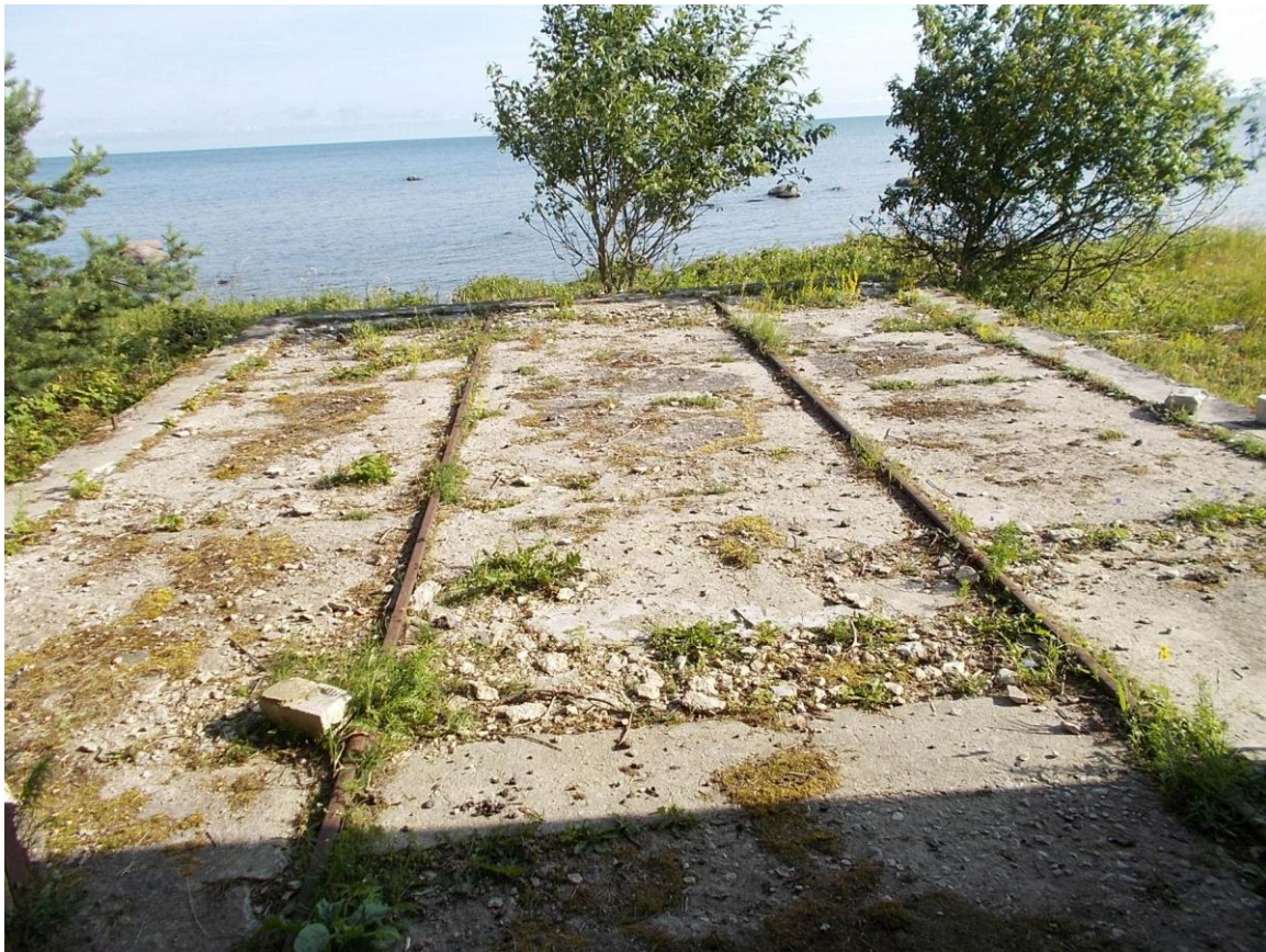
Foto 15. (254) Borrby tehnilise vaatluse post. Komplekshoone [16] relssidega projektoripositsioon (BP-200 jaoks). Platsi ümbritsenud metallpiire on ärastatud. Foto Jüri Pärn 16.07.2015.
