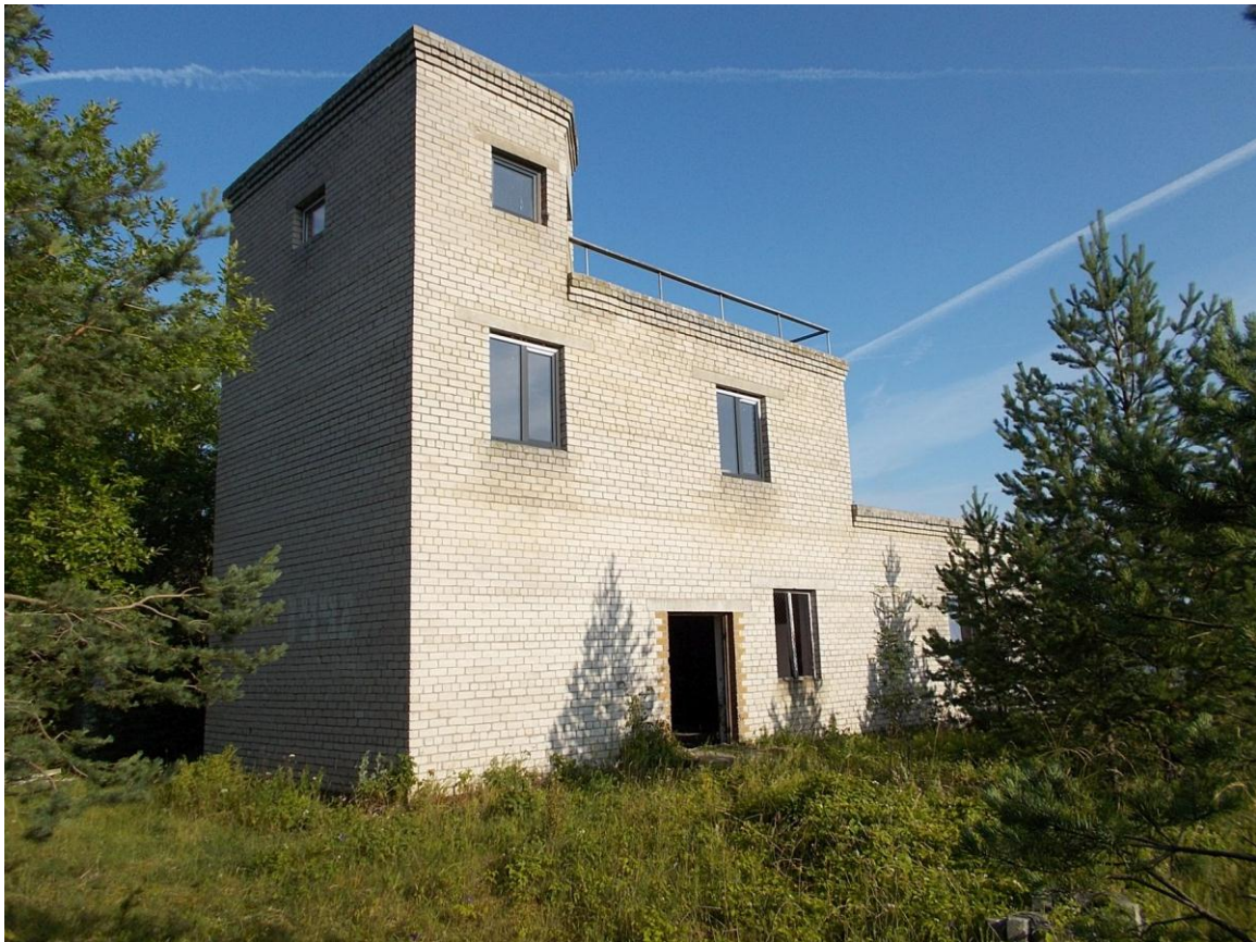
Foto 11. (128) Borrby tehnilise vaatluse post. Komplekshoone [16] (radari-, diisli- ning prožektorihooned) vaade kagust. Lõunaseinal suurelt aastaarv 1992. Foto Jüri Pärn 16.07.2015.
