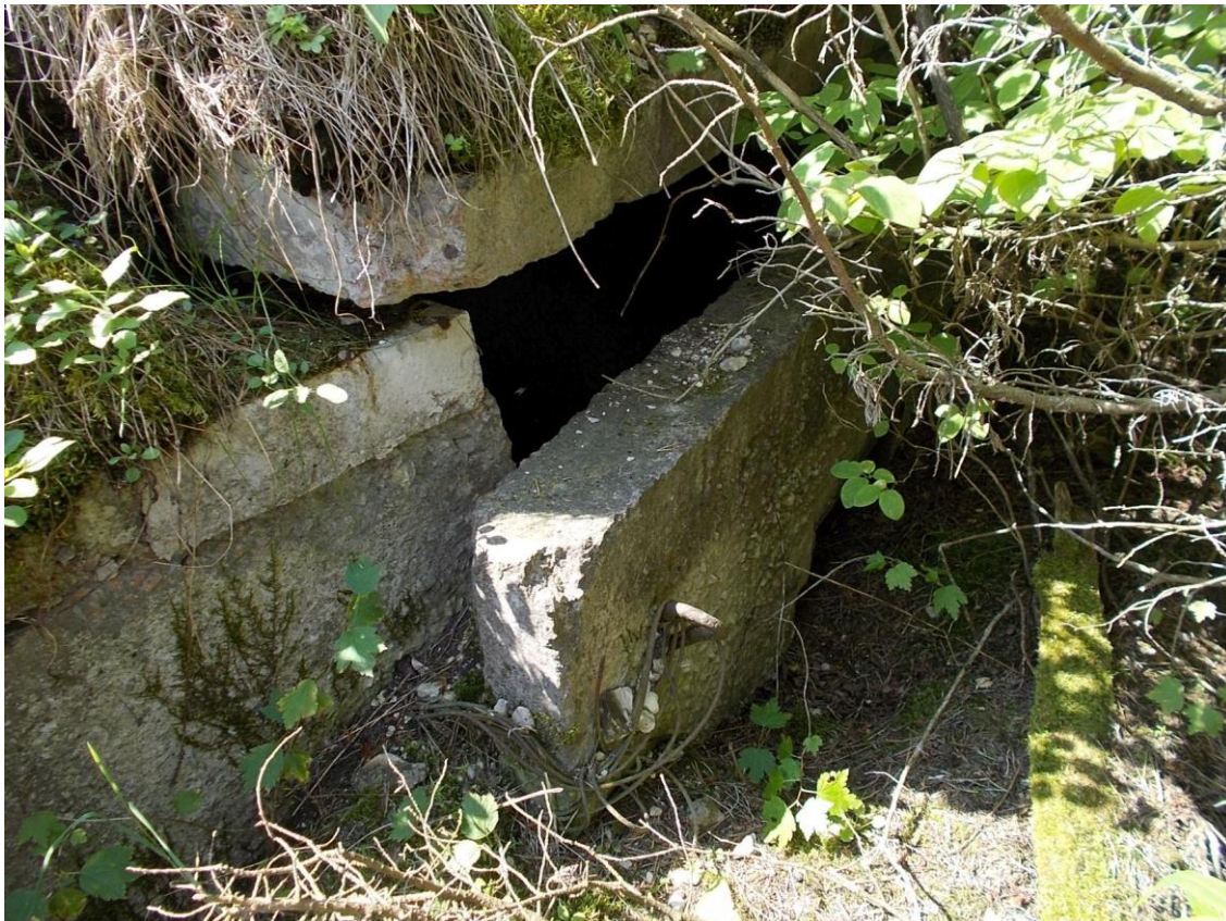
Foto 2. (618) Borrby tehnilise vaatluse post. Idapoolne dott [5], lähivaade idast (mere poolt). Keskmine esipaneel on vajunud? Foto Jüri Pärn 16.07.2015.
