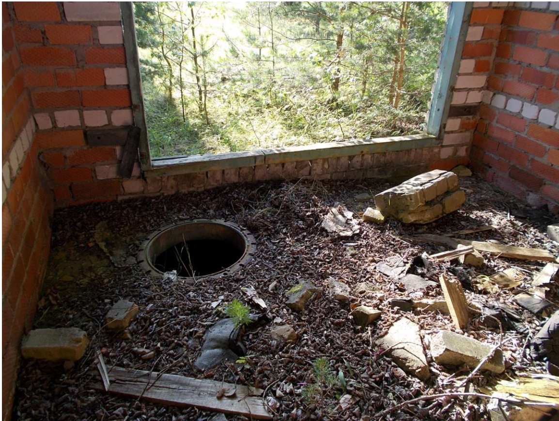
Foto 20. (182) Borrby tehnilise vaatluse post. Kütuse- ja määrdeainehoidla [17] sisevaade. Seinal on kiri „Vastutav Kovaljov” (fail 183, siin ära toomata). Põrandas reservuaariava. Foto Jüri Pärn 16.07.2015.
