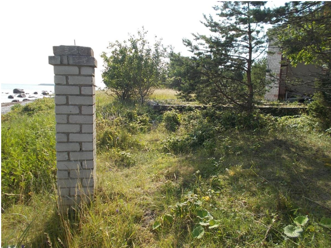
Foto 23. (314) Borrby tehnilise vaatluse post. Ainuke säilinud piirdeaiapost [20] (aia loodenurgas). Ülejäänud on lammutatud ja nende tükid vedelevad maas. Posti tipus keskel on varras signalisatsioonitraadi isolaatori jaoks. Foto Jüri Pärn 16.07.2015.
