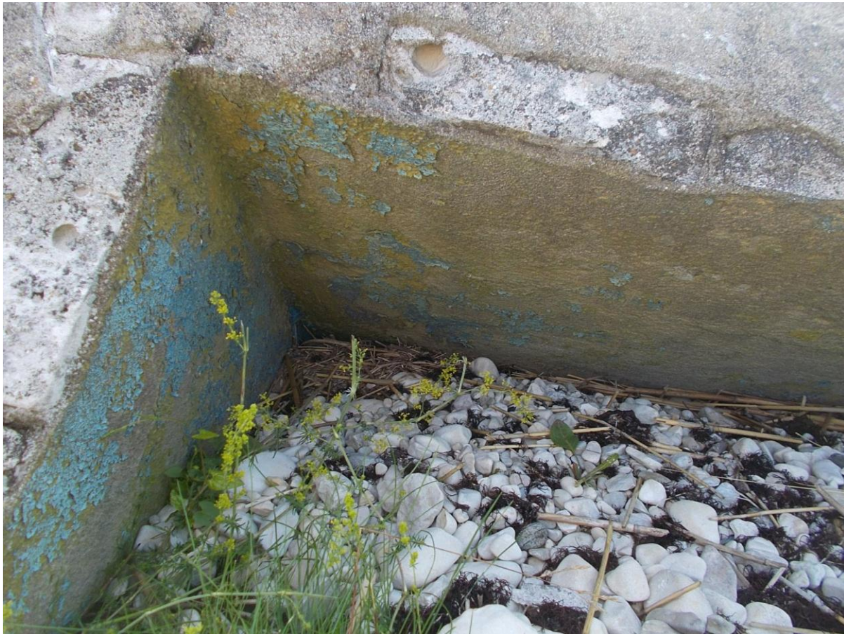
Foto 5. (57) Borrby tehnilise vaatluse post. Silikaatkivihoone [10] nurgatükk. Seest on seinad krohvitud ja korduvalt värvitud (originaalvärv on veel säilinud). Foto Jüri Pärn 16.07.2015.
