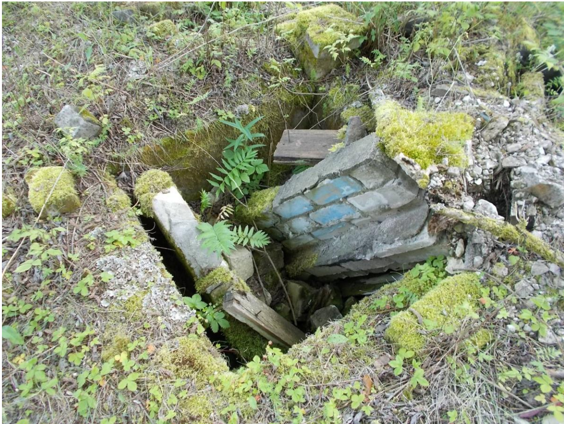
Foto 22. (164) Borrby tehnilise vaatluse post. Teadmata otstarbega u 1x1 m suurune lammutatud seintega hoone [19]. Põhjas üle 0,5 m sügavune betoneeritud süvend. Foto Jüri Pärn 16.07.2015.
