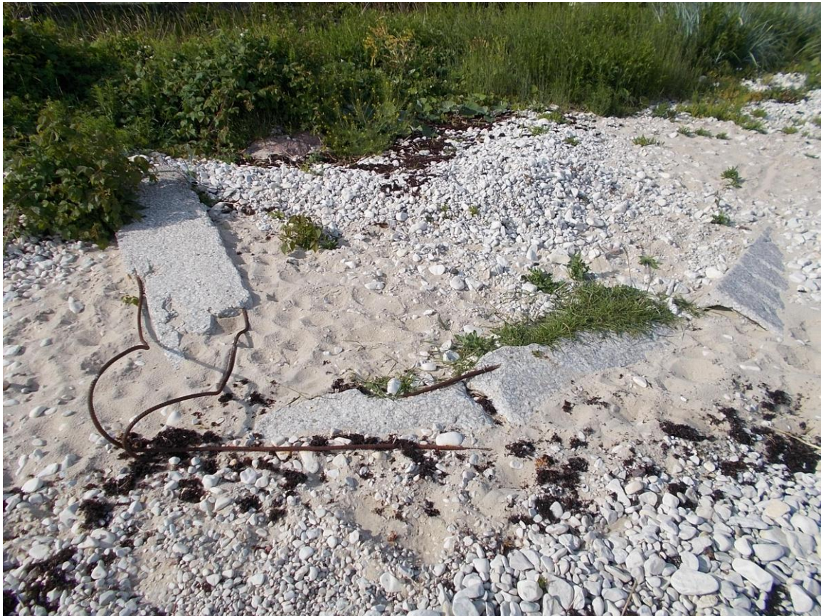
Foto 24. (324) Borrby tehnilise vaatluse post. U-kujuliselt murdunud betoonpaneel [21] liiva sees, prožektoripoodiumi esisel rannal, postist [20] u 10 m idas. Mõõtmed u 7x0,4 m, d vähemalt 15 cm. Mingi ehitise osa? Foto Jüri Pärn 16.07.2015.
