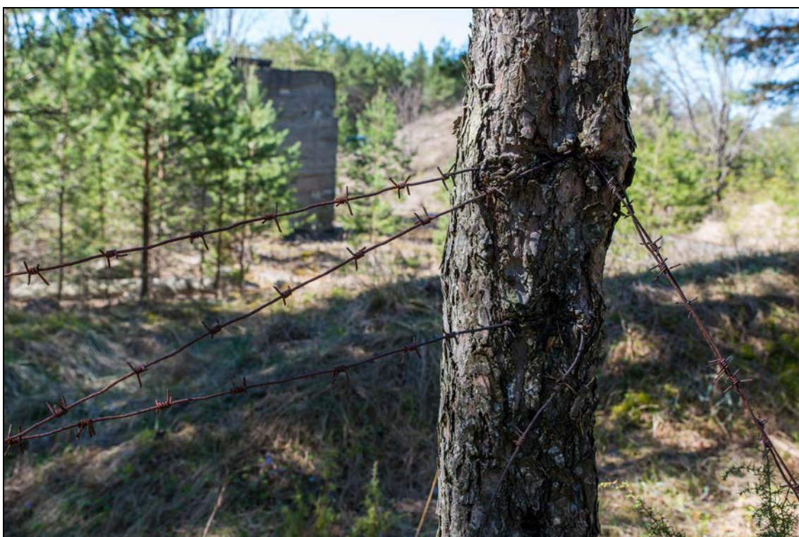
Foto 44 (110). Suur-Nõmmküla raketibaas. Piirdeaia okastraat on naelutatud kasvavate puude külge. Foto Mart Mõniste 23.04.2014.
