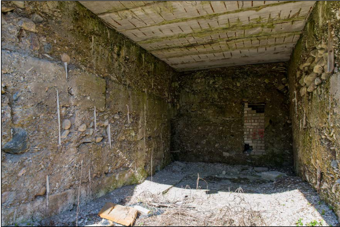
Foto 27 (030). Suur-Nõmmküla raketibaas. Tsentraalpost [11]. Materjalivali tavakohaselt kirju - betoonpaneelid, betoonivalu puidu ja looduskiviga, silikaattellis. Foto Mart Mõniste 23.04.2014.
