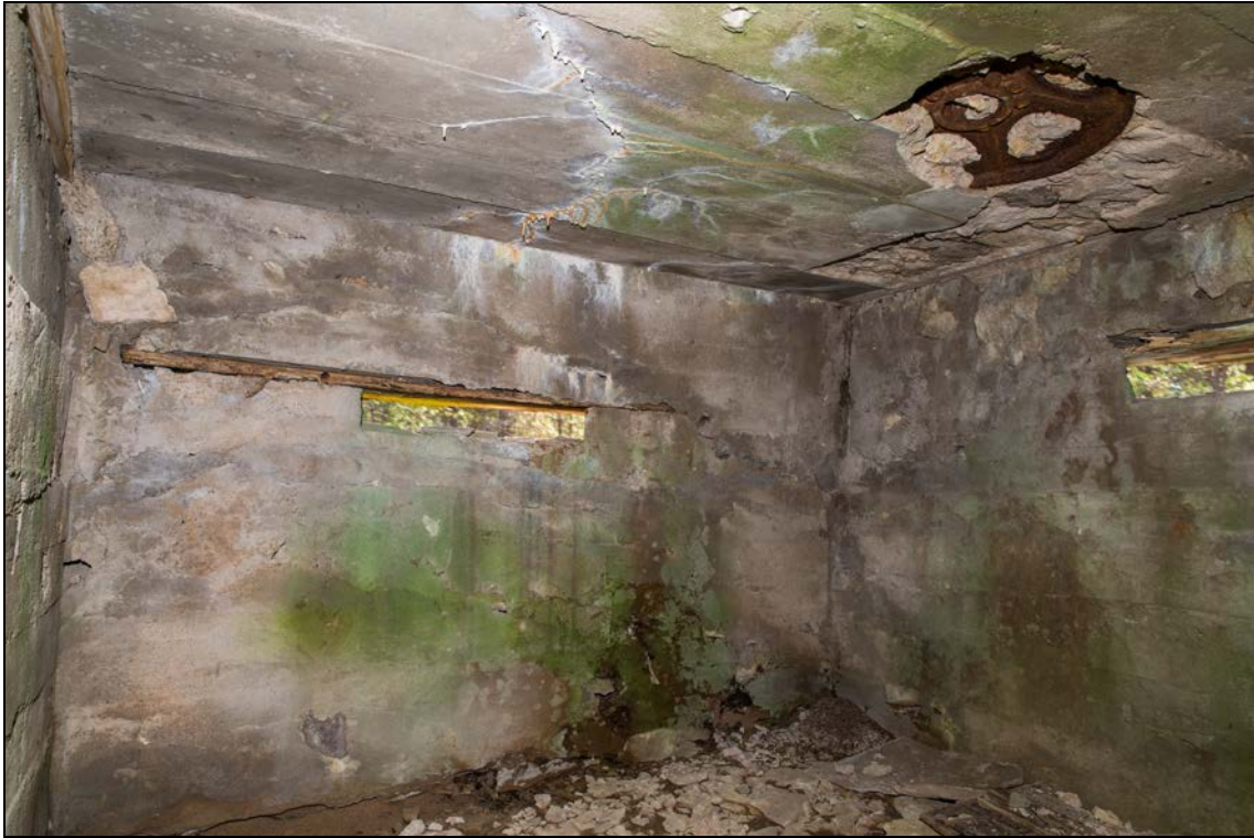
Foto 19 (086). Suur-Nõmmküla raketibaas. Doti [8] laes on armatuurina kasutatud traktori? ratast.
