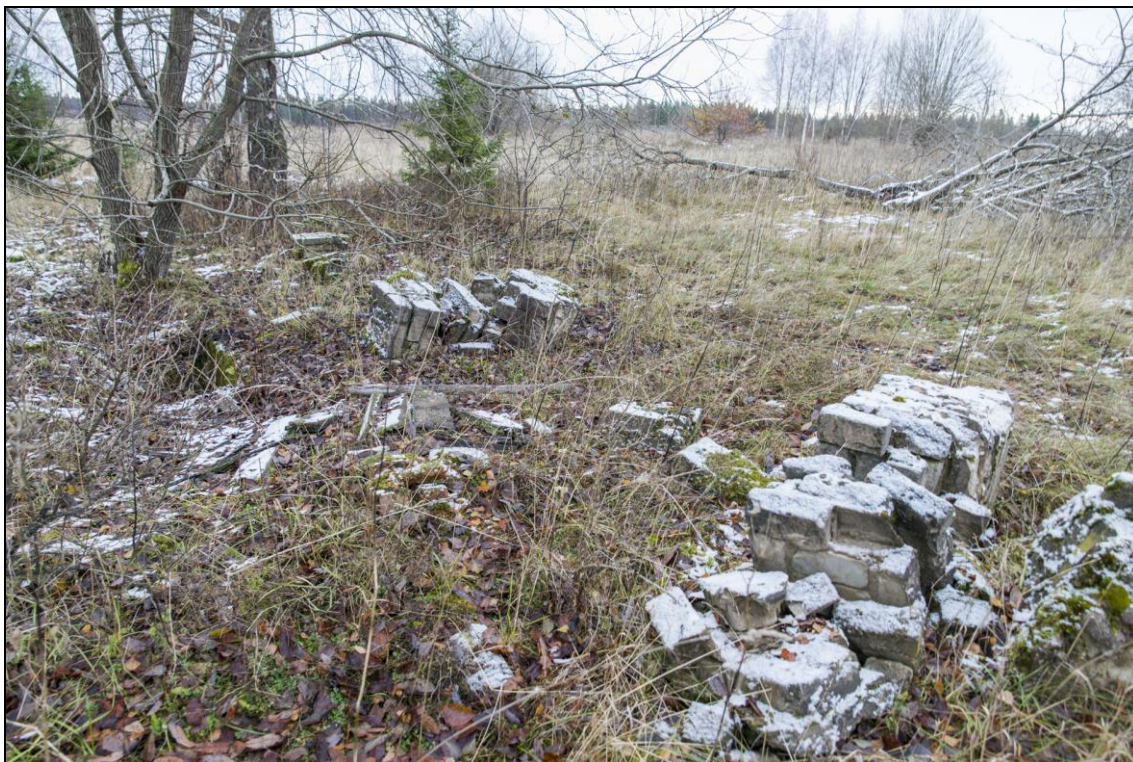
Foto 7 (070). Imastu radarijaam. Tellispostid [4], hoone või katusealuse rusud. Foto Mart Mõniste 1.11.2017.
