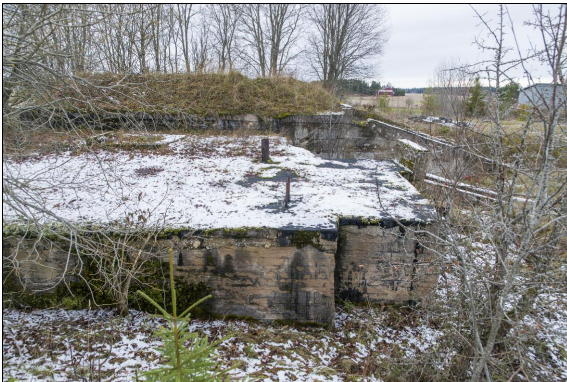
Foto 25 (109). Imastu radarijaam. Angaar [10] ümbert on tõenäoliselt kattepinnas ära veetud. Foto Mart Mõniste 1.11.2017.
