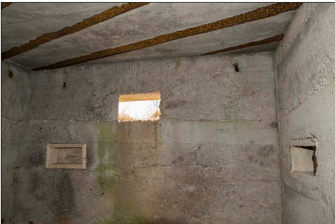
Foto 8 (257). Kõnnu (Torma) radarijaam. Dott [4]. Radarijaama aia nurkades on sümmeetriliselt 4 dotti, kõik ühesuguse ehitusega. Eripäraks on laskeava juures seinas olevad süvendid (laskemoona, magasinid koht?). Foto Mart Mõniste 30.03.2017.
