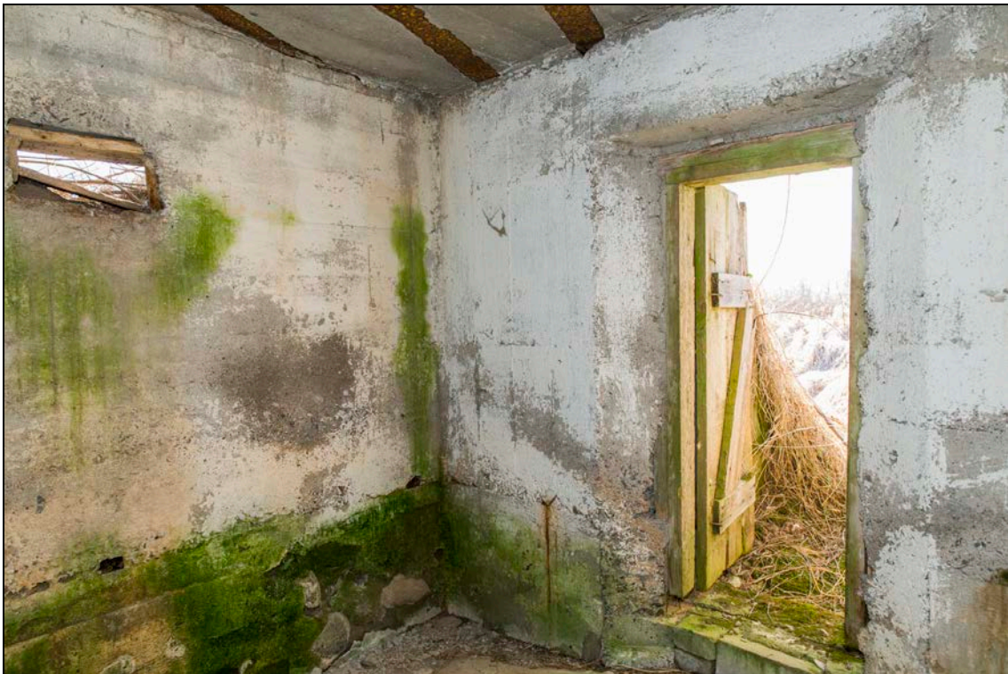
Foto 59 (459). Kõnnu (Torma) radarijaam. Dett [16] on radarijaama neljast dotist ainsana puidust uksega.
