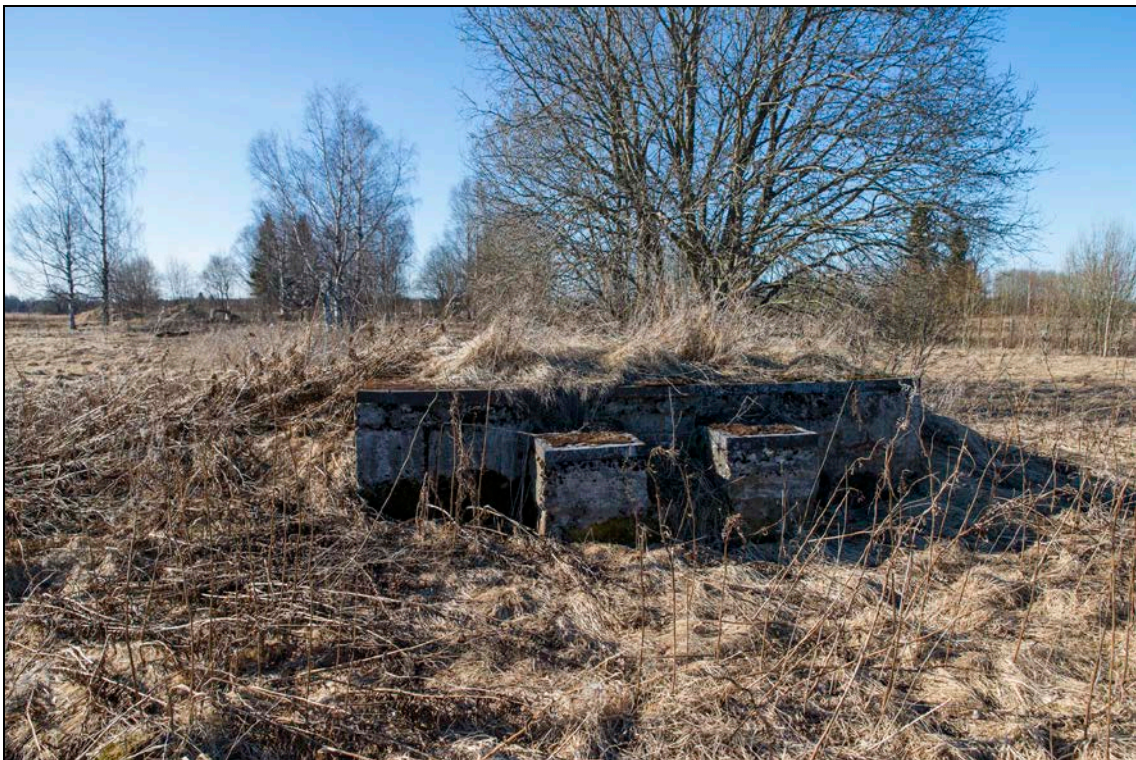
Foto 56 (449). Kõnnu (Torma) radarijaam. Estakaad [15]. Foto Mart Mõniste 30.03.2017.
