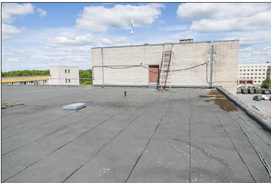
Foto 14 (099). Aia 38 laohoone Jõgeval. Liftitorn laokorpuse [1] kirdepoolses otsas. Foto Mart Mõniste 7.06.2018.
