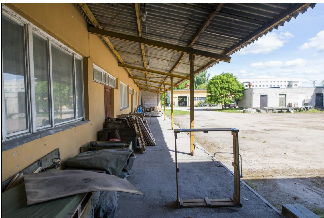
Foto 20 (009). Aia 38 laohoone Jõgeval. Laokorpuse [2] laadimisplatvorm. Foto Mart Mõniste 7.06.2018.
