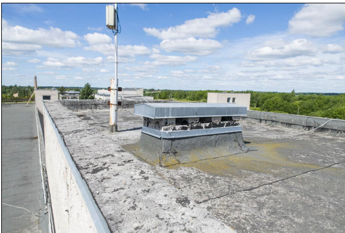
Foto 16 (102). Aia 38 laohoone Jõgeval. Liftitorn laokorpuse [1] kirdepoolses otsas. Foto Mart Mõniste 7.06.2018.
