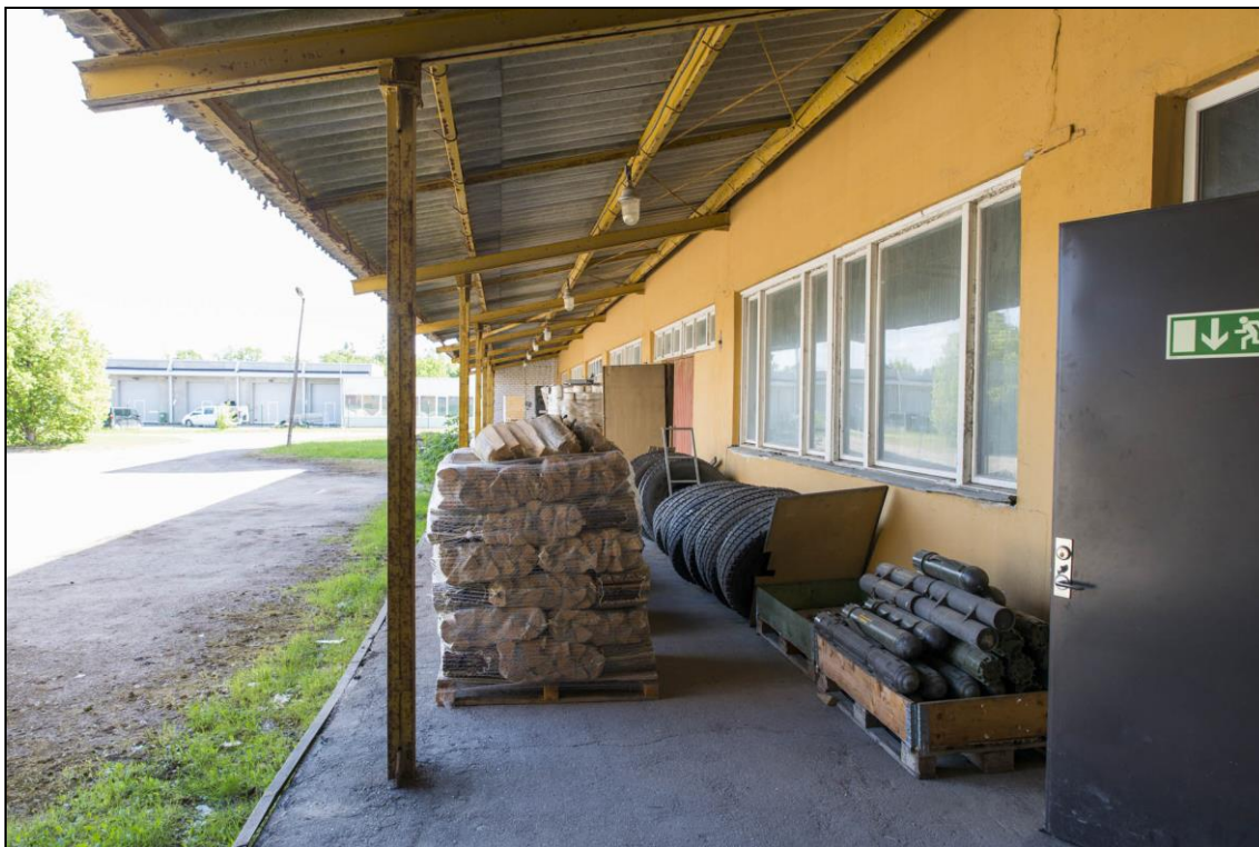
Foto 19 (008). Aia 38 laohoone Jõgeval. Laokorpuse [1] laadimisplatvorm. Foto Mart Mõniste 7.06.2018.
