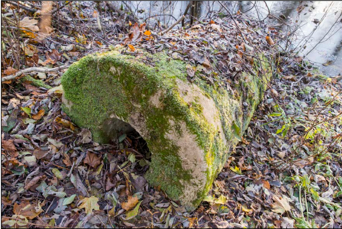
Foto 9 (123). Meriküla 10-tolline patarei. Kahurialuste [1] ja [2] vahel olnud varjendi ventilatsioonikorsten, välisläbimõõt 90 cm.
