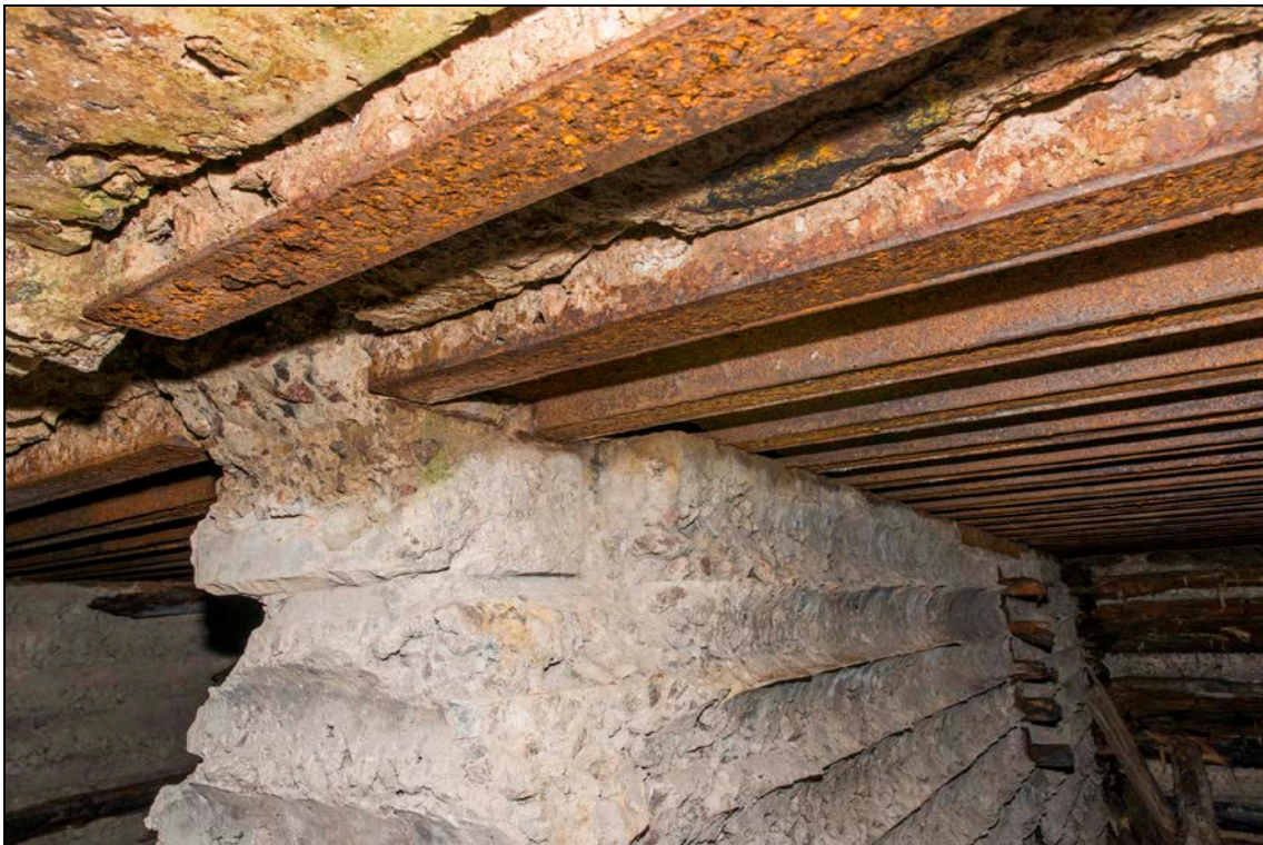
Foto 45 (340). Meriküla 10-tolline patarei. Laskemoonahoidla [6]. Vaheseinte betooni paksus on 1 m.
