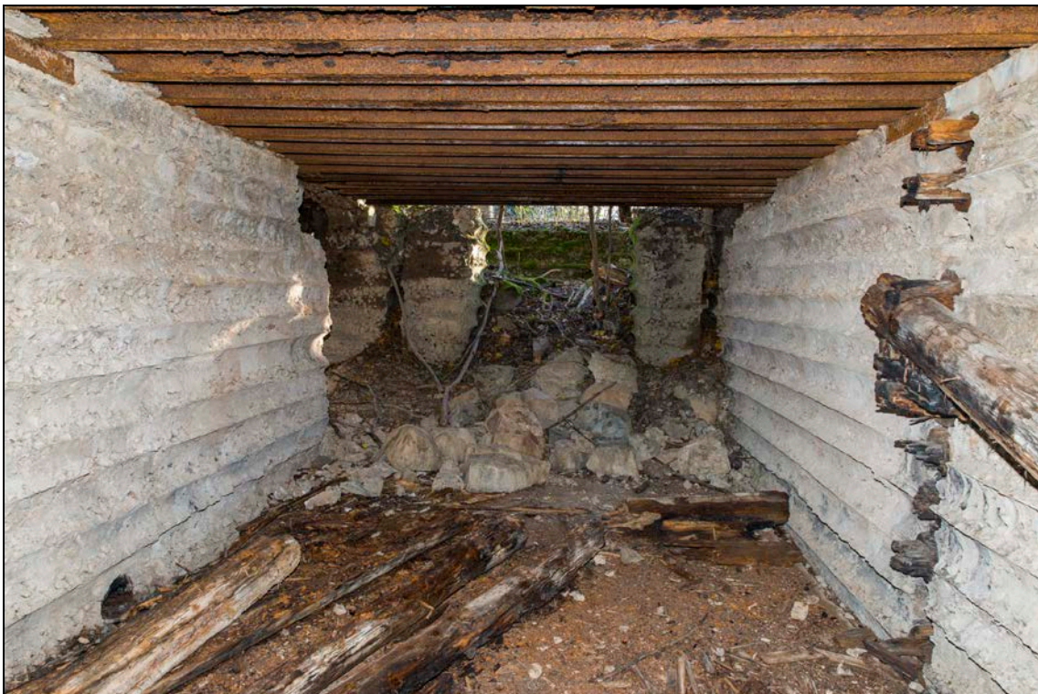
Foto 50 (367). Meriküla 10-tolline patarei. Laskemoonahoidla [6] koosneb kahest eraldi sissepääsuga poolest, kummaski kaks ruumi. Foto Mart Mõniste 2.11.2017.
