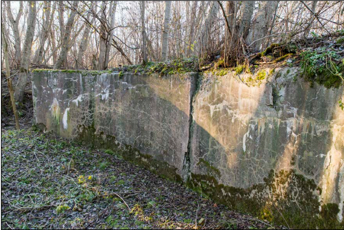
Foto 11 (129). Meriküla 10-tolline patareid. Kahurialus 2 [2]. Piirdesein paistab olevat valatud mitmes järgus ja on kõigi kahurialuste juures pragunenud. Foto Mart Mõniste 2.11.2017.
