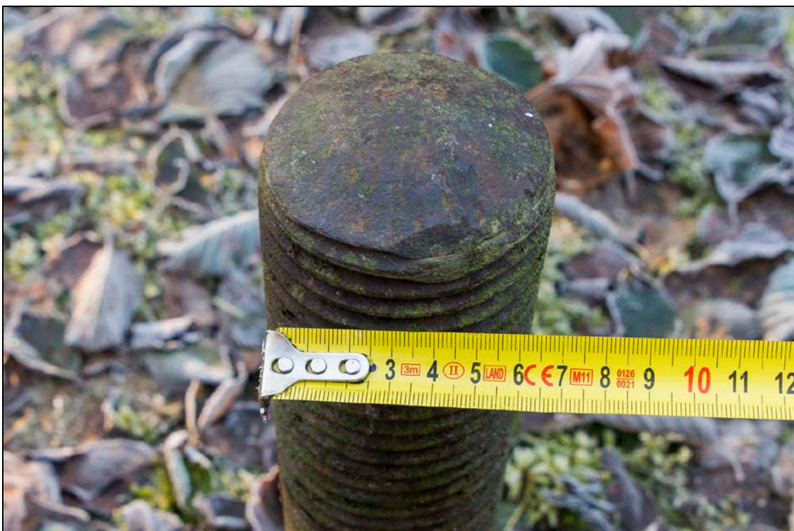
Foto 4 (092). Meriküla 10-tolline patarei. 1. kahurialus [1]. Aluse keskel on 7 cm jämedune ja 45 cm pikkune polt. Foto Mart Mõniste 2.11.2017.
