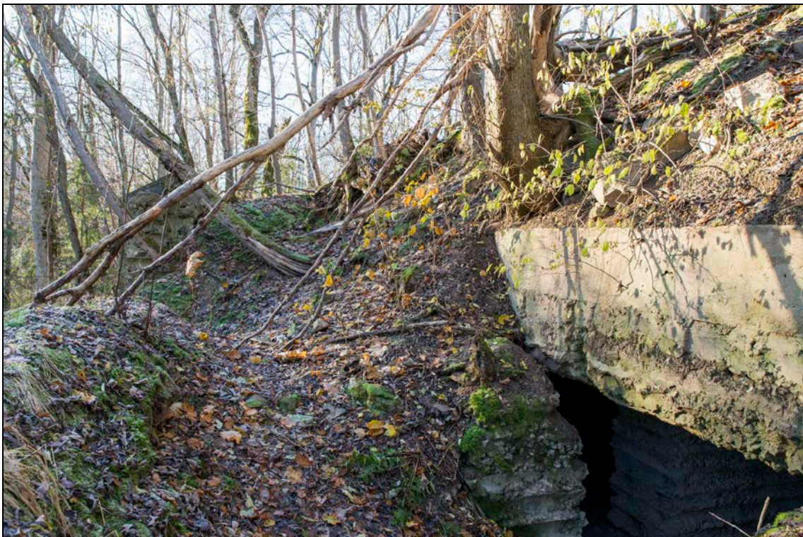
Foto 48 (357). Meriküla 10-tolline patarei. Laskemoonahoidla [6].Lae paksus on 125 cm- Foto Mart Mõniste 2.11.2017.
