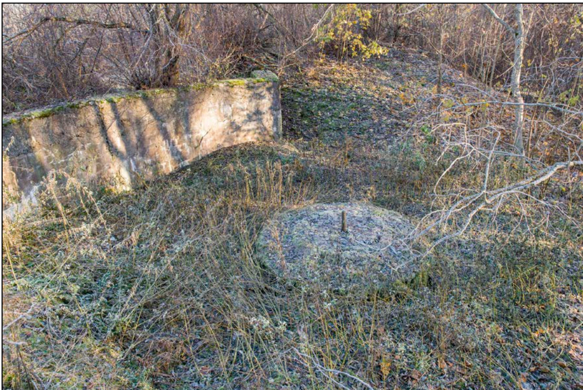
Foto 6 (105). Meriküla 10-tolline patareid. 1. kahurialus [1]. Ümmarguse betoonaluse läbimõõt on umbes 330 cm. Foto Mart Mõniste 2.11.2017.
