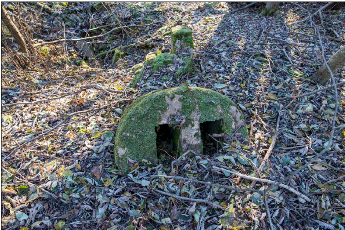
Foto 24 (193). Meriküla 10-tolline patarei. Kahurialuste [3] ja [4] vahel olnud varjendi ventilatsioonikrsten. Foto Mart Mõniste 2.11.2017.
