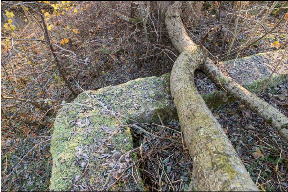
Foto 7 (109). Meriküla 10-tolline patarei. 1. kahurialus [1]. Betoonmüür on 60-70 cm paksune. Foto Mart Mõniste 2.11.2017.
