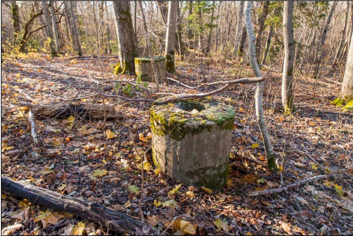
Foto 55 (411). Meriküla 10-tolline patarei. Laskemoonahoidla [6]. Ventilatsioonikorstnad. Foto Mart Mõniste 2.11.2017.
