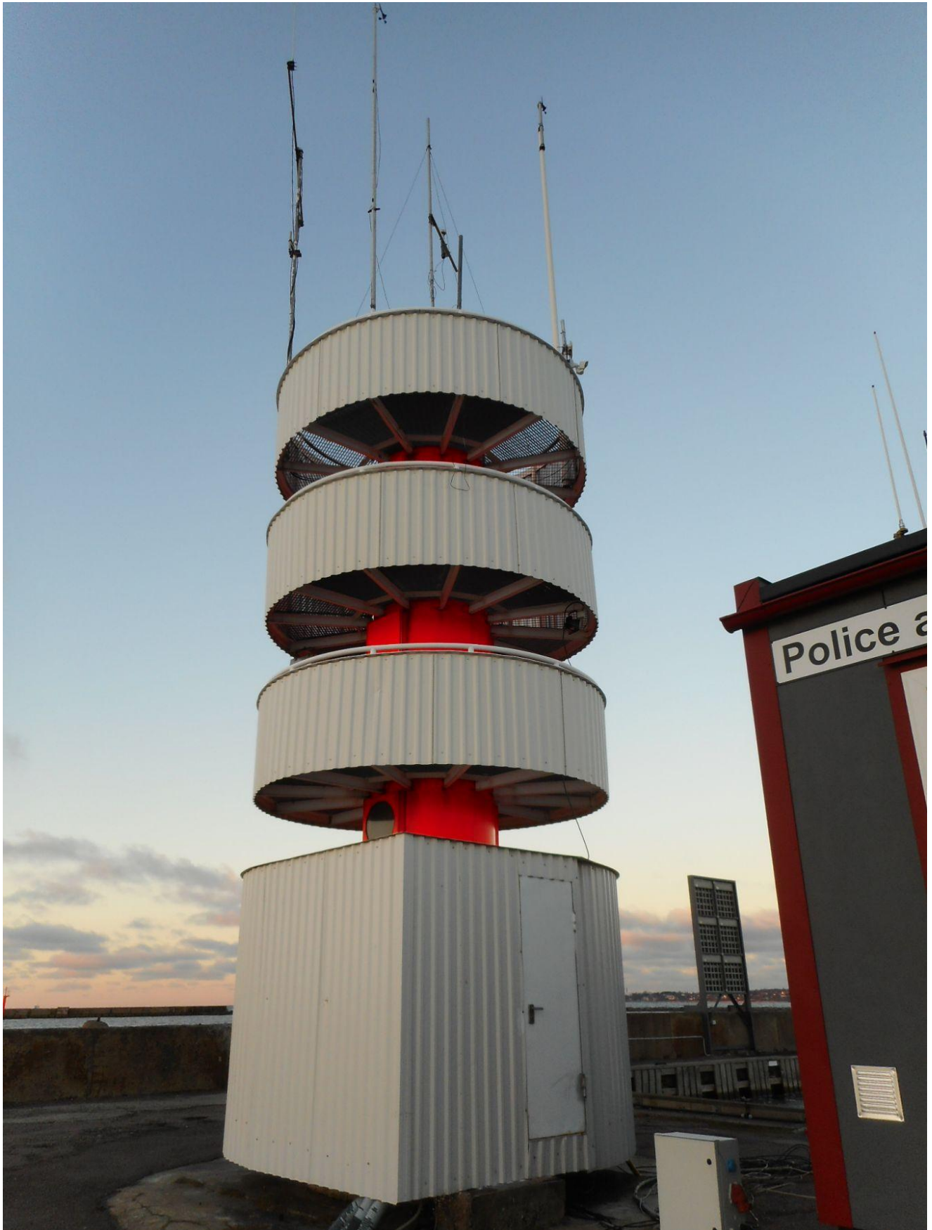
Foto 9. (21) Pirita tehnilise vaatluse post. Meremärgiks maskeeritud vaatlus- ja radaritorn [5]. Vaade edelast. U 1,2 m läbimõõduga tsentraaltoru lääneküljel on II–IV korrusel ukсед. Foto Jüri Pärn 6.12.2016.
