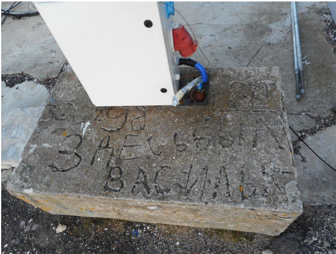
Foto 5. (22) Pirita tehnilise vaatluse post. Ajalooliste kirjadega vana elektrikilbi betoonalus [4] koos kaablisisendiga. Võib-olla täitis ühtlasi ka operaatorihoone aluse rolli. Foto Jüri Pärn 6.12.2016.
