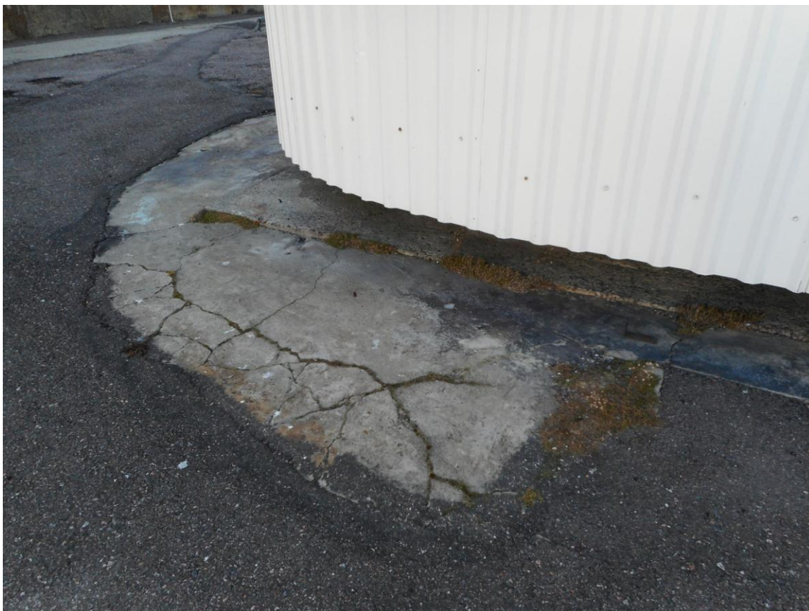
Foto 21. (37) Pirita tehnilise vaatluse post. Vundamendi betoonääriskülg [6] lõpeb läänepoolisel küljel järsult ära (sellest maa poole polnud I korrusel aknaid?). Foto Jüri Pärn 6.12.2016.
