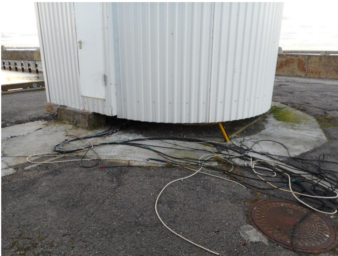
Foto 20. (26) Pirita tehnilise vaatluse post. Torni vundamendi kandilise välisosa ümber on valatud u 1 m laiune betoonääriskülg [6], kuid mitte täisringina (ainult akendega seinaga alla?). Paremal nurgas Tallinna telefonivõrgu sidekaev [8] (lühendiga „ГТС” — городская телефонная сеть?). Foto Jüri Pärn 6.12.2016.
