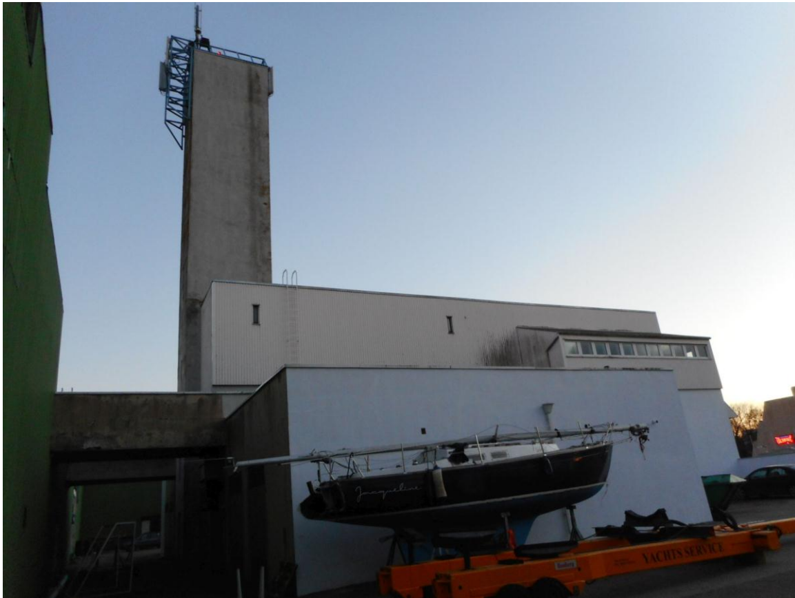
Foto 28. (131) Piritas tehnilise vaatluse post. Olümpiaküla kirik, mille torn täidab Piritas jahisadama sissesõidusihi 136,2° ülemise tulepaagi rolli. Foto Jüri Pärn 6.12.2016.
