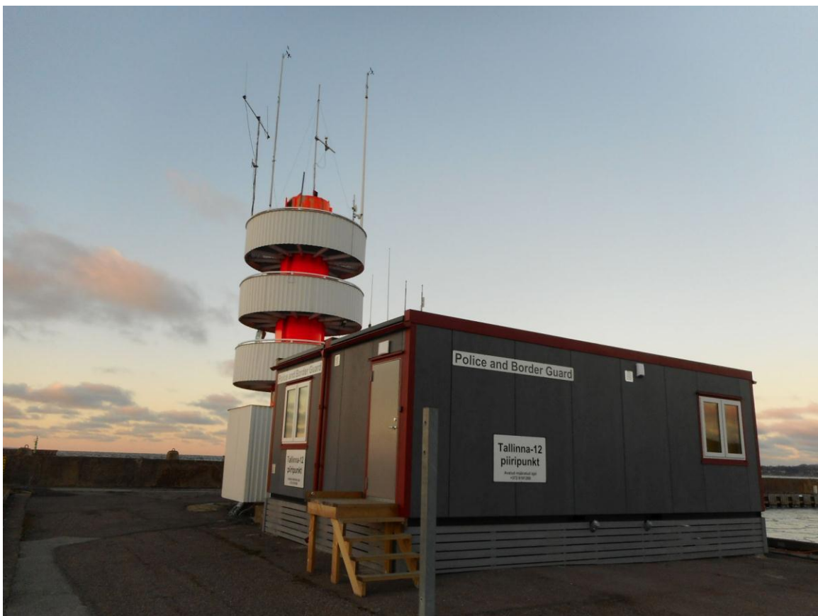
Foto 4. (20) Pirita tehnilise vaatluse post. EV piiripunkti Tallinn-12 soojak [3], tagapool TVP torn [5]. Foto Jüri Pärn 6.12.2016.
