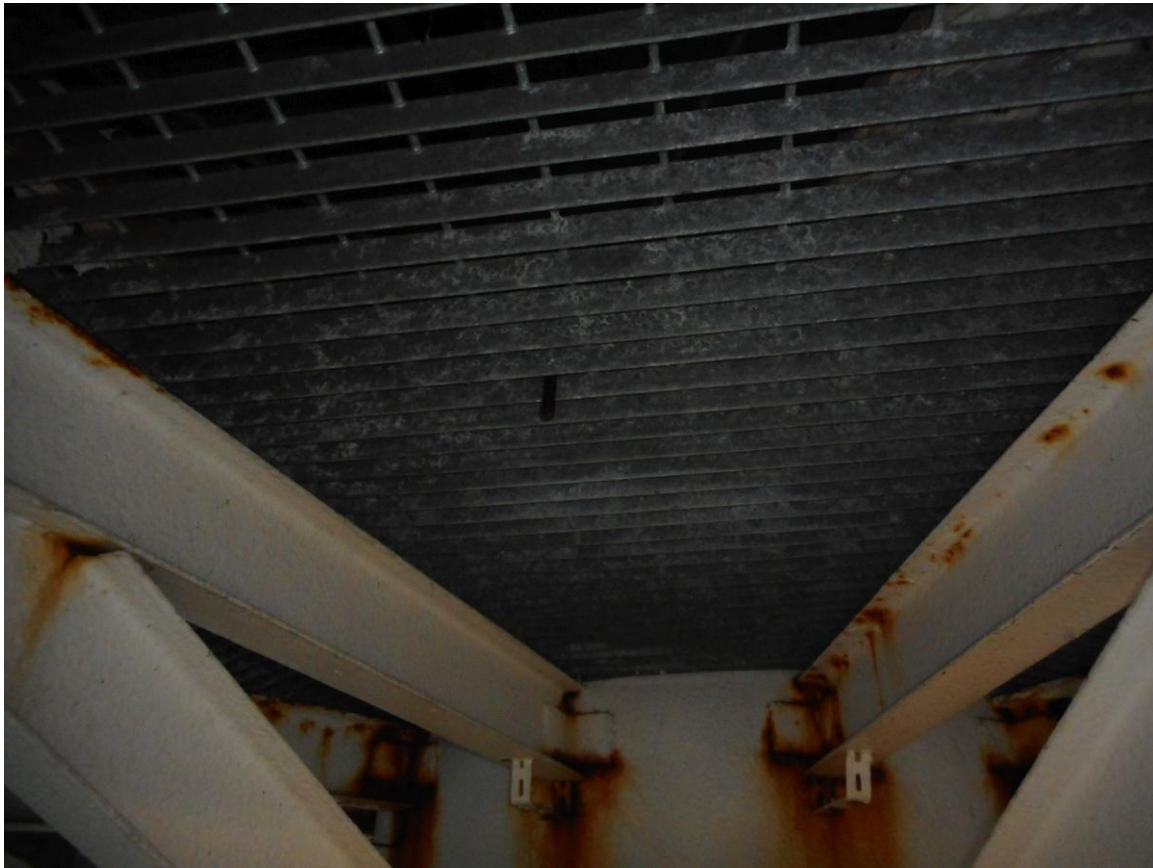
Foto 14. (69) Pirita tehnilise vaatluse post. Torn [5] I korruse põranda vaade põhjast. Foto Jüri Pärn 6.12.2016.
