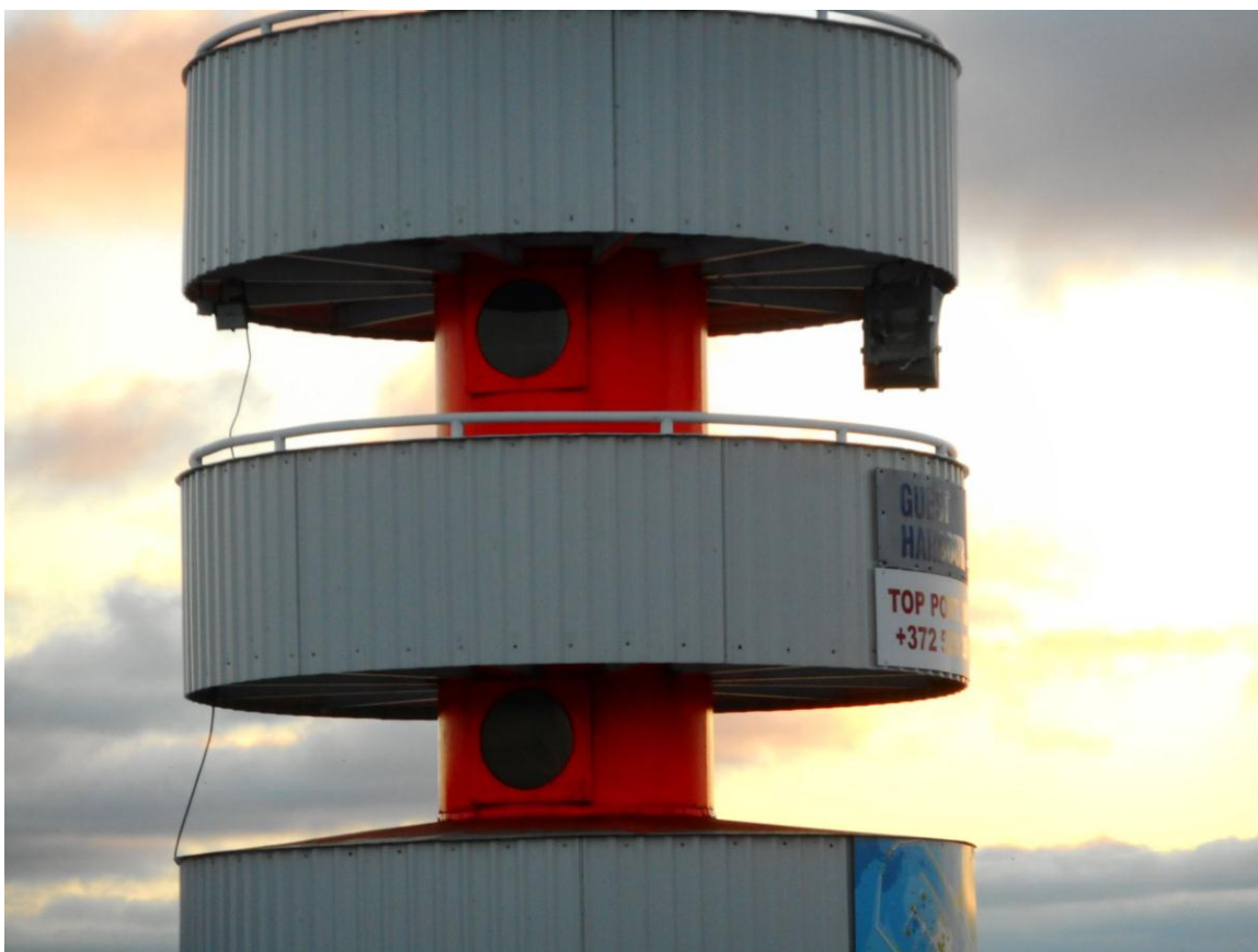
Foto 11. (64) Piritas tehnilise vaatluse post. Tornis [5] II ja III korruse vaade kirdest. Tsentraaltorus on sellel küljel illuminaatorid. Metalltorudest rõdupiirded võivad olla algupärased, plekk on hiljem välja vahetatud. Foto Jüri Pärn 6.12.2016.
