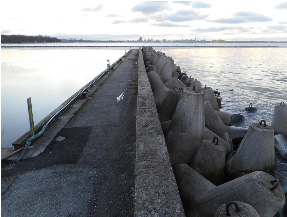
Foto 27. (93) Piritas tehnilise vaatluse post. Läänepoolne kaiots punktist [7]. „Püramiidid” kai kindlustamiseks toodi siia alles 2008. aastal. Foto Jüri Pärn 6.12.2016.
