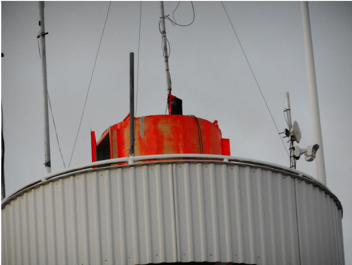
Foto 18. (117) Pirita tehnilise vaatluse post. Torn [5] IV korruse vaade kagust. Siin oli omal ajal 2 radariantenni. Foto Jüri Pärn 6.12.2016.
