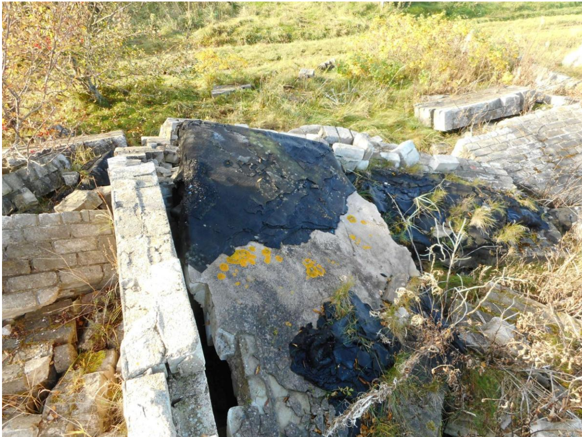
Foto 25. (314) Paljassaare vana tehnilise vaatluse post. Prožektorihoone [21] krohvitud seinale on kleepunud katusematerjal (vähemalt 5 kihti tõrvapappi bituumeniga vaheliti). Foto Jüri Pärn 16.10.2016.
