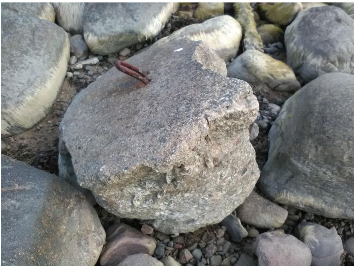
Foto 16. (20161016_130351) Paljassaare vana tehnilise vaatluse post. Kagupoolseim tõmmitsaankur [16], näib leitud kolmest kõige uuem (esialgne kord juba mere poolt ära söödud?). Kirdepoolset ei leidnud (on hävinud, veerise all või tagurpidi pöördunud?). Foto Jüri Pärn 16.10.2016.
