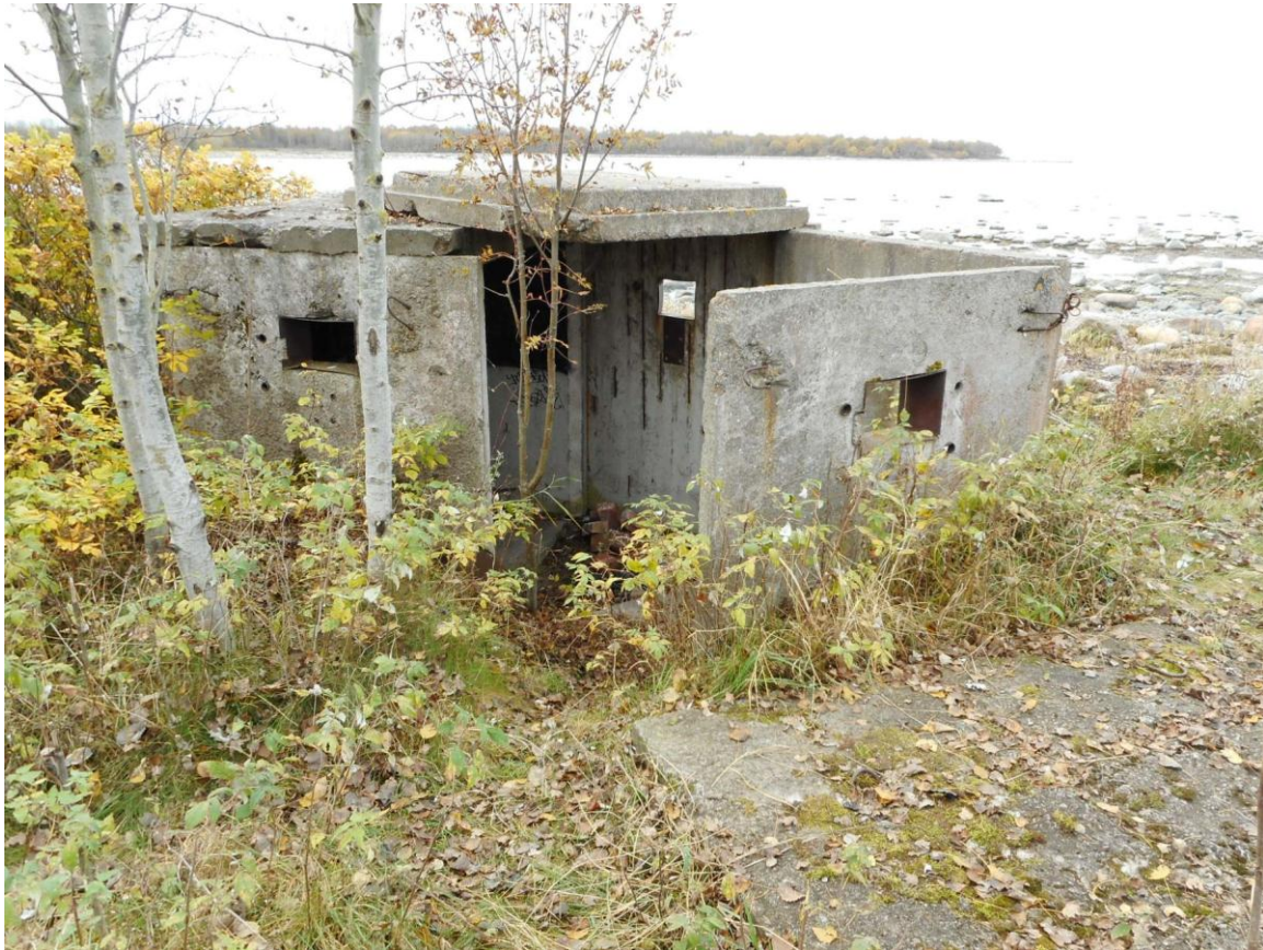
Foto 5. (471) Paljassaare vana tehnilise vaatluse post. Dott SPS-3 [6], vaade kirdest. Paremalt on näha laepaneel (samasugune nagu dotil keskel, ainult õigetpidi, kitsam pool all). Foto Jüri Pärn 16.10.2016.
