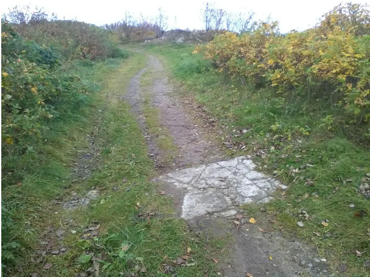
Foto 8. (20161016_131554) Paljassaare vana tehnilise vaatluse post. Betoonkõnnitee? aparaadihoone [14] ja kütusehoidla [8] vahel. Foto Jüri Pärn 16.10.2016.
