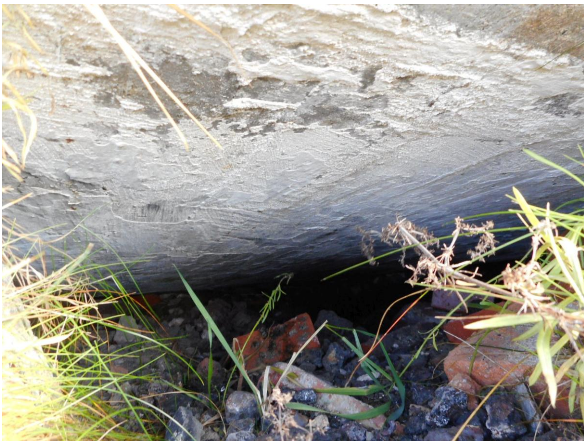
Foto 20. (373) Paljassaare vana tehnilise vaatluse post. Diislihoone [19] lagi on alt lubjatud. Foto Jüri Pärn 16.10.2016.
