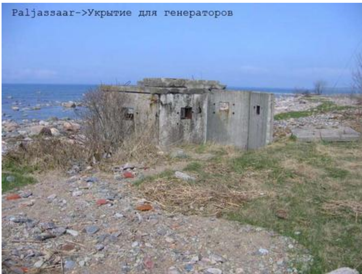
Foto 31. Paljassaare vana tehnilise vaatluse post. Doti [6] vaade lõunast 15.06.2005. Tekst fotol väidab miskipärast, et on tegu generaatorite varjega. Allikas: http://milind.livejournal.com/16865.html .
