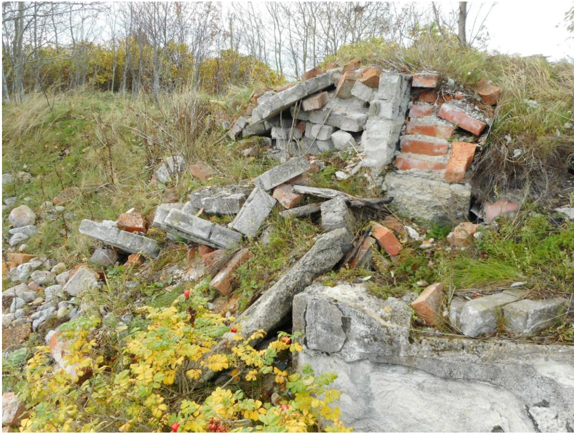
Foto 11. (458) Paljassaare vana tehnilise vaatluse post. Operaatori- e aparadihoone [14] (kontuurid u 10x10 m) kagunurk. Seinad punastest tellistest (40 cm), silikaatvoodriga, mis alates 5. kivist läheb üle servitikivivoodriks. Foto Jüri Pärn 16.10.2016.
