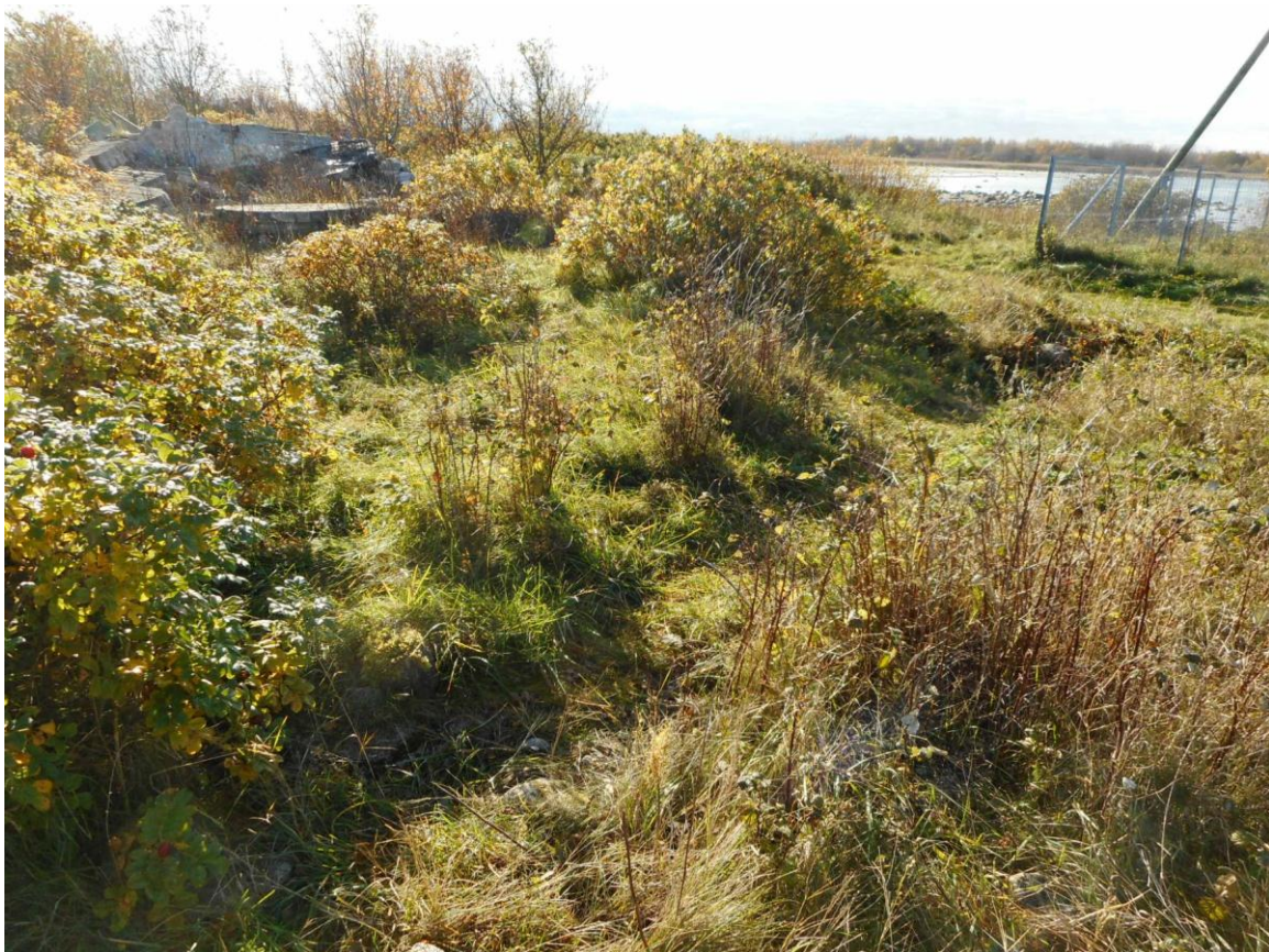
Foto 26. (324) Paljassaare vana tehnilise vaatluse post. Prožektoripositsioon [21], vaade põhjast. Arvatavasti betoonpõrand, aga täielikult rohukamara all. Paremalt radari [25] aed. Foto Jüri Pärn 16.10.2016.
