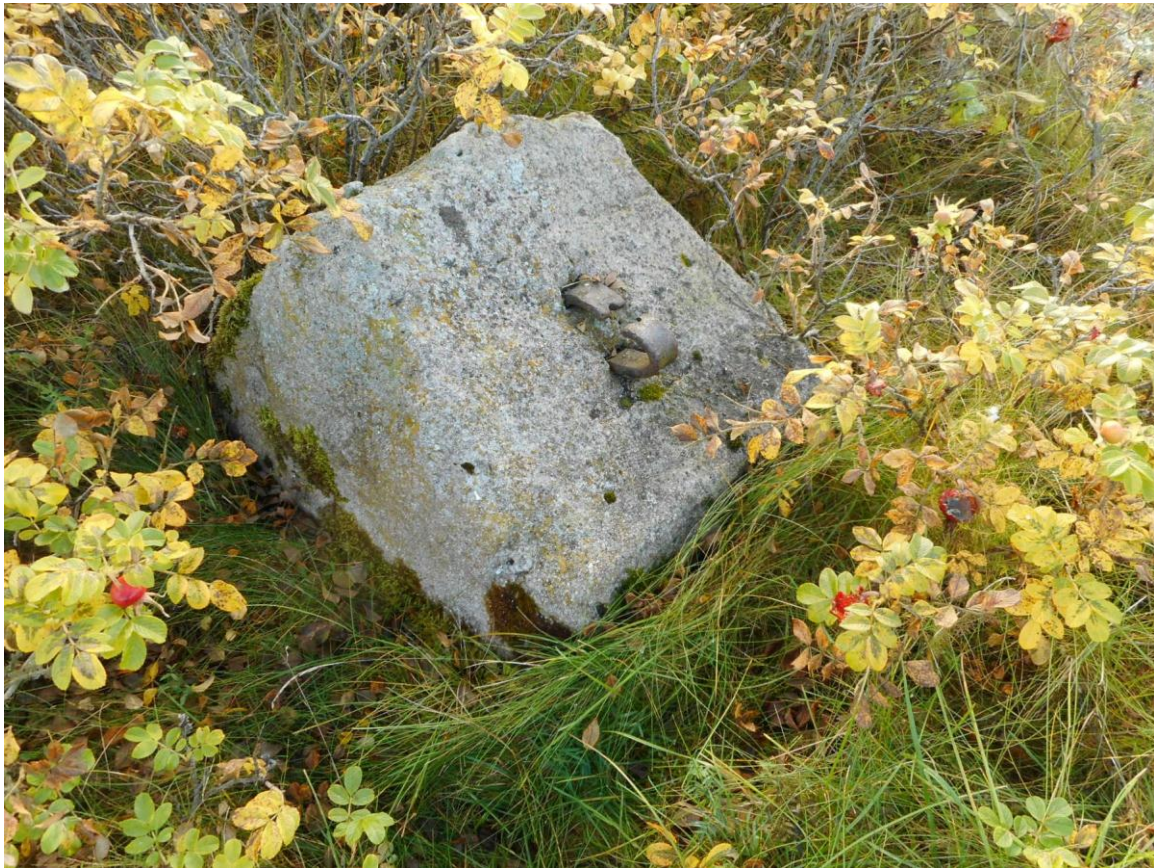
Foto 17. (400) Paljassaare vana tehnilise vaatluse post. Tõmmitsaankur [17]. Nagu näha, on leitud kolmest igäüks erineva konstruktsiooniga. Foto Jüri Pärn 16.10.2016.
