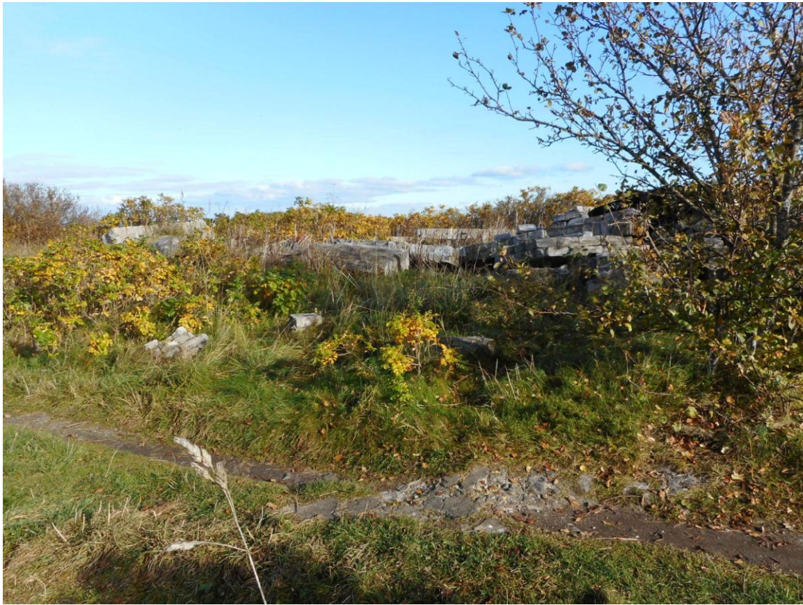
Foto 27. (336) Paljassaare vana tehnilise vaatluse post. Prožektorihooned [21] varemed edelast. Esiplaanil betoonkõnnitee? [23]. Suundub arvatava kemmergu [24] poole. Foto Jüri Pärn 16.10.2016.
