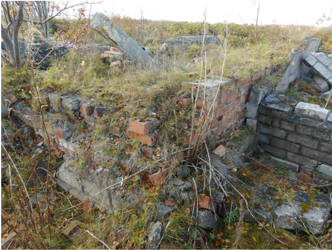
Foto 21. (391) Paljassaare vana tehnilise vaatluse post. Diislihoone [19] kirdenurk. Paremalt kahe hoone vahele hiljem ehitatud lühem vaheruum [20]. Ehitustehnoloogia sama mis operaatorihoonel — punane tellis serviti silikaatkivivoodriga. Foto Jüri Pärn 16.10.2016.
