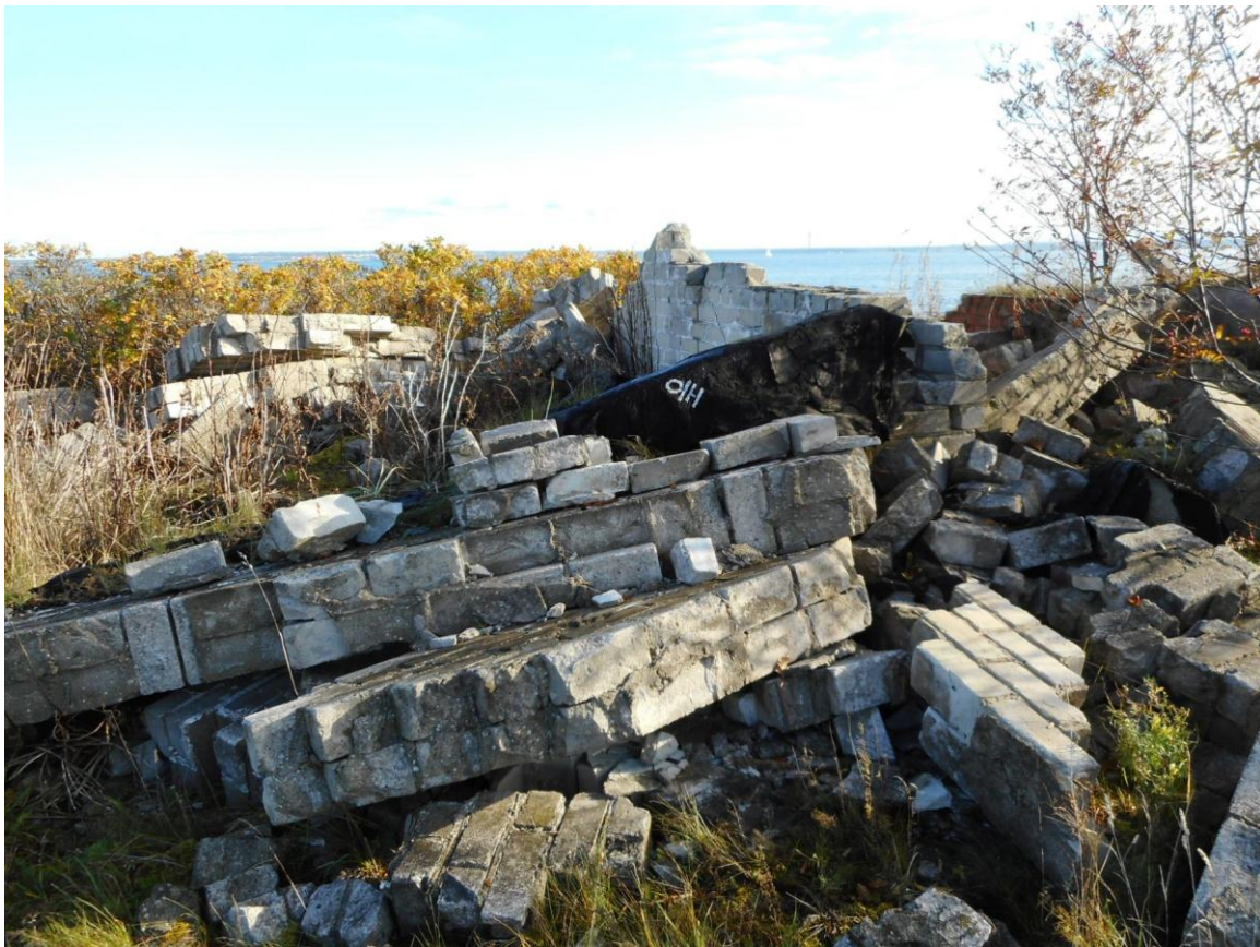
Foto 24. (306) Paljassaare vana tehnilise vaatluse post. Prožektorihooned [21] vaade loodest. Sellel on 25 cm paksused paksematest kividest silikaatseinad puhta vuugiga (niivõrd, kuivõrd). Foto Jüri Pärn 16.10.2016.
