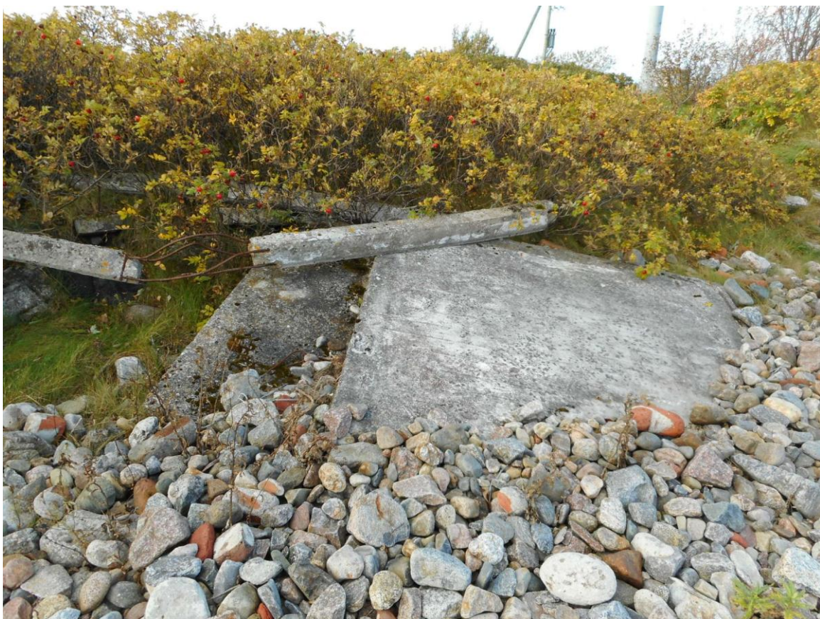
Foto 18. (411) Paljassaare vana tehnilise vaatluse post. Kaks betoonpaneeli ning murdunud betoonist (aia?)postid [15a]. Foto Jüri Pärn 16.10.2016.
