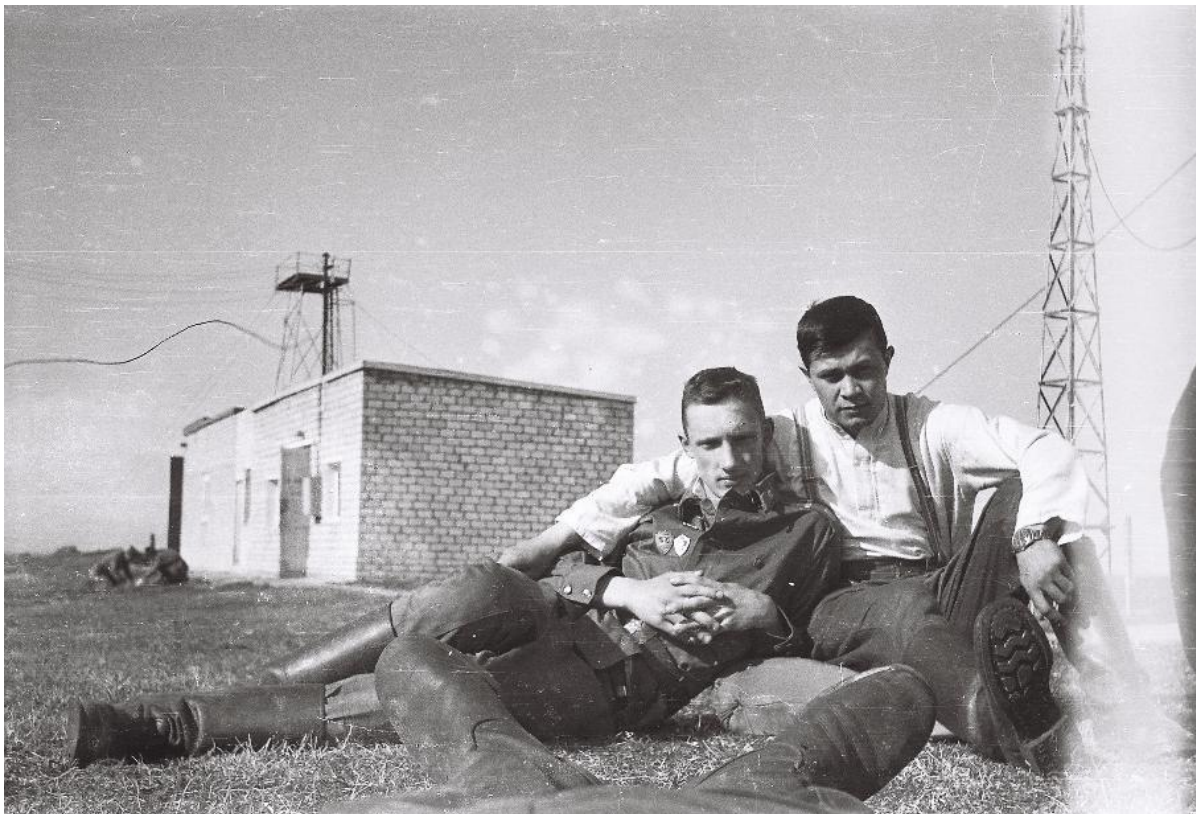
Foto 43. Paljassaare vana tehnilise vaatluse post. Prožektorihooone [22] ning raadiomast [18], u 1985–86. Allikas: http://www.pzokk.narod.ru/index313.html .
