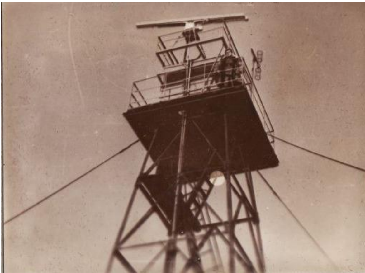
Foto 37. Paljassaare vana tehnilise vaatluse post. Torn [15] 1980.-il, veidi teisest rakursist, nii et paistab ka rõdu parempoolsel serval olev kordoniga ühenduse pidamiseks mõeldud stantsiaarse raadiojaama antenn. Allikas: www.pogranec.ru .
