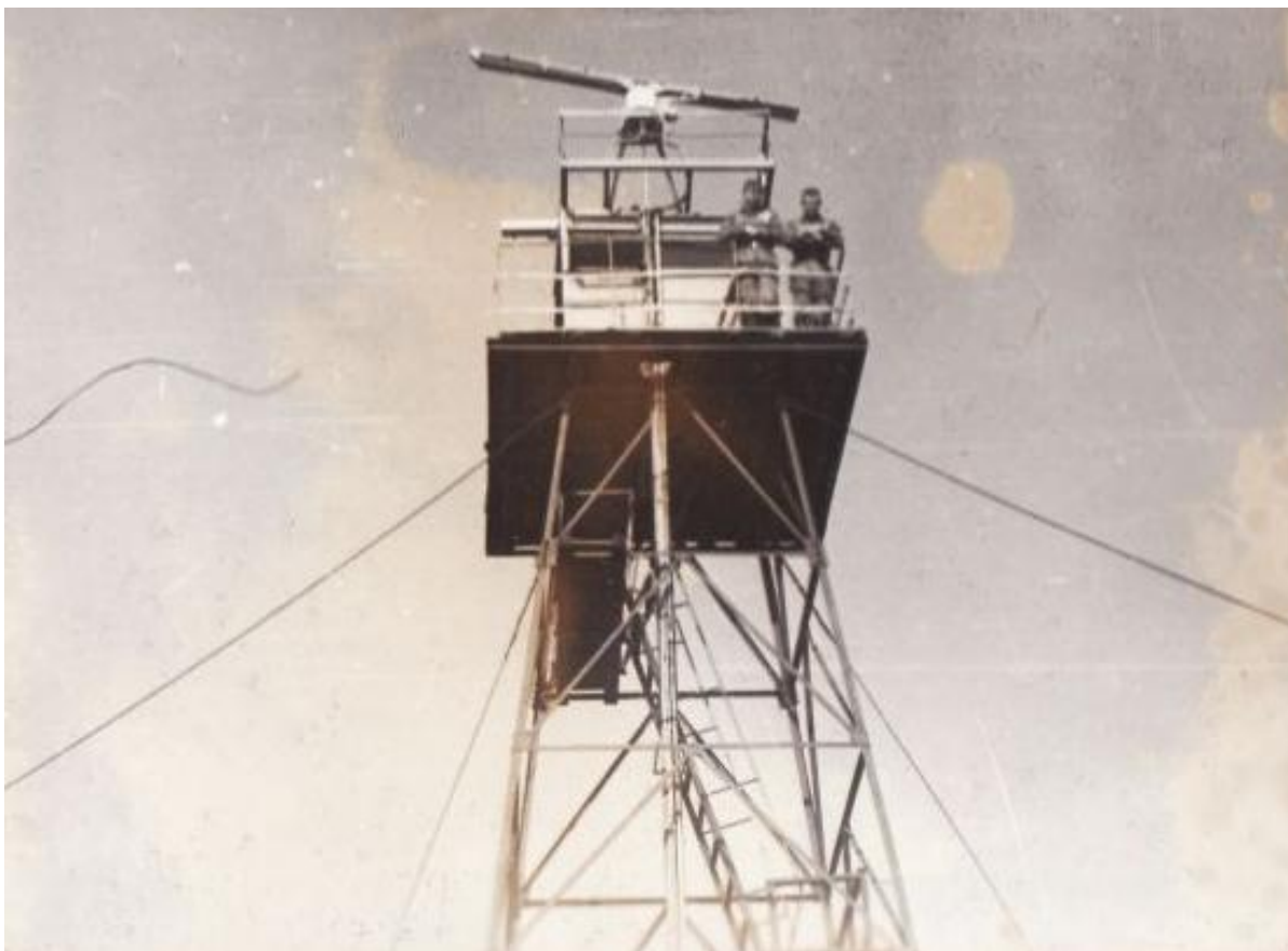
Foto 36. Paljassaare vana tehnilise vaatluse post. Torn [15] u 1985–86. Katusel kaks 2,4 m pikkust radariantennimoodulit. Allikas: http://www.pzokk.narod.ru/index313.html .
