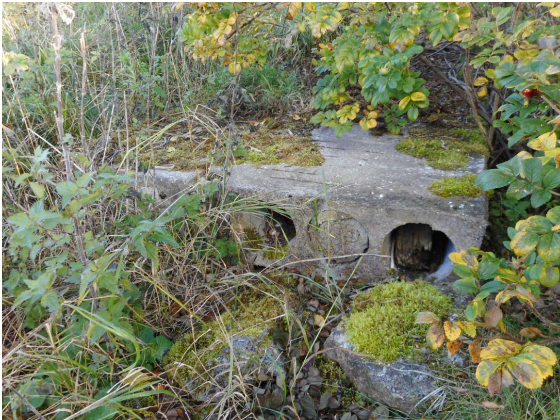
Foto 28. (331) Paljassaare vana tehnilise vaatluse post. Võserikus erinevad ehitusdetailid (pildil omatehtud? laepaneel) ning arvatav kemmergu asukoht (1970.-il) [24]. Foto Jüri Pärn 16.10.2016.
