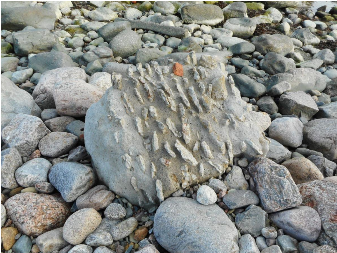
Foto 15. (425) Paljassaare vana tehnilise vaatluse post. Üks merepoolsetest betoonalustest [17]. Vasakul poldiotsad. Foto Jüri Pärn 16.10.2016.
