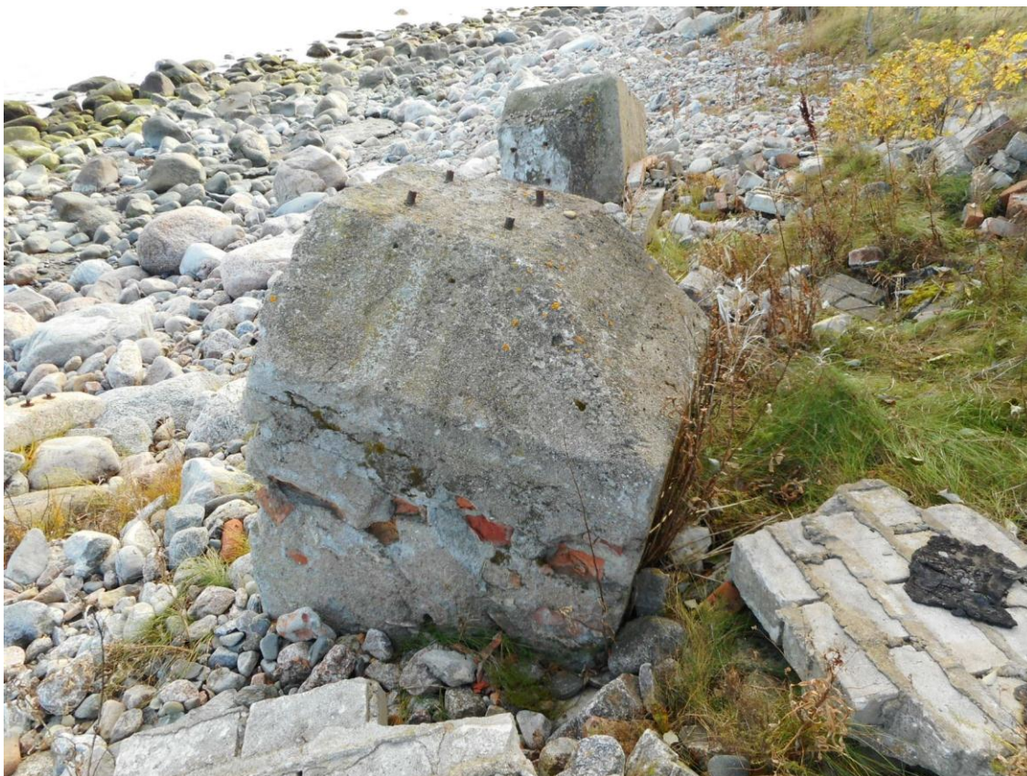
Foto 14. (413) Paljassaare vana tehnilise vaatluse post. Torni betoonalused [17], vaade põhjast. Vanemat tüüpi, ebasümmeetrilised (kinnituspoldid on torni tsentri poolsetes nurkades). Foto Jüri Pärn 16.10.2016.
