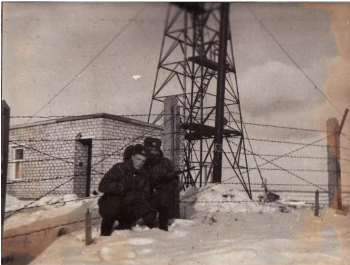
Foto 33. Paljassaare vana tehnilise vaatluse post. Hoone [14] ja torn [15] 1980.-il. Väljaspool aeda paistavad signaaltraadi 0,5 m kõrgused postid. Keskul asuv lumine mügarik pidavat olema betoonpunker (SPS-2?). Telefonipostil number 53? Allikas: www.pogranec.ru .
