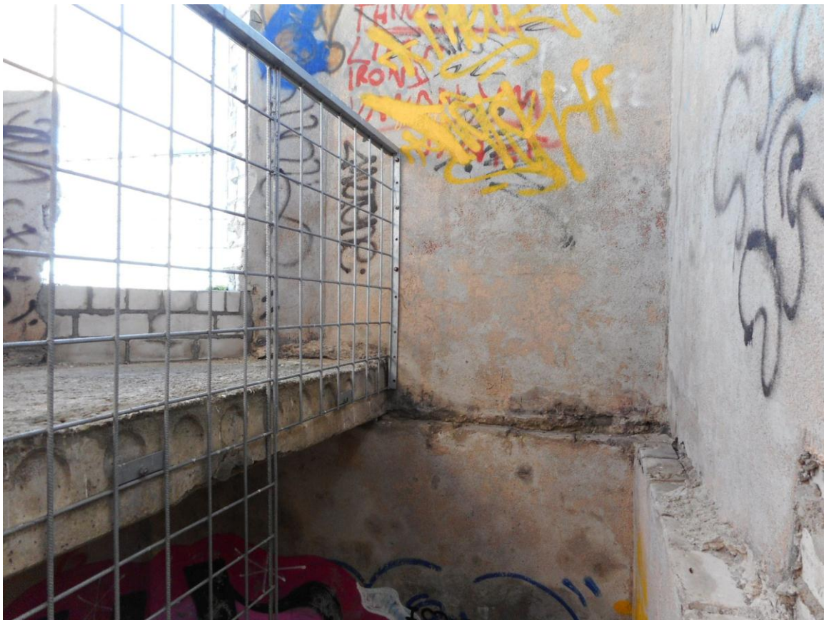
Foto 18. (240) Paljassaare tehnilise vaatluse post. Hoone [4] visuaalvaatlusposti ruumi idaosa. Vasakul välisukse koht (läves uued kivid, kuna katusepinda on tõstetud), otse ees paremal oli vana metalltrepide ülemine ots. Foto Jüri Pärn 16.10.2016.
