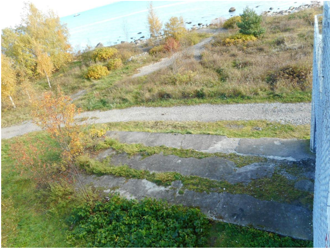
Foto 27. (191) Paljassaare tehnilise vaatluse post. Prožektoripositsiooni [5] vaade katuselt. Tagaplaanil ehitusjätmed [6a]. Foto Jüri Pärn 16.10.2016.
