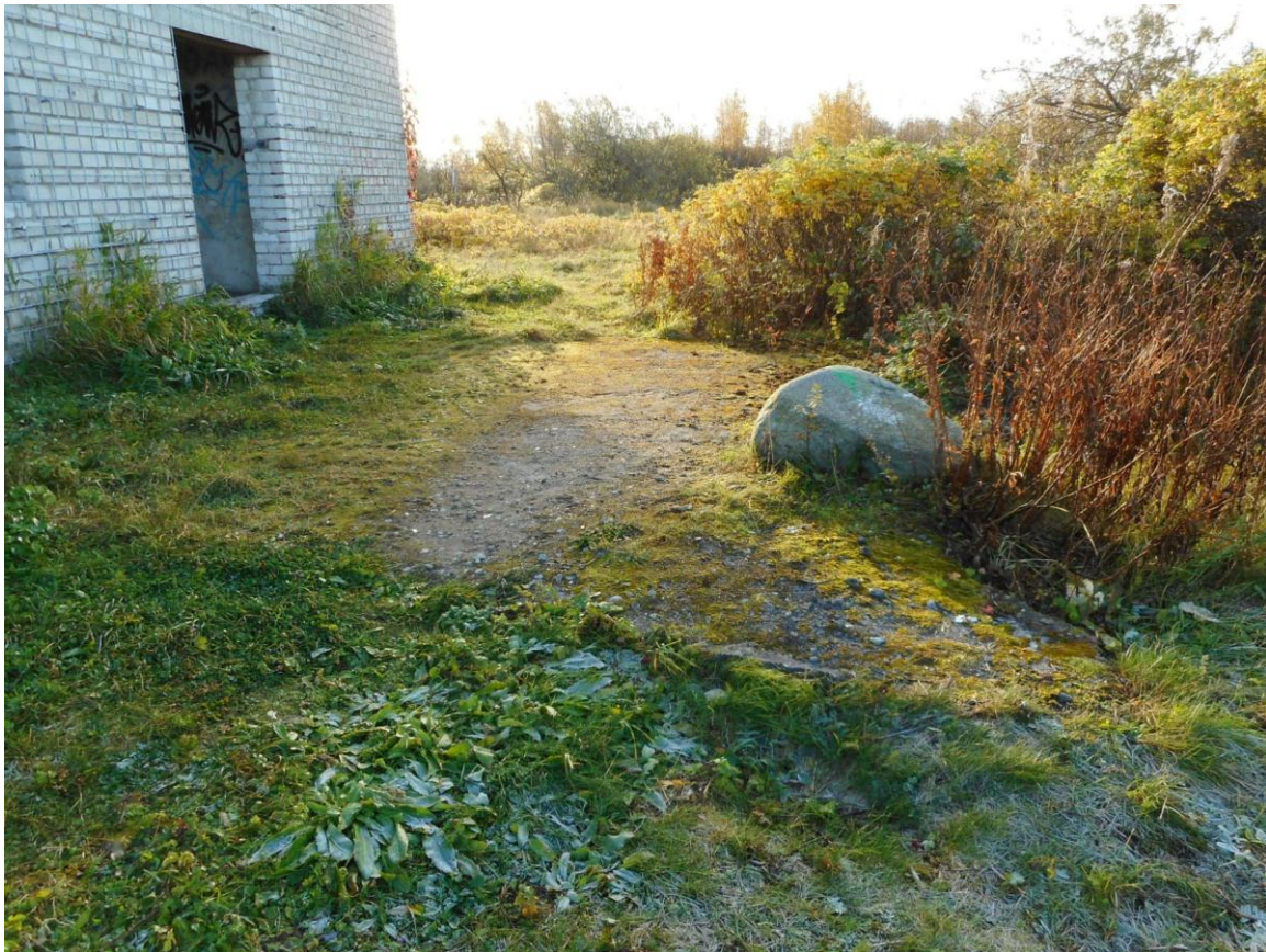
Foto 30. (43) Paljassaare tehnilise vaatluse post. Ebamäärase kujuga betoneeritud platsike [10] hoone [4] sissepääsu ees, vähemalt 7x3 m (vaade põhjast). Foto Jüri Pärn 16.10.2016.
