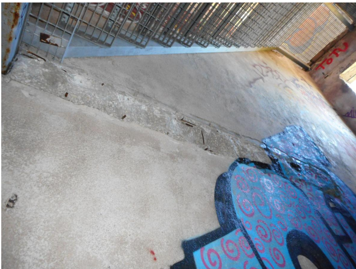
Foto 12. (118) Paljassaare tehnilise vaatluse post. Hoone [4]. Uue metalltrepi paigaldamiseks on välja lõhutatud kaks laepaneeli (kahel korrusel). Vana trepp kulges ühes tükis otse 3. korrusele (foto parema serva juurest), uus on 2-järguline. Foto Jüri Pärn 16.10.2016.
