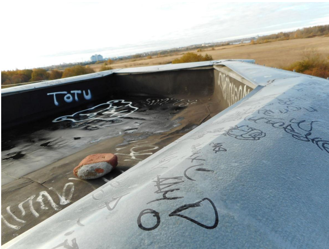
Foto 21. (238) Paljassaare tehnilise vaatluse post. Hoone [4] visuaalvaatlusposti ruumi katus. Võret mööda saab ka sellele katusele ronida. Veel 2005.a paiku olid seal kaks radariantennialust. Foto Jüri Pärn 16.10.2016.
