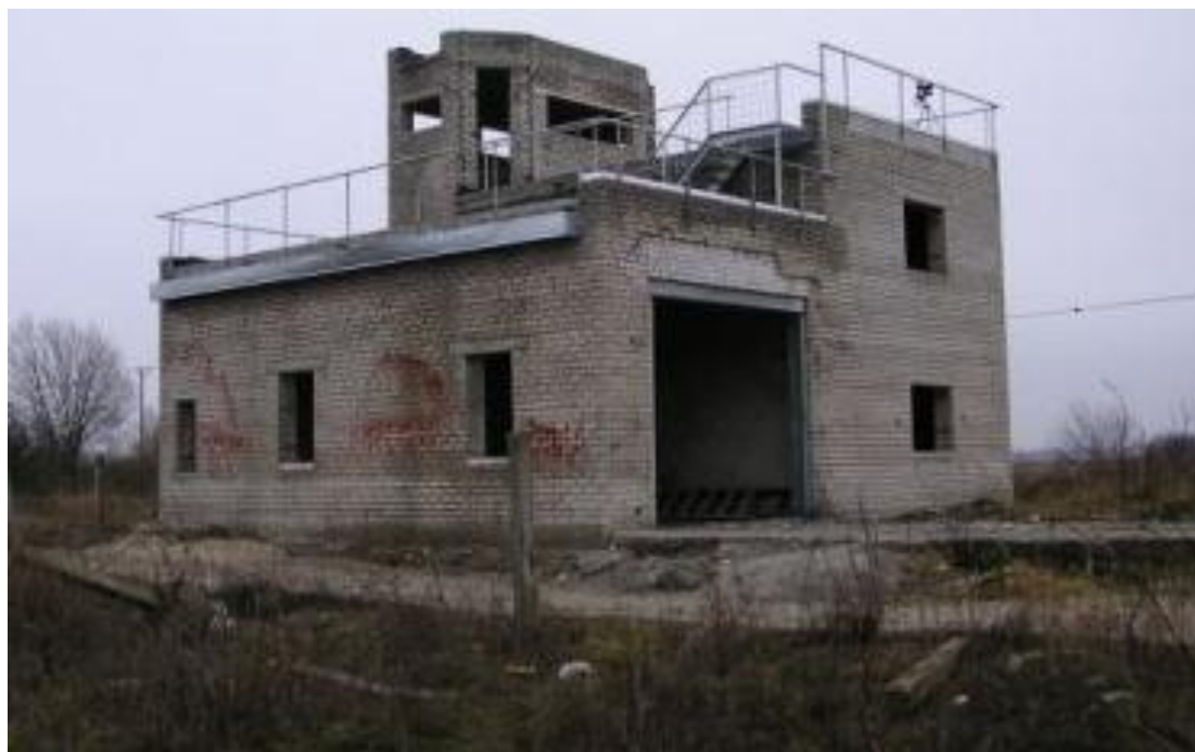
Foto 34. Paljassaare tehnilise vaatluse post. Hoone [4] vaade kirdest 2007.a. Foto: linnuhuvilised@lists.ut.ee . Metallist väravasilluse väljakiskumise tõttu on värava kohal osa kive alla kukkunud ning need on asendatud uutega. Ka sillus ja piidad on uued pandud. Betoonist aiapostid on veel alles. Allikas: http://www.eestiloodus.ee/uudistaja207.html .
