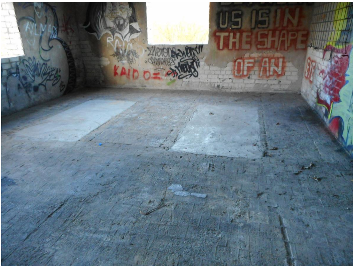
Foto 8. (97) Paljassaare tehnilise vaatluse post. Hoone [4] diisliruumis on märgatavad kahe diislialuse betooni täis valatud alused. Kuigi hoone välisseinad on kaetud terasvõredega väidetavalt maskeerimiseks, on võresid jätkunud ka mitmele siseseinale (paremal). Põrandplaadid on eemaldatud. Foto Jüri Pärn 16.10.2016.
