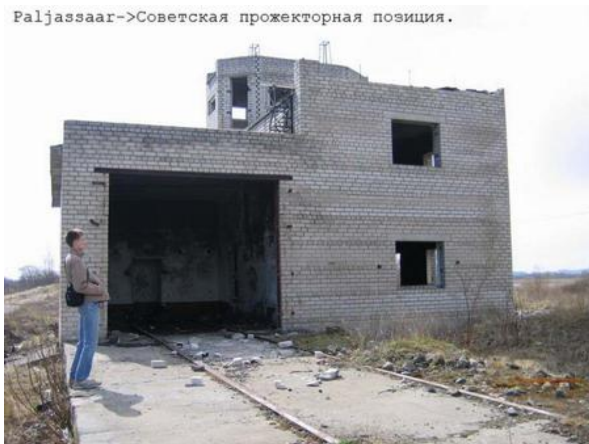
Foto 33. Paljassaare tehnilise vaatluse post. Hoone [4] vaade põhjast enne 15.06.2005.a. Veel on alles 2 radariantennialust, vana metalltrepp prožektoriruumi katusele, rauast väravasillus ja piidad, rõdupiirdevardad ning prožektorirööpad. Allikas: http://milind.livejournal.com/16865.html .
