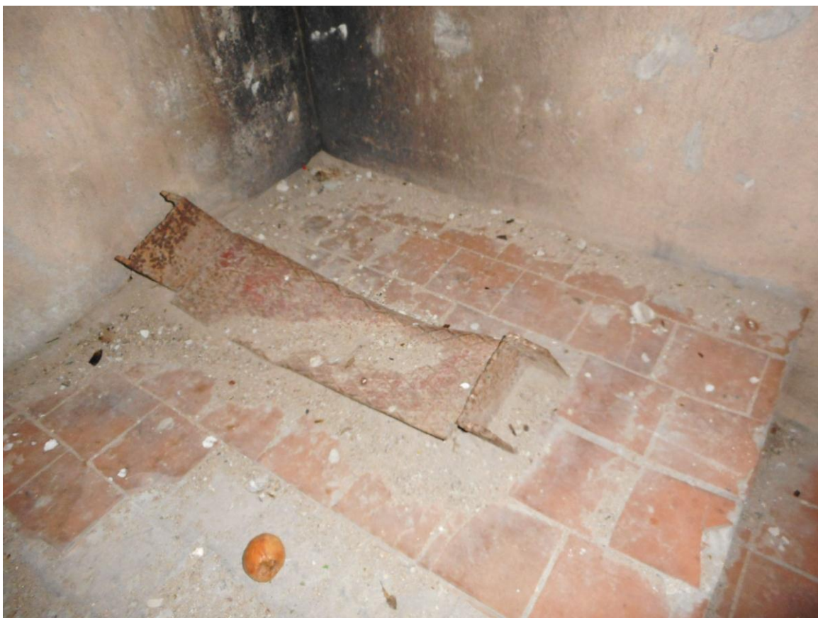
Foto 10. (106) Paljassaare tehnilise vaatluse post. Hoone [4] trepikoda. Selline jupike on algsest metalltrepi alusest alles jätud. Trepiesine oli kaunis kitsuke (u 30 cm). Foto Jüri Pärn 16.10.2016.
