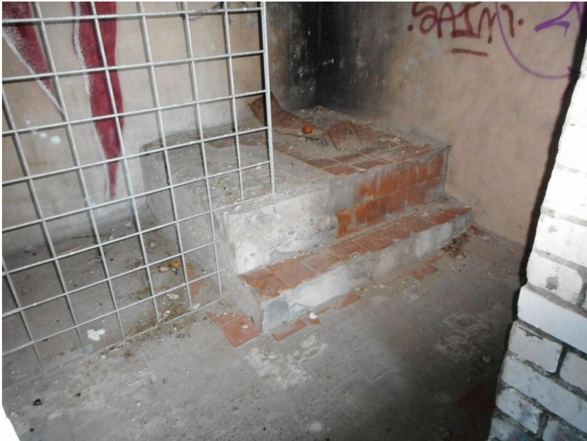
Foto 9. (105) Paljassaare tehnilise vaatluse post. Hoone [4] trepikoda esialgse metalltrepi alusega. Foto Jüri Pärn 16.10.2016.
