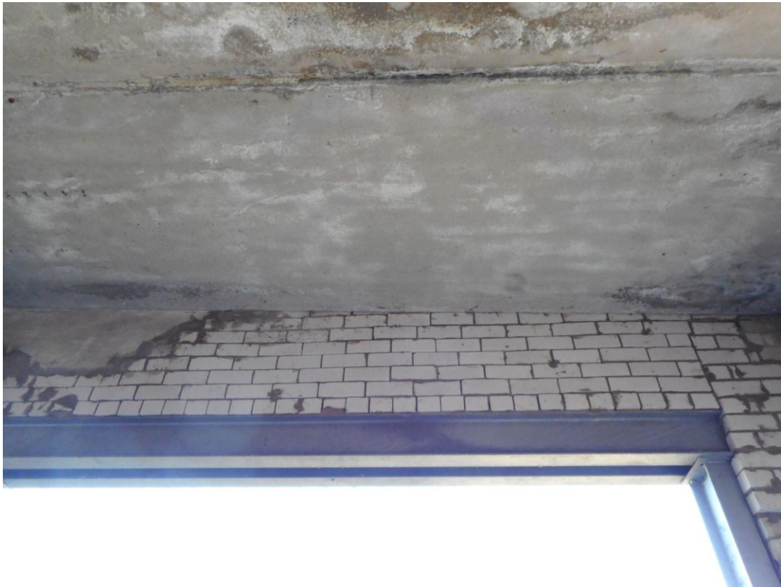
Foto 7. (80) Paljassaare tehnilise vaatluse post. Hoone [4] prožektoriruumi värava kohale ja kõrvale on laotud uued tellised. Ka metallpiidad ja -sillus on uued. Foto Jüri Pärn 16.10.2016.
