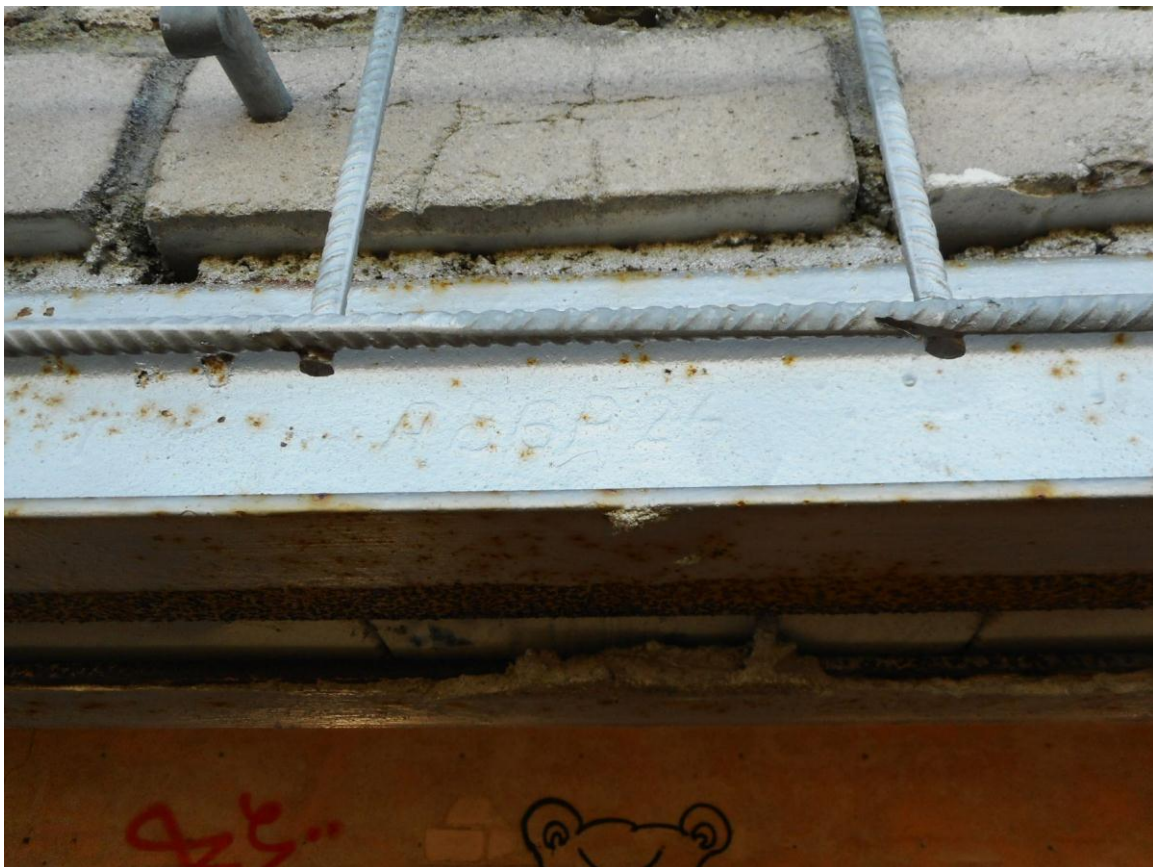
Foto 20. (172) Paljassaare tehnilise vaatluse post. Hoone [4] visuaalvaatlusposti ruumi aknasilluseks on 2 raudteerööbast, millest välimisel on kahes kohas kiri A 86P24(6?). Foto Jüri Pärn 16.10.2016.
