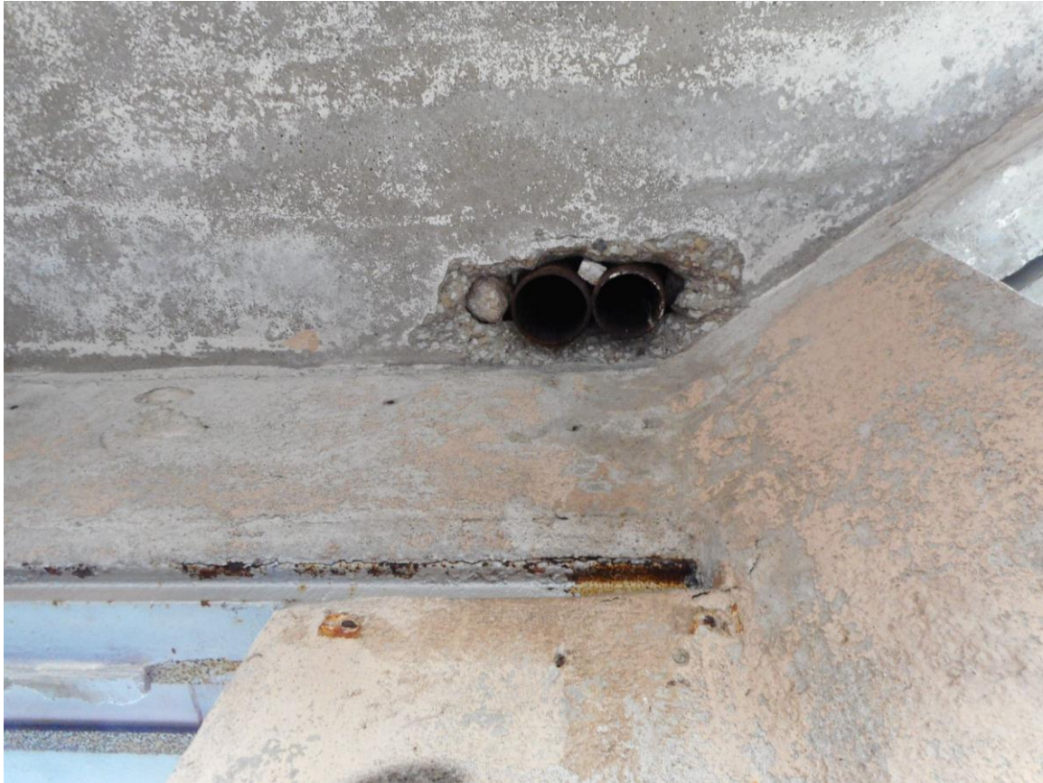
Foto 17. (163) Paljassaare tehnilise vaatluse post. Hoone [4] visuaalvaatlusposti ruumi laes on säilitatud radarijuhtmete torud. Foto Jüri Pärn 16.10.2016.
