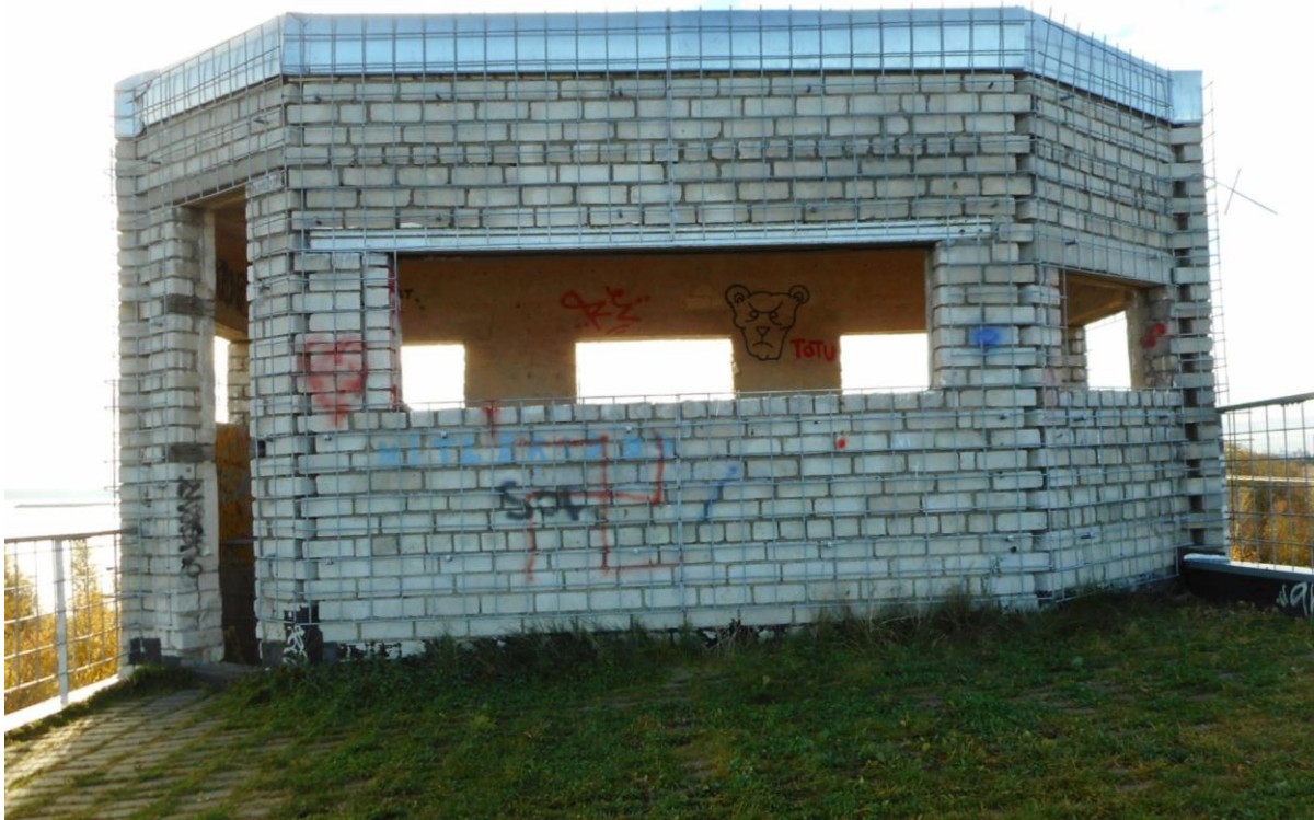
Foto 19. (169) Paljassaare tehnilise vaatluse post. Hoone [4] visuaalvaatlusposti ruum. Foto Jüri Pärn 16.10.2016.
