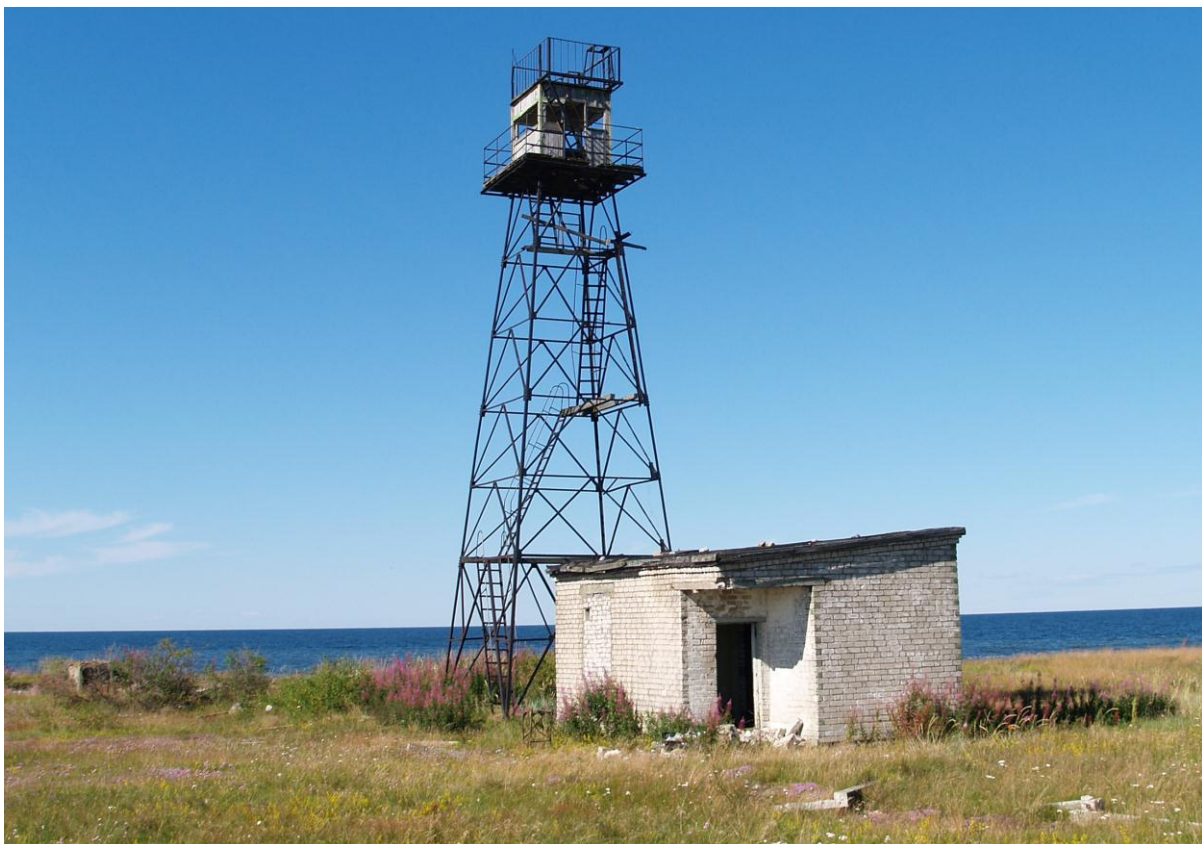
Foto 85. Neeme tehnilise vaatluse post. Torn [26] ja operaatorihoone [23] 2008.a. Vaade edelast. Ukseesine nurgapost on lammutatud, aga tellised on veel ukse ees väljas ja betoonpaneelid (horisontaalsed postid) hoiavad katusenurka üleval. Foto Ivo Kruusamägi 27.07.2008 (Wikipedia).
