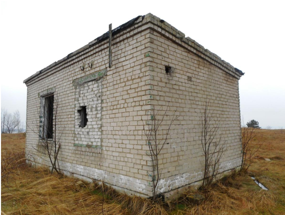
Foto 46. (498) Neeme tehnilise vaatluse post. Operaatorihoone [23]. Vaade kirdest. Foto Jüri Pärn 8.12.2016.
