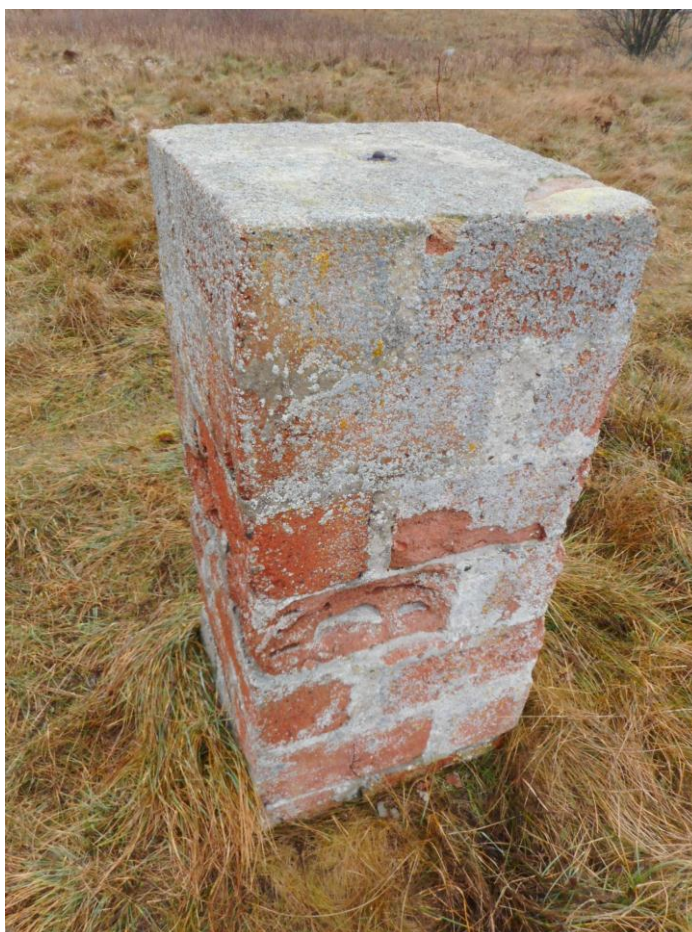
Foto 10. (220) Neeme tehnilise vaatluse post. Geodeesia ja Kartograafia Peavalitsuse (GUGK-i) poolt paigaldatud geodeetiline punkt [6], vaade kagust. Vormistatud postamendina, mille mõõtmed on u 1,5x0,6x0,6 m, umbes narva blokkide suurustest kividest, mis on arvatavasti seest õõntega (mitu lagunenu kivi on sellised nagu pildil kujutatud alt kolmas blokk). Objekti pole kantud EV geodeetiliste punktide andmebaasi ega ole ka märgitud ühelegi autorile teadaolevale kaardile. Foto Jüri Pärn 8.12.2016.
