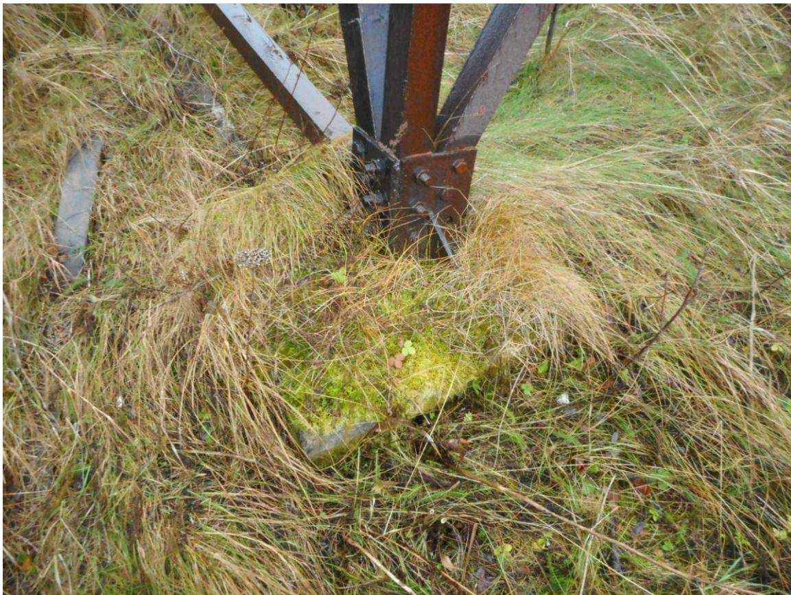
Foto 58. (561) Neeme tehnilise vaatluse post. Torni [26] kirdepoolne tald. Foto Jüri Pärn 8.12.2016.
