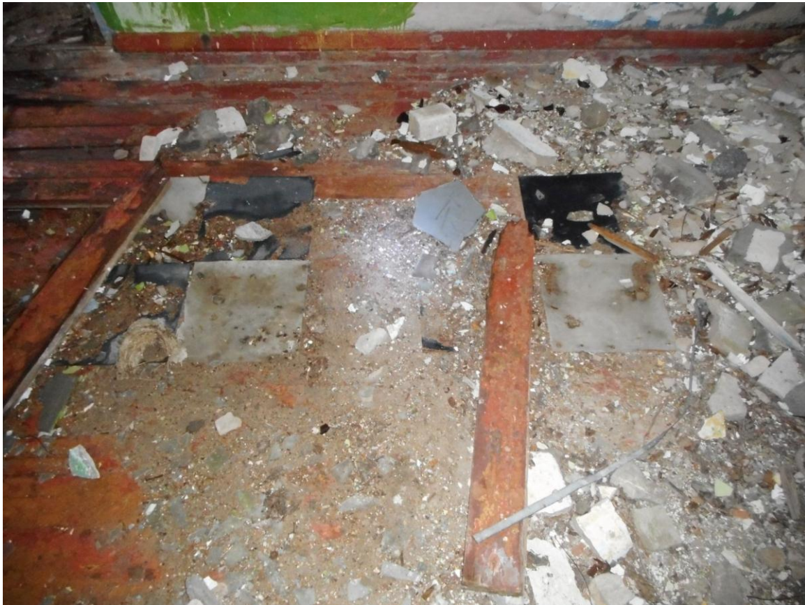
Foto 33. (423) Neeme tehnilise vaatluse post. Diislihoone [14] sisevaade. Lõunapoolsel ruumil on laudpõrand. Foto Jüri Pärn 8.12.2016.
