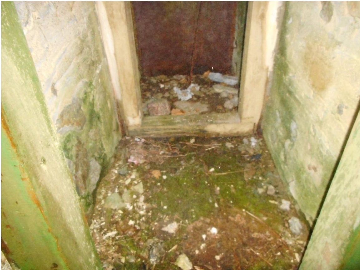
Foto 71. (819) Neeme tehnilise vaatluse post. Suur betoonvarjend [32]. Rauduks on lukus. Foto Jüri Pärn 8.12.2016.
