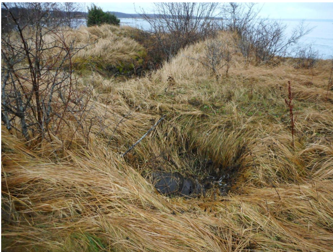
Foto 76. (781) Neeme tehnilise vaatluse post. Paekivi- või betoonäärtega nelinurkne auk [39] (u 1,5x1x1 m, kordoni lampkast??). Sees tsingitud I-kujulise profiiliga vitstega sõjaväevaad (läbi roostetanud). Tagapool ehitus [40] (dzoti või varjendina kasutatud kelder?). Foto Jüri Pärn 8.12.2016.
