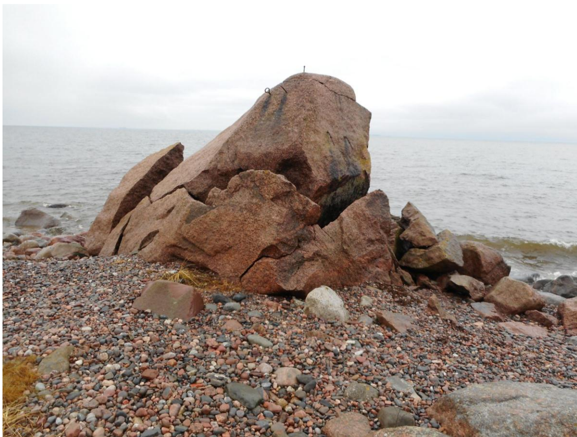
Foto 26. (259) Neeme tehnilise vaatluse post. Suur kivi vana (1930.a rajatud) tulepaagi kinnitusdetailidega [12]. Paremal atsetüleenikapi kinnituspoldid, vasakul redeli kinnitusdetailid (2 silmusega varrast või kruvi). Kivi kõrgus maa poolt on u 2,5 m, mere poolt vähemalt 4 m. Foto Jüri Pärn 8.12.2016.
