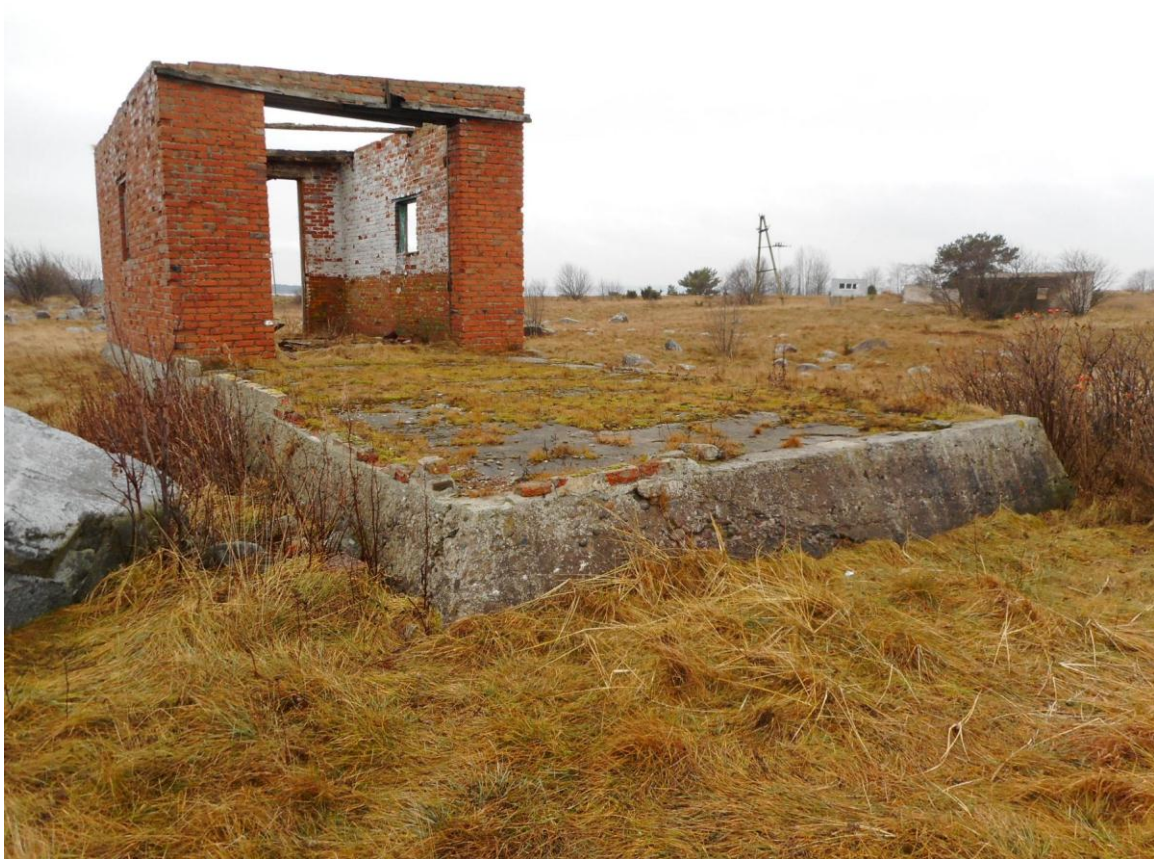
Foto 14. (257) Neeme tehnilise vaatluse post. Prožektorihoone ja -positsiooni [9–10] vaade põhjast. Foto Jüri Pärn 8.12.2016.
