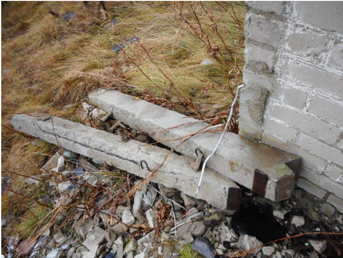
Foto 51. (869) Neeme tehnilise vaatluse post. Betoonpaneelid (horisontaalselt paigutatud postid), mis hoidsid üleval katusenurka operaatorihoone [23] välisukse ees. Teisel pool oli veel kaks samasugust. Foto Jüri Pärn 8.12.2016.
