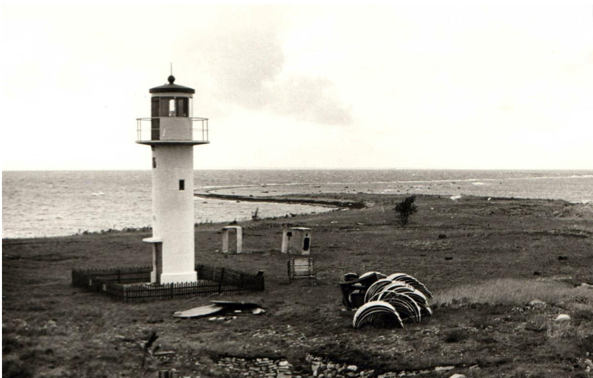
Foto 88. Neeme tehnilise vaatluse post. Ihasalu tuletorn [31] ja taamal Uitru säär (1974). Torn kõrval doti SPS-2 ja varjendi KVS-U detailid. Viimaseid on pildil tõenäoliselt kahe komplekti jagu (ühele komplektile on vaja 9 \times 3 = 27 laineplekist kaart, fotol on neid märksa rohkem). Esiplaanil paekividega ääristatud kaevik? Foto Rein Oras, Eesti Meremuuseum_782_30. Allikas: http://entsyklopeedia.ee/artikkel/ihasalu_poolsaar (25.12.2016).
