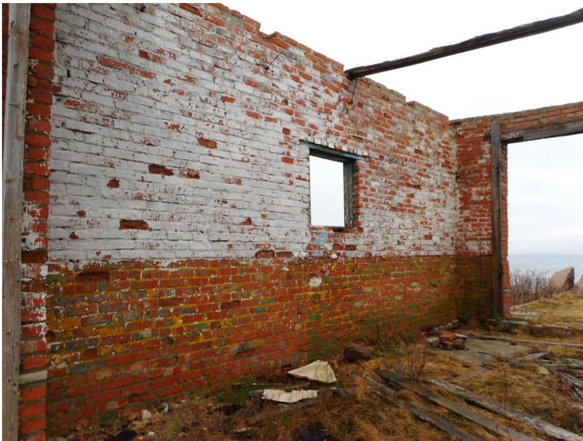
Foto 18. (308) Neeme tehnilise vaatluse post. Prožektorihoone [9] sisevaade. Foto Jüri Pärn 8.12.2016.
