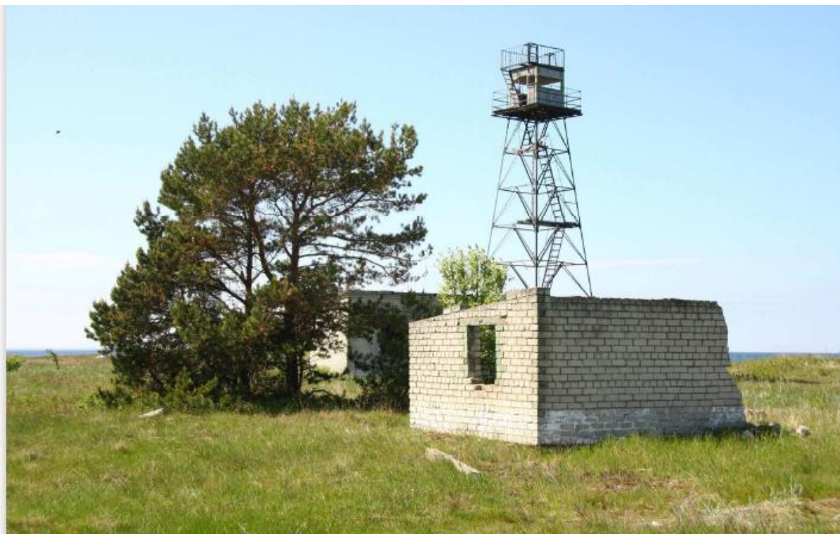
Foto 82. (Greenbelt_H_32_3_Nõukogude_piirivalve_hoonetekompleks_Neeme_.pdf) Neeme tehnilise vaatluse post. Vaade edelast 2010.a: hooned [20] (selle ees pikali aiapost), [23] ja torn [26]. Foto Allan Juha?, 2.6.2010. Allikas: DVD Eesti Rohevöö objektide inventeerimise materjalidega (autori valduses).
