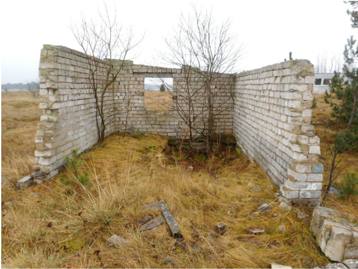
Foto 43. (454) Neeme tehnilise vaatluse post. Kütusehoidla [20], vaade põhjast. Põrandas on tsisterni ase? Väravapiidad on lammutatud (tsisterni väljavõtmiseks?). Foto Jüri Pärn 8.12.2016.
