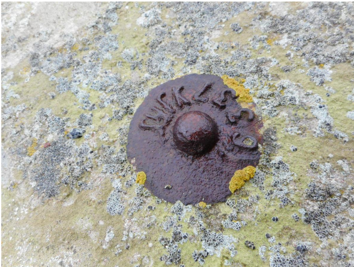
Foto 11. (219) Neeme tehnilise vaatluse post. Geodeesia ja Kartograafia Peavalitsuse (GUGK-i) poolt paigaldatud geodeetiline punkt [6] nr 6337, tsender lähivaates. Foto Jüri Pärn 8.12.2016.
