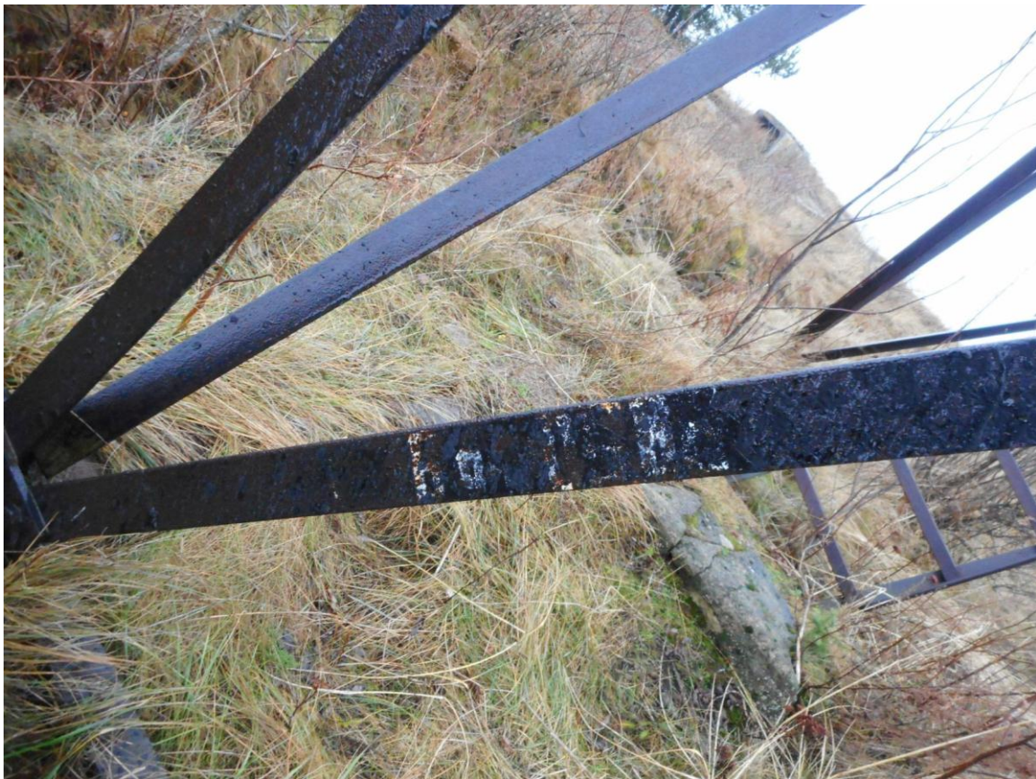
Foto 54. (479) Neeme tehnilise vaatluse post. Metallorni [26] maandustakistuse mõõtmise kirjed on veel kohati loetavad. Foto Jüri Pärn 8.12.2016.
