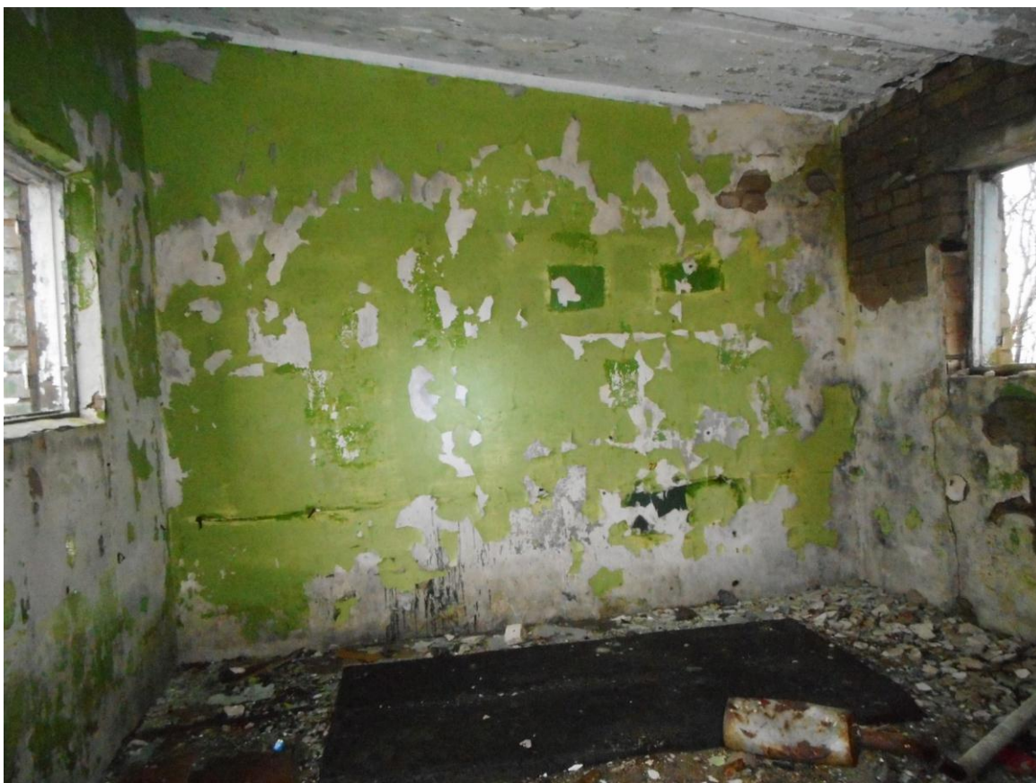
Foto 32. (410) Neeme tehnilise vaatluse post. Diislihoone [14] sisevaade. Foto Jüri Pärn 8.12.2016.
