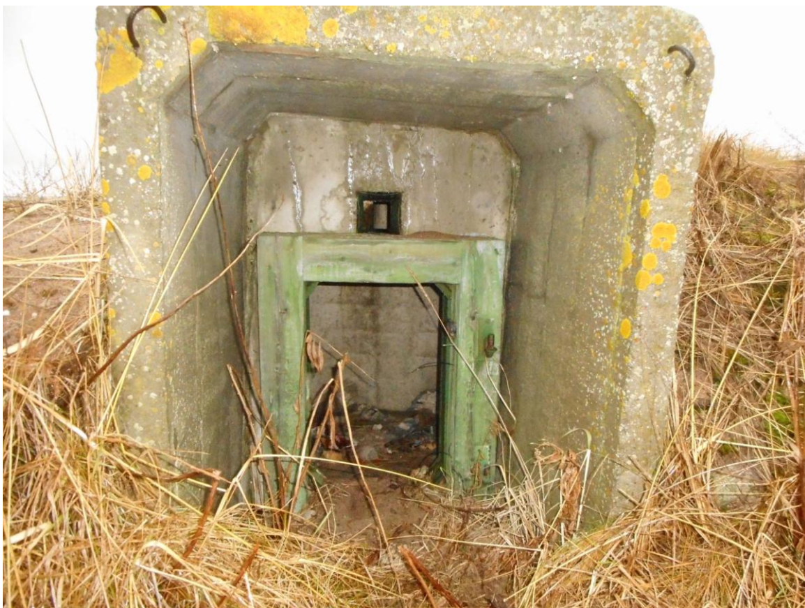
Foto 72. (873) Neeme tehnilise vaatluse post. Dott SPS-2 [33], vaade kagust. Kahel esikuga dotil ([29] ja [33]) on uksepiidad väga hästi säilinud. Foto Jüri Pärn 8.12.2016.
