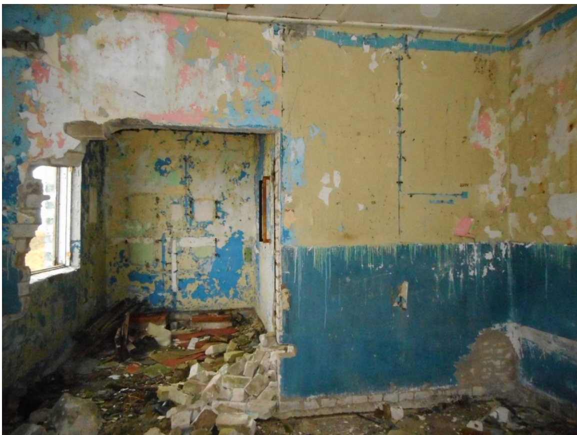
Foto 50. (541) Neeme tehnilise vaatluse post. Operaatorihoone [23] sisevaade. Foto Jüri Pärn 8.12.2016.
