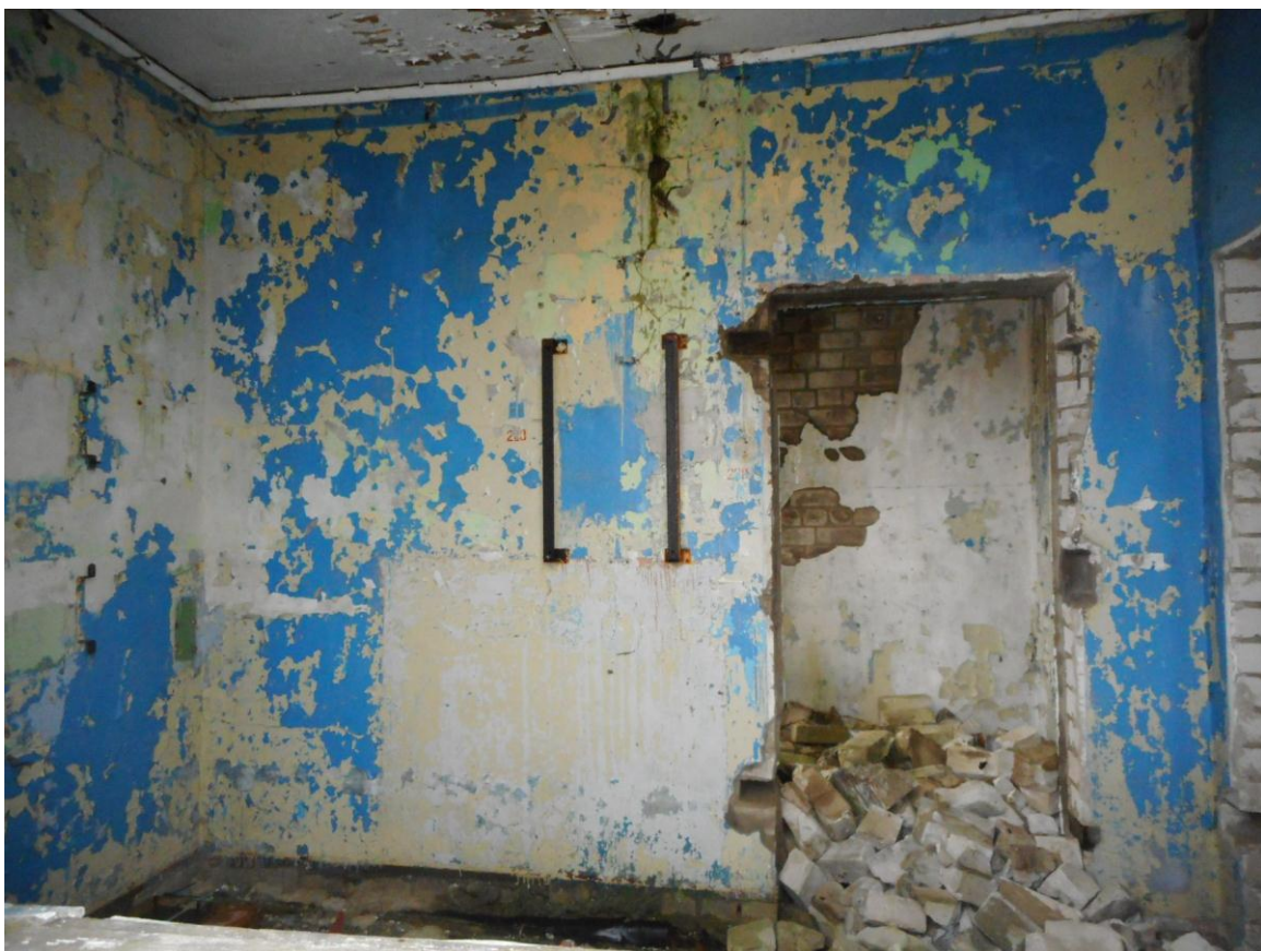
Foto 48. (513) Neeme tehnilise vaatluse post. Operaatorihoone [23] sisevaade. Foto Jüri Pärn 8.12.2016.
