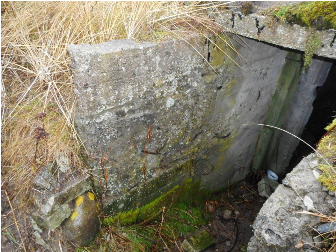
Foto 63. (582) Neeme tehnilise vaatluse post. Väike betoonvarjend [28], vaade sissepääsule edelast. Foto Jüri Pärn 8.12.2016.
