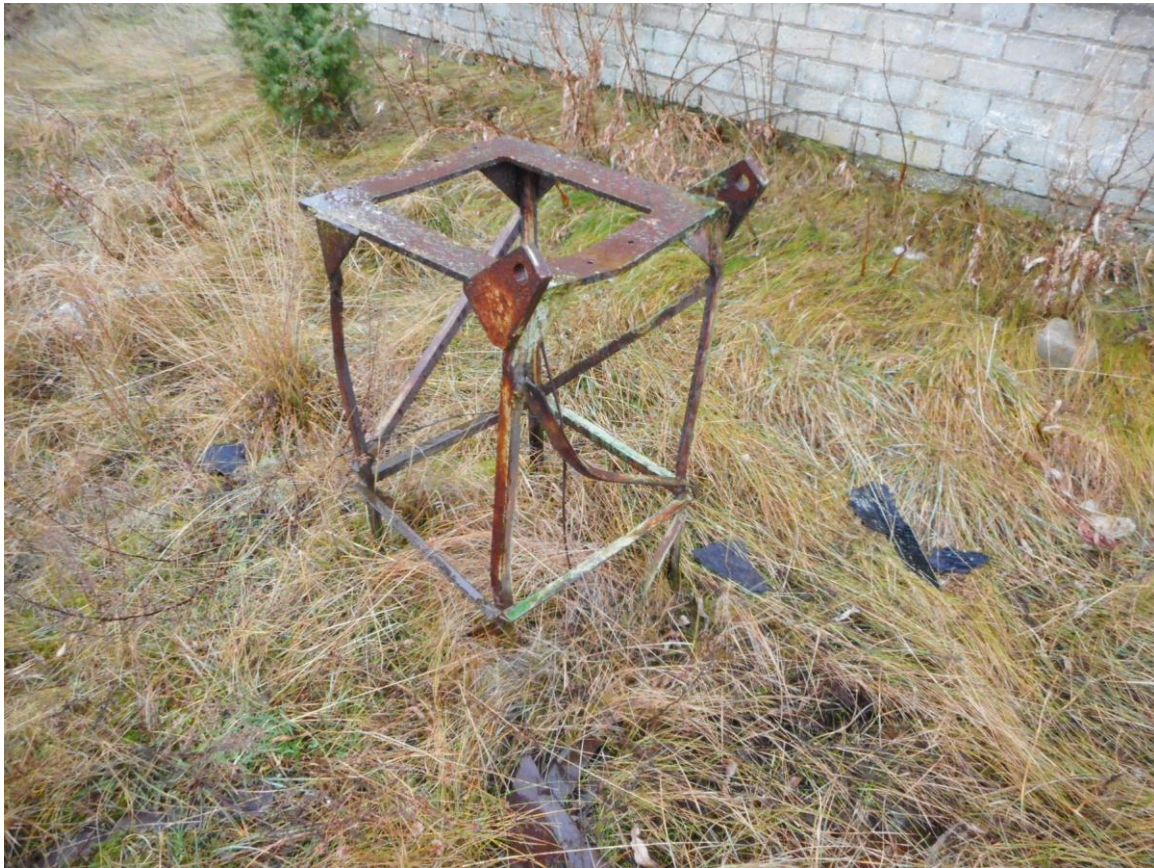
Foto 53. (941) Neeme tehnilise vaatluse post. Raadiojaama masti alus [25]. Foto Jüri Pärn 8.12.2016.
