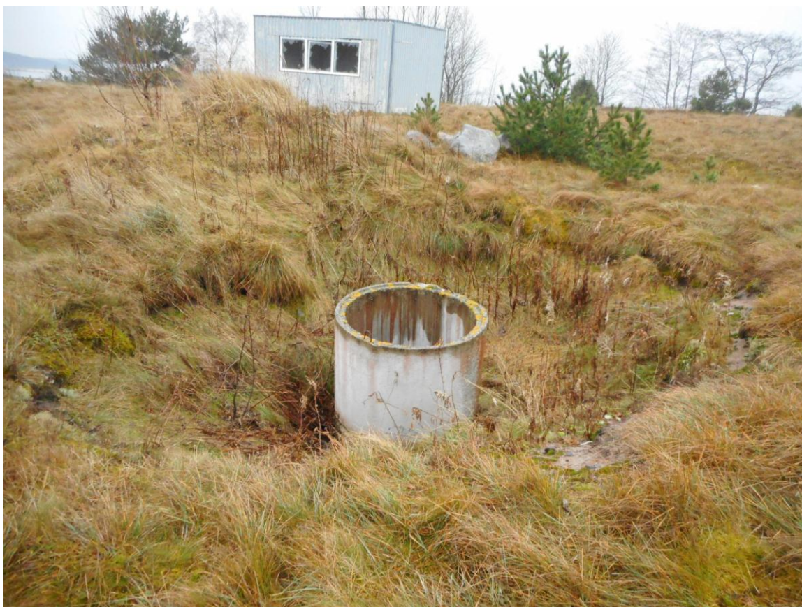
Foto 38. (616) Neeme tehnilise vaatluse post. Uus salvkaev [18] ja uus soojak [19]. Rajatud/paigaldatud ajavahemikus 2002–2005. Vaade kirdest. Foto Jüri Pärn 8.12.2016.
