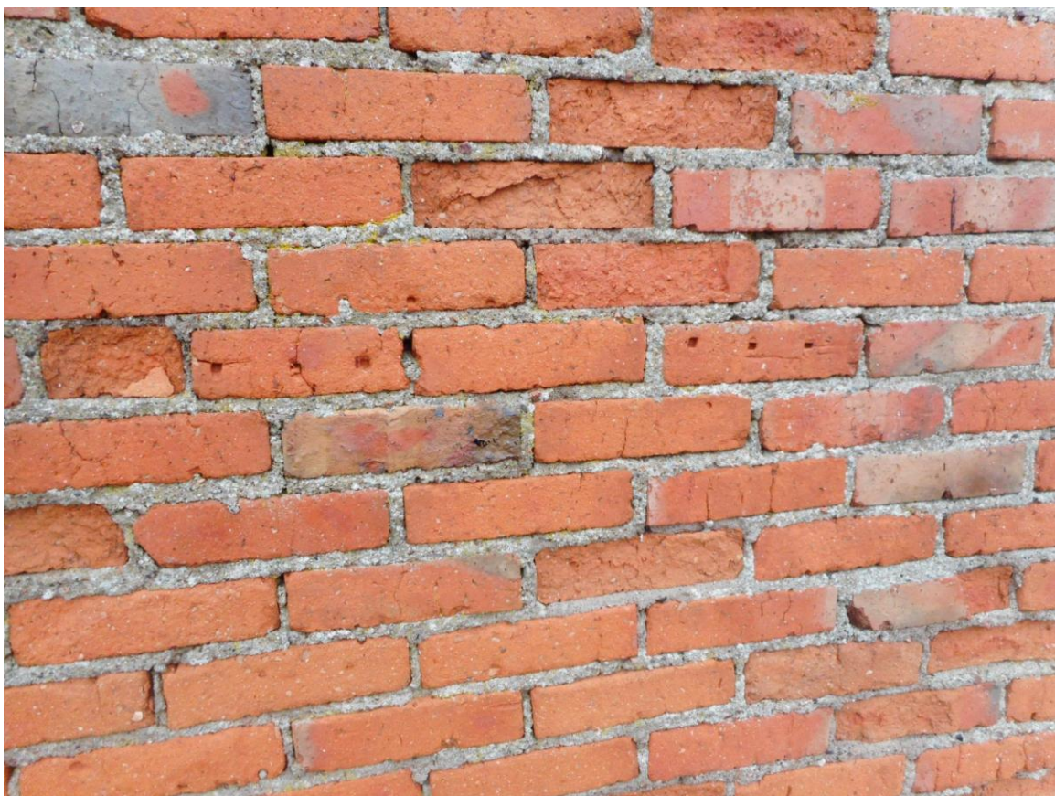
Foto 16. (316) Neeme tehnilise vaatluse post. Prožektorihoonne [9] tellisseina lähivaade idast. Kümmetel tellistel on külje peal 3 nelinurksset auku. Foto Jüri Pärn 8.12.2016.
