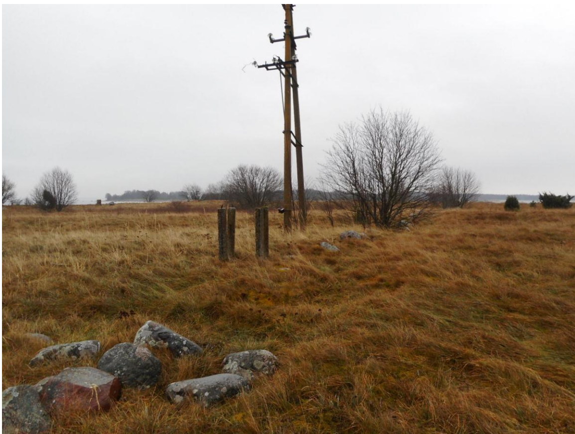
Foto 34. (381) Neeme tehnilise vaatluse post. Kiviaed [4], alajaama betoonist aluspostid [15] ja keskpingeliini A-kujuline ankrumast [16]. Taga vasakul paistab GUGK-i paigaldatud geodeetiline punkt [6]. Foto Jüri Pärn 8.12.2016.
