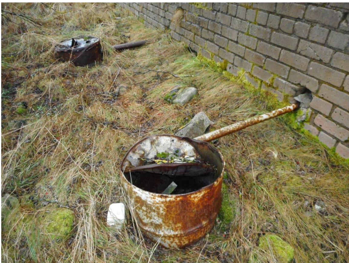
Foto 28. (375) Neeme tehnilise vaatluse post. Diislihoone [14]. Auklike otstega 200-l vaadid hoone idaküljel, diislite heitgaaside sissejuhtimiseks. Foto Jüri Pärn 8.12.2016.
