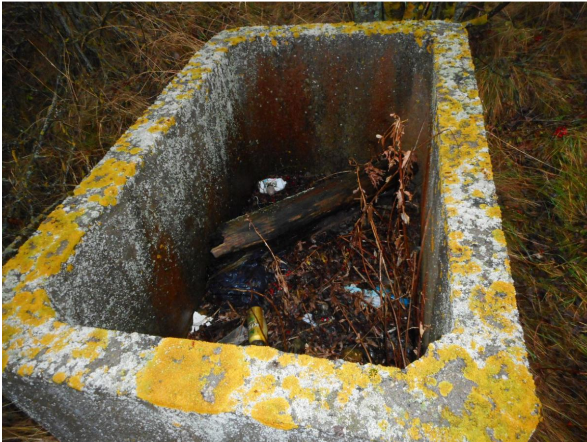
Foto 67. (883) Neeme tehnilise vaatluse post. Doti SPS-2 [30] eemaldatud esik [31] — kasutusel prügikastina. Foto Jüri Pärn 8.12.2016.
