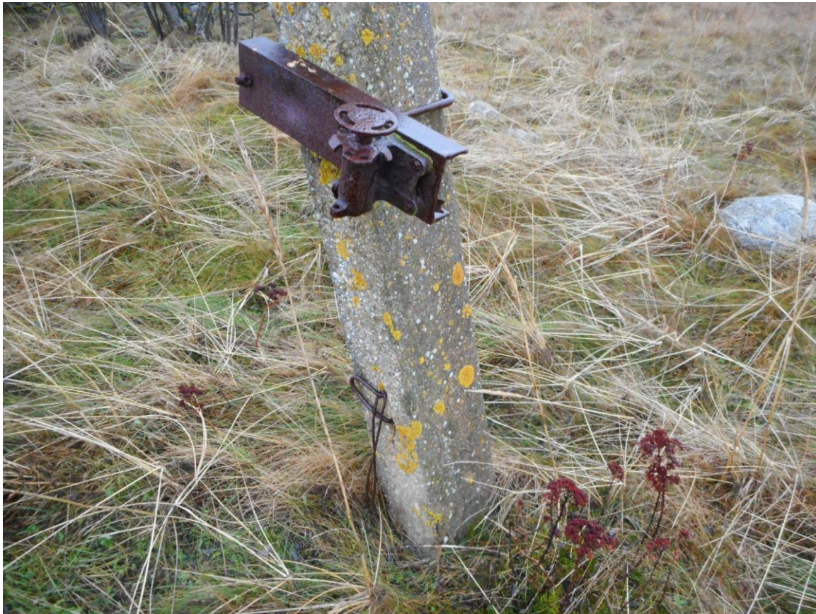
Foto 35. (438) Neeme tehnilise vaatluse post. Ankrumasti [16] lülitusseadme detail. Foto Jüri Pärn 8.12.2016.
