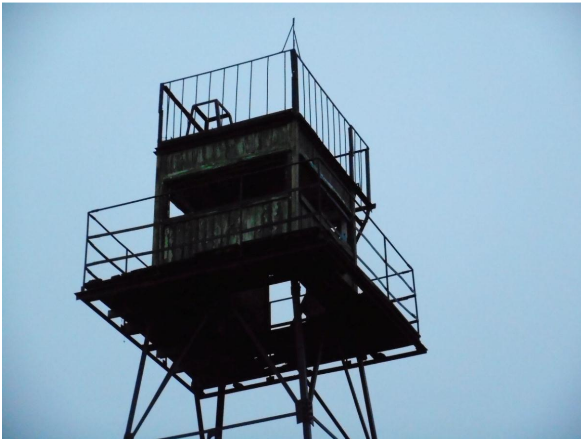
Foto 59. (567) Neeme tehnilise vaatluse post. Torn [26] putka. Põrand on säilinud ainult rõdul. Foto Jüri Pärn 8.12.2016.
