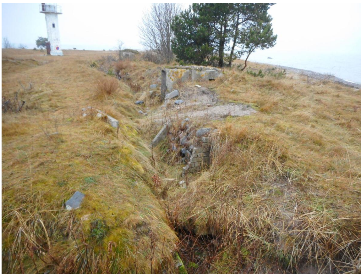
Foto 62. (575) Neeme tehnilise vaatluse post. Kividega ääristatud ja silikaatnišsidega kaitsekraavi [27] ida-lääne-suunaline lõik. Merepoolsel küljel on 3 doti SPS-2 ja 4 silikaatkividest u 1,2 m kõrgust nišši. Foto Jüri Pärn 8.12.2016.
