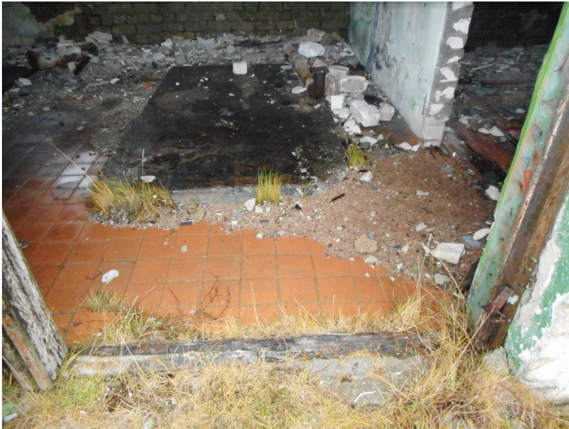
Foto 31. (403) Neeme tehnilise vaatluse post. Diislihoone [14] sisevaade. Foto Jüri Pärn 8.12.2016.
