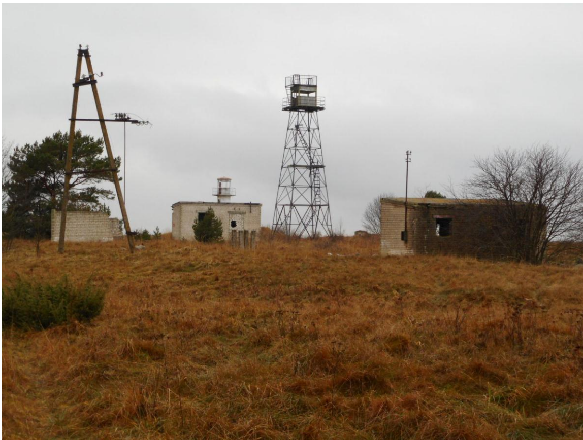
Foto 12. (231) Neeme tehnilise vaatluse post. Vaade edelast (suurendusega) — objektid [20], [16], [23], [15], [26], [29], [4], [14]. Foto Jüri Pärn 8.12.2016.
