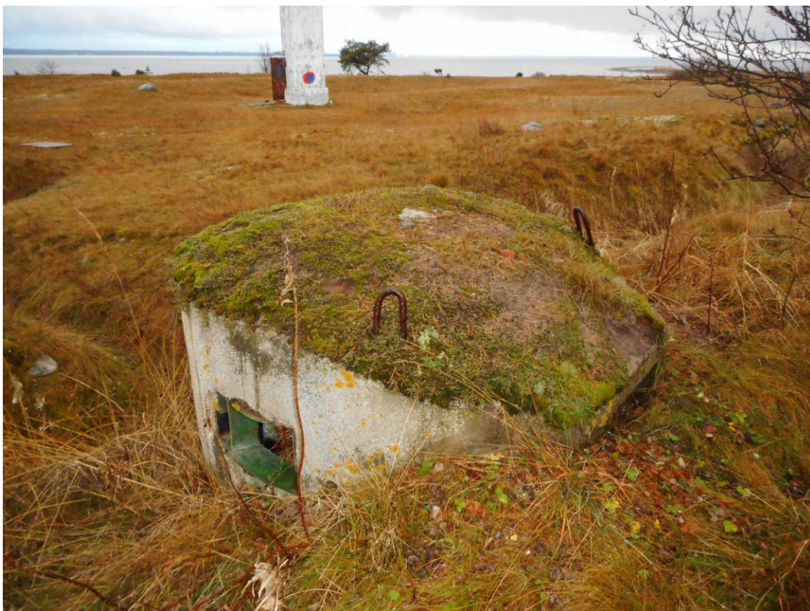
Foto 68. (889) Neeme tehnilise vaatluse post. Dott SPS-2 [30], vaade kirdest. Taga tulepaak [35]. Foto Jüri Pärn 8.12.2016.
