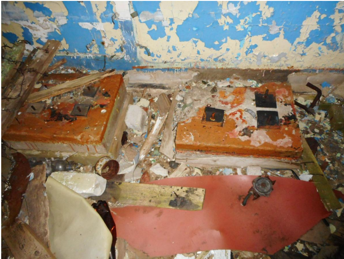
Foto 49. (537) Neeme tehnilise vaatluse post. Operaatorihoone [23] sisevaade. Kaks väga hästi säilinud betoonalust lõunapoolses ruumis. Foto Jüri Pärn 8.12.2016.
