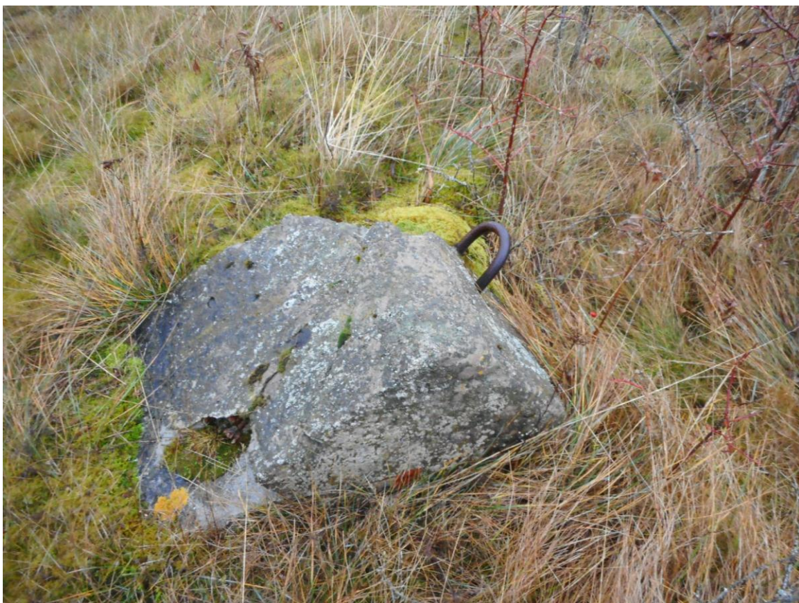
Foto 56. (492) Neeme tehnilise vaatluse post. Torni [26] loodepoolne tõmmitsaankur. Neid on veel 3 tk, kõik üsna hästi säilinud (aga trossid on „jalutama läinud”). Foto Jüri Pärn 8.12.2016.
