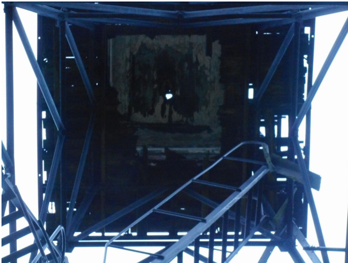
Foto 61. (953) Neeme tehnilise vaatluse post. Torn [26] altvaade suurema suurendusega: katuses paistab vaid pisike auk, ent ometigi on torniruumi põrand ära mädanenud ja alla kukkunud (või kukutatud). Foto Jüri Pärn 8.12.2016.
