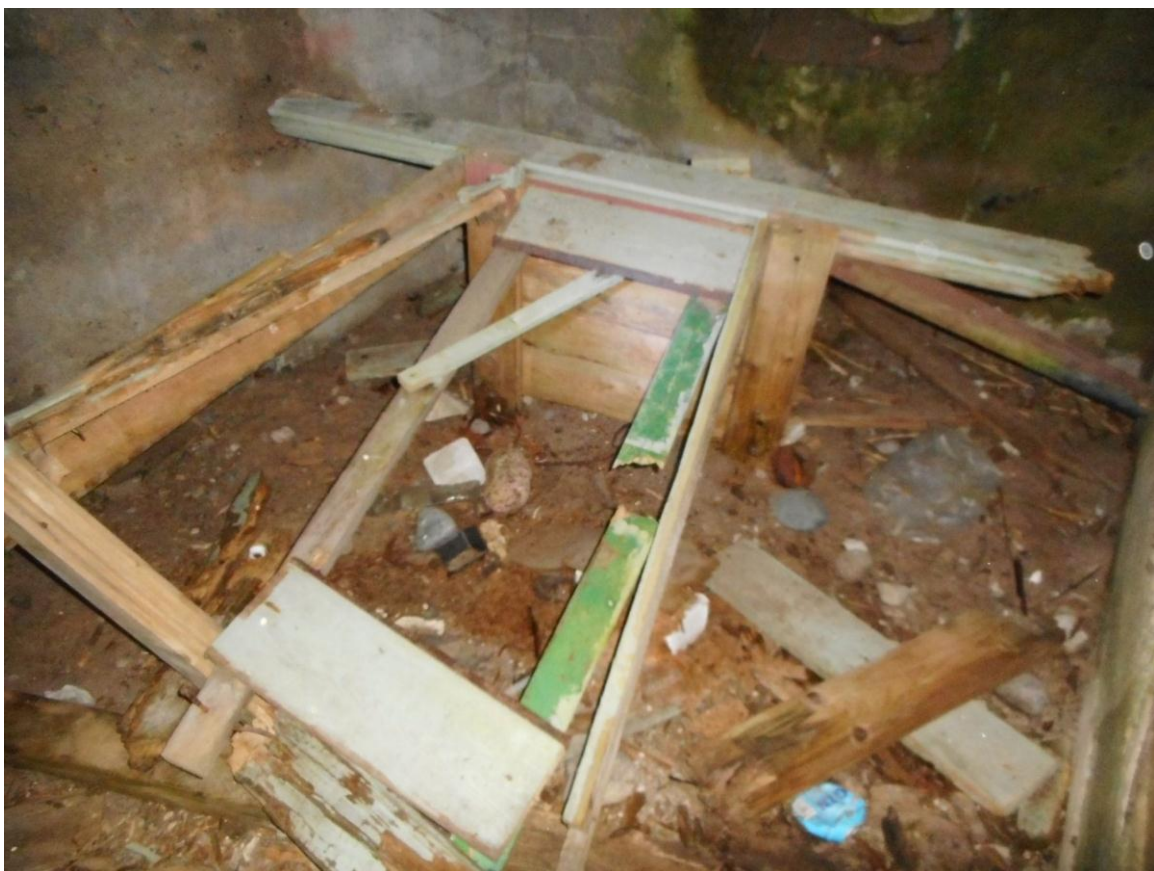
Foto 64. (591) Neeme tehnilise vaatluse post. Väike betoonvarjend [28] (u 4,5x2x2 m), sisevaade. Tagaseinas on u 50x50 cm ava. Foto Jüri Pärn 8.12.2016.
