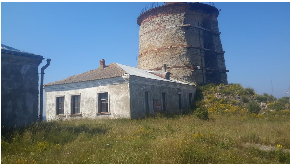
Foto 14. Keri tuletorni kompleks [7].
