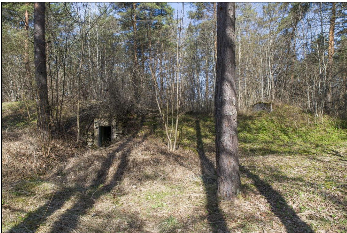
Foto 57 (). Aila varukomandopunkt Saue vallas. Varjend [6]. Sissepääsust vasakul säilinud osa, paremal lammutatud osa, alles ainult otsaseinad.
