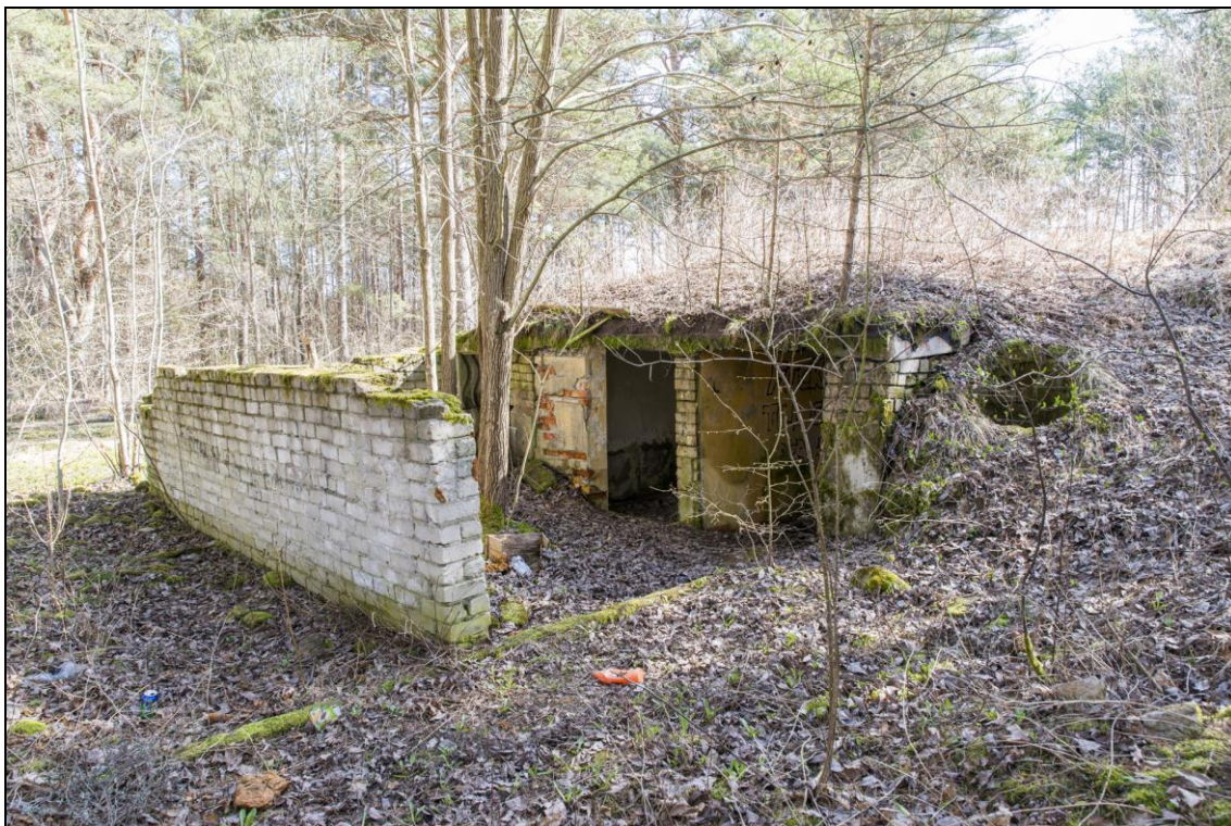
Foto 17 (354). Aila varukomandopunkt Saue vallas. Varukomandopunkt [1], tagumine (läänepoolne) sissepääs.
