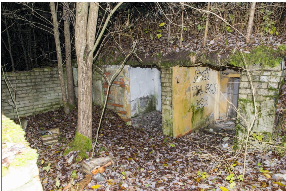
Foto 16 (063). Aila varukomandopunkt Saue vallas. Varukomandopunkt [1], tagumine (läänepoolne) sissepääs.
