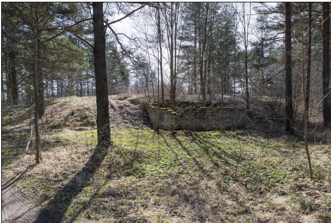
Foto 21 (376). Aila varukomandopunkt Saue vallas. Varukomandopunkt [1], vaade sissesõiduteelt, paistab läänepoolne sissepääs.
