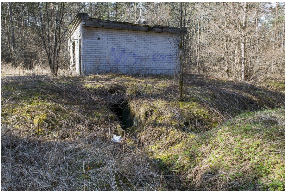
Foto 28 (302). Aila varukomandopunkt Saue vallas. Hoone [2] all on täiskelder (varjend), sissepääs on hoone põhjaküljel kaevikus.. Foto Mart Mõniste 3.05.2018
