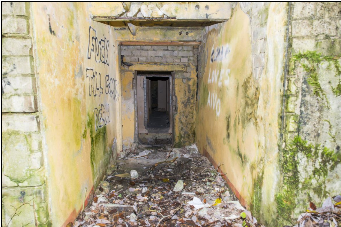
Foto 15 (057). Aila varukomandopunkt Saue vallas. Varukomandopunkt [1], tagumine (läänepoolne) sissepääs.
