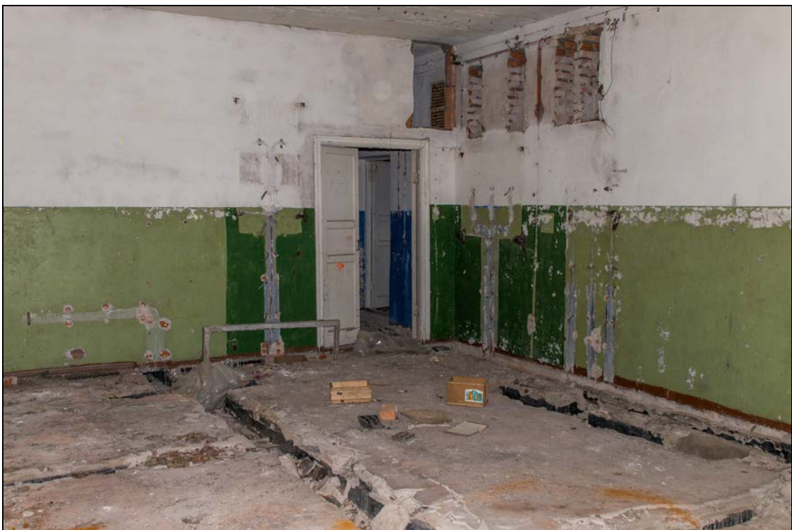
Foto 10 (2068). Pärisea instituut. Peahoone [1] paljudes ruumides on põrandas kaablikanalid. Foto Mart Mõniste 24.04.2014
