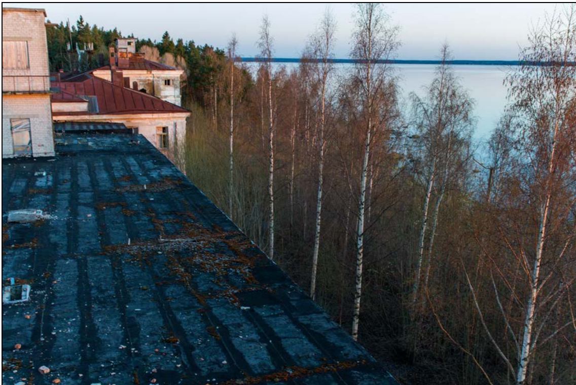
Foto 18 (2116). Pärissaare instituut. Vaade peahoone [1] uue osa neljandalt korruselt. Foto Mart Mõniste 24.04.2014
