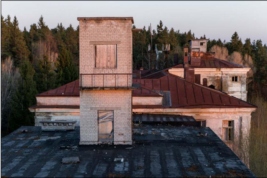
Foto 17 (2115). Pärissaare instituut. Vaade peahoone [1] uue osa neljandalt korruselt. Foto Mart Mõniste 24.04.2014
