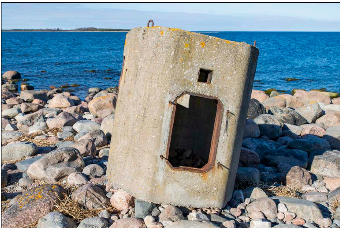
Foto 27 (032). Kaberneeme TVP. Dott SPS-2 [3]. Tambur, uks ja laskeavade luugid on kadunud. Foto Mart Mõniste 4.04.2017
