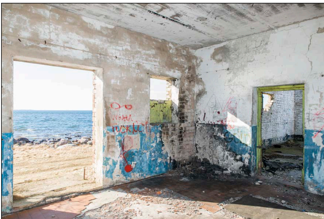
Foto 14 (053). Kaberneeme TVP komplekshoone [1]. Foto Mart Mõniste 4.04.2017
