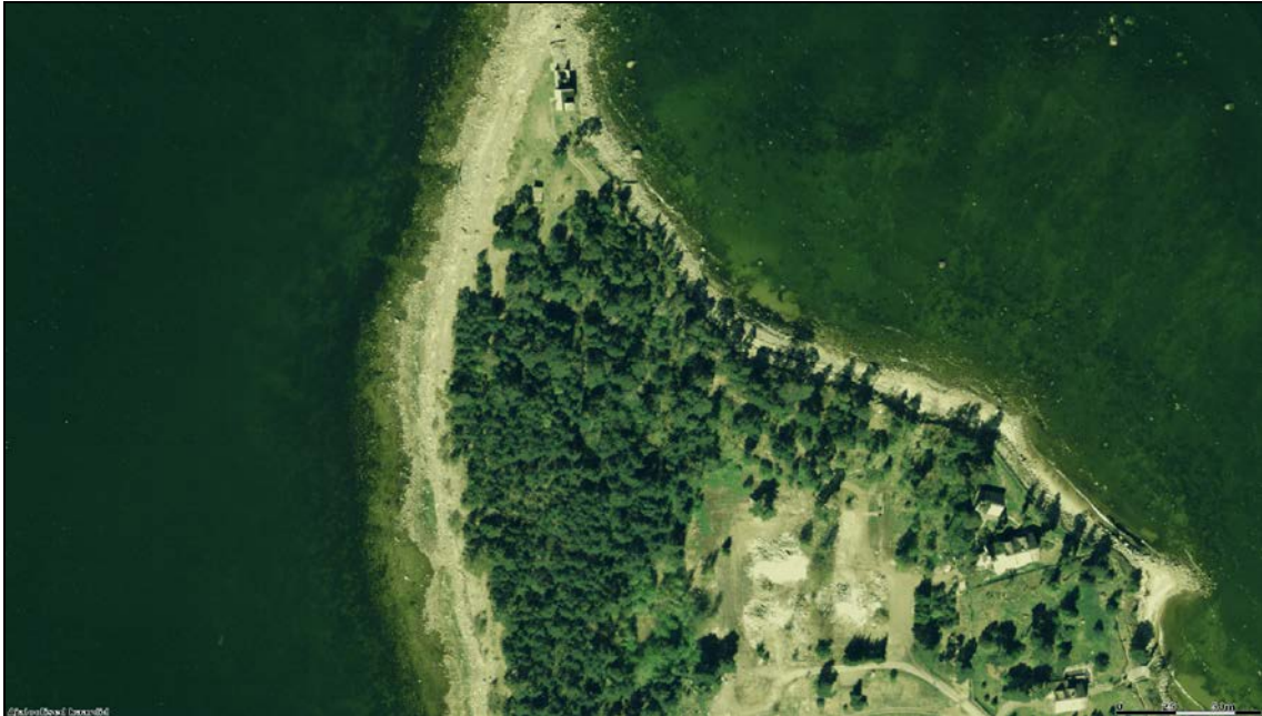
Skeem 9. Kaberneeme tehnilise vaatluse post 2009. aasta aerofotol. Kordon on lammutatud. Allikas: Maa-ameti Geoportaal
