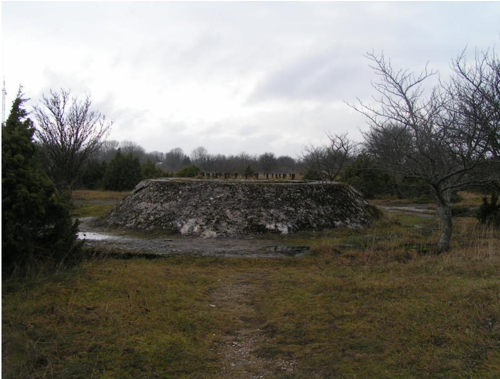
Foto nr 1 Suurtükipositsioon nr 1. Vaade mere poolt.
