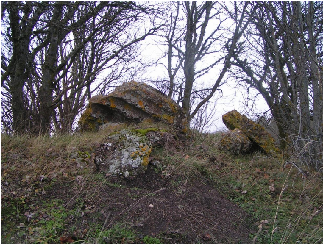
Foto nr 22: Sama, õhitud betoonlagi.
