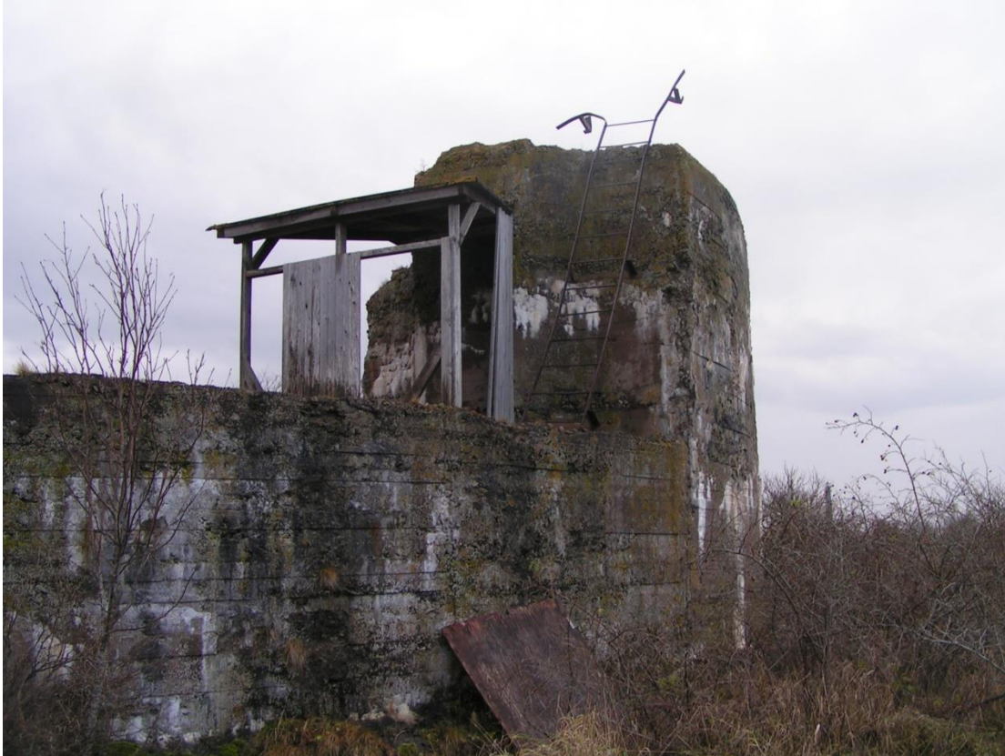
Foto nr 7: Sama, vaade põhjast.
