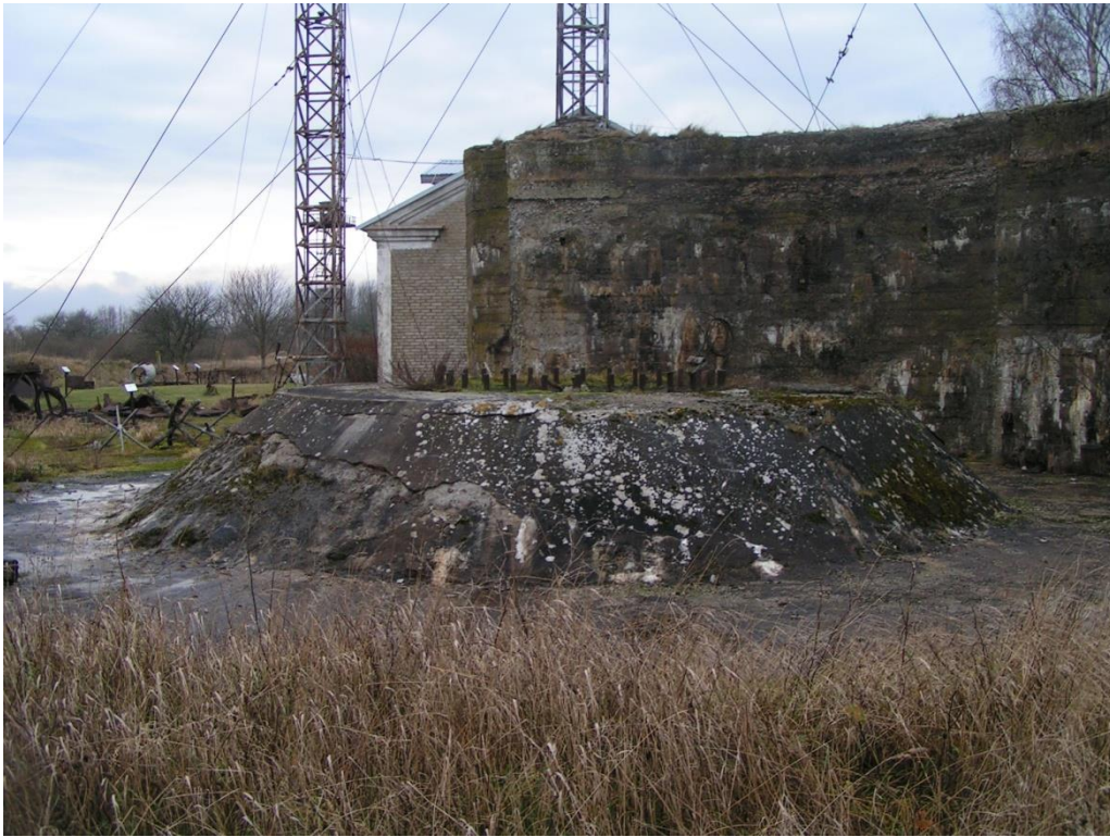
Foto nr 9: Positsiooni nr 3 üldvaade läänest.
