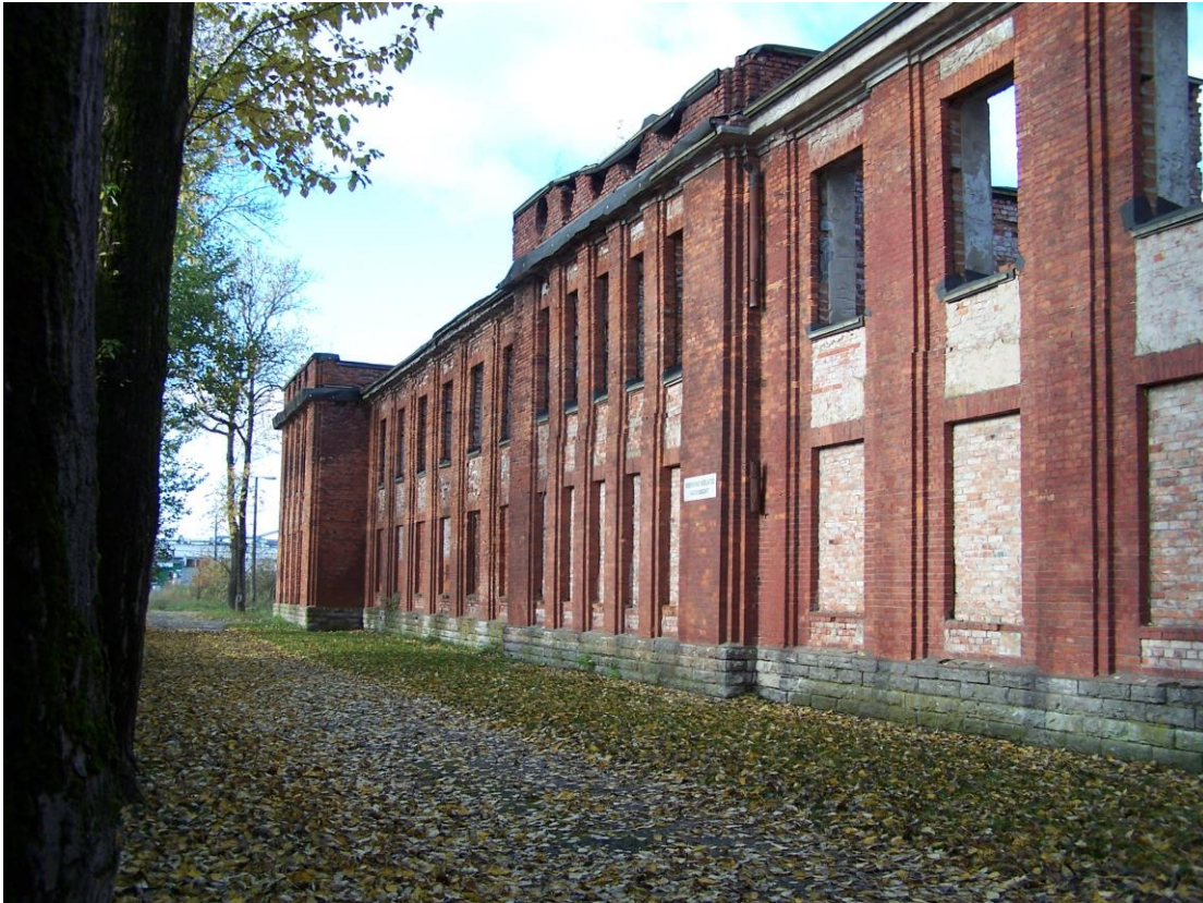
Foto 1 - Kasarmu lõunakülje läänetiib, vaade idast.
