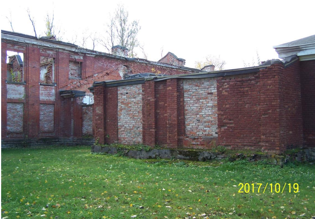
Foto 9 - Hoone keskelt põhja suunas avanev ristuv tiib, vaade kirdest.
