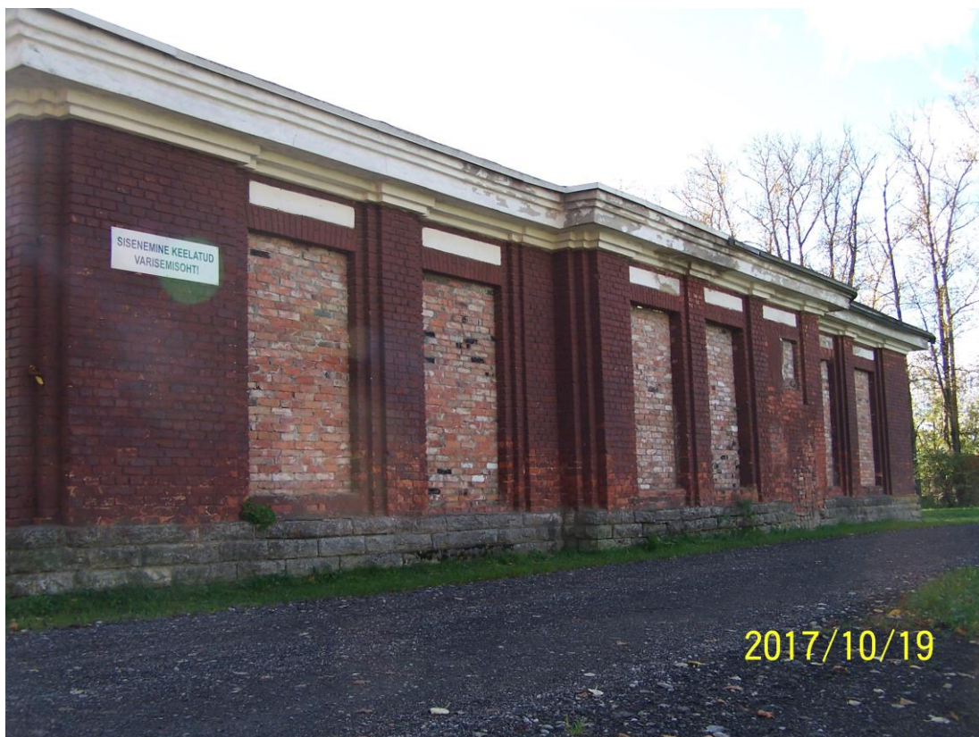
Foto 15 - Hoone köögiosa põhjasein, vaade kirdest. Fotol näha eenduva keskosa ümber ehitatud aknaava.
