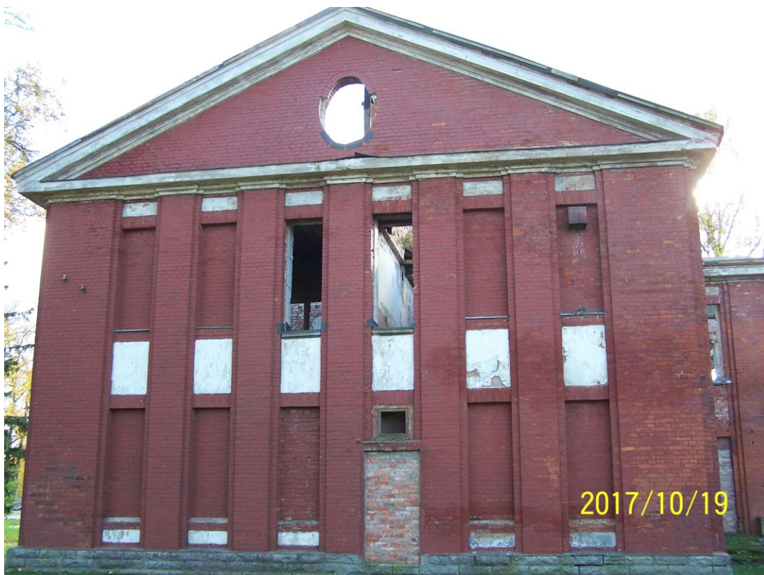
Foto 7 - Kasarmu idapoolne ristuv tiib, vaade loodest.
