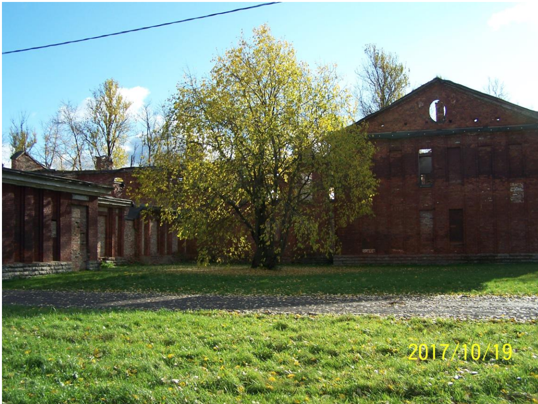
Foto 3 - Kasarmu põhjakülje läänetiib ning ristuvad osad. Vaade loodest.
