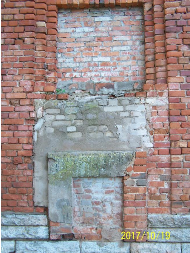
Foto 17 - Hoone läänetiiva läänepoolne välissein, vaade edelast. Fotol näha kaubaava parandustööd.
