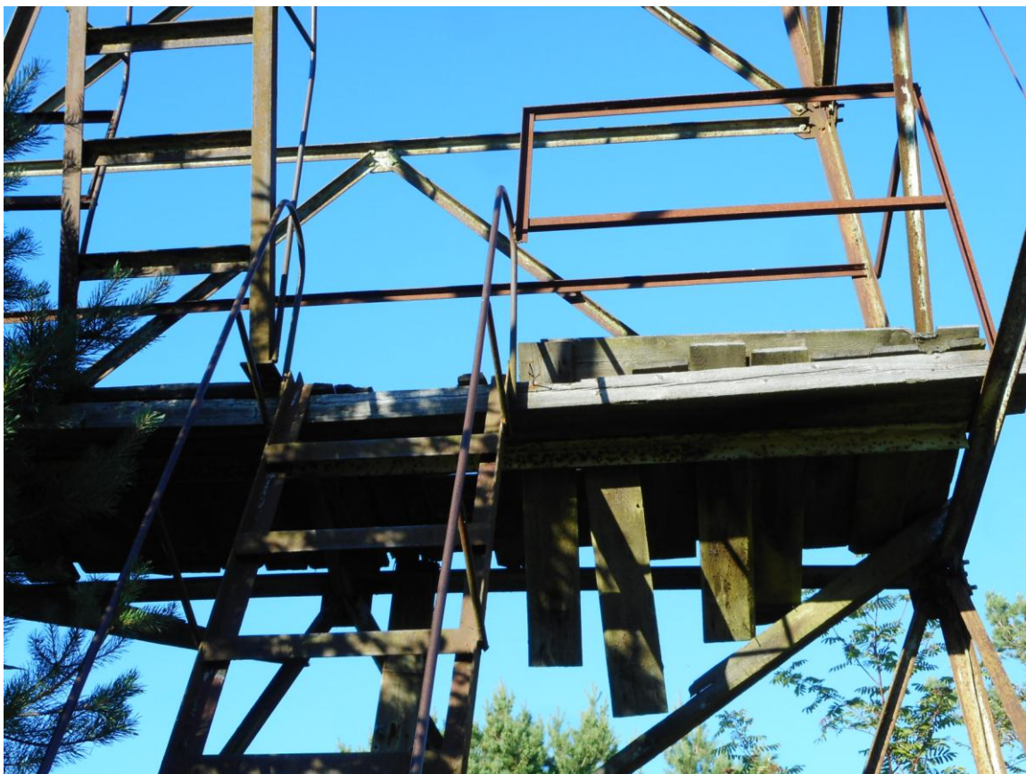
Foto 6. Tornis alumine vaheplatvorm (21.07.2017). Tagumine aluspruss on ära mädanenud ja ripakil, ¼-tollised aluslauad lahti vajunud, aga veel tugevad.
