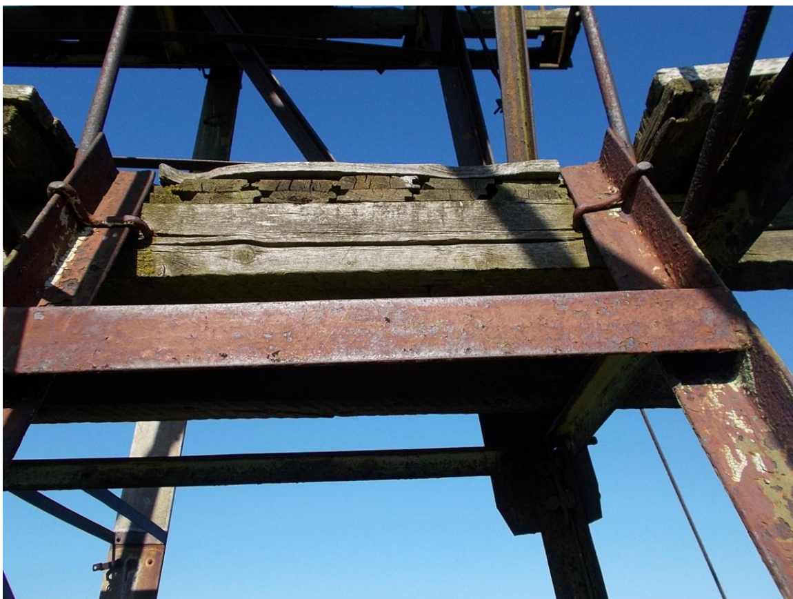
Foto 9. Torni ülemine vaheplatvorm (9.05.2016). Aluskihina on kasutatud voodrilaudu, selle peal tollised hõõveldatud laudad.
