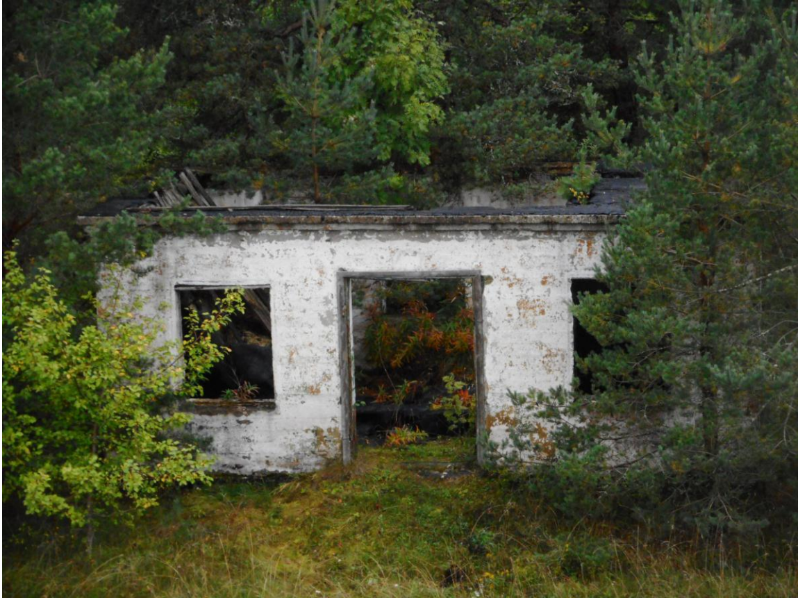
Foto 19. Diisli- ning akuhoone (joonised 3–4, hoone 4). Sees on 2 erineva konstruktsiooniga betoonist diisliialust. Sisustusest on säilinud metallriiul või kandur ja puidust akuriil/laud. Katus sisse langenud, seinad tugevad.
