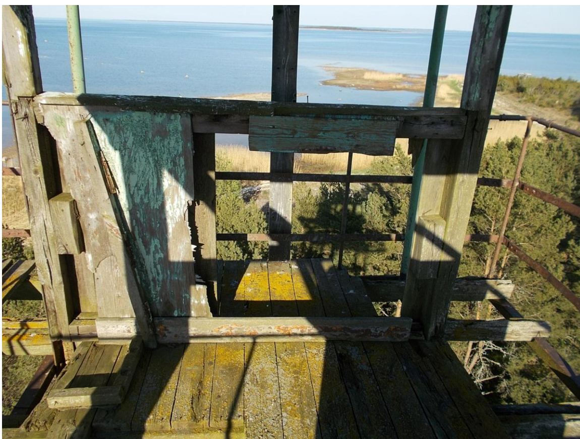
Foto 13. Vaatlusruumi sisevaade. Vasakul relvapüramiidi säilmed (2 automaadikohta, 3 uksehinge) (9.05.2016).
