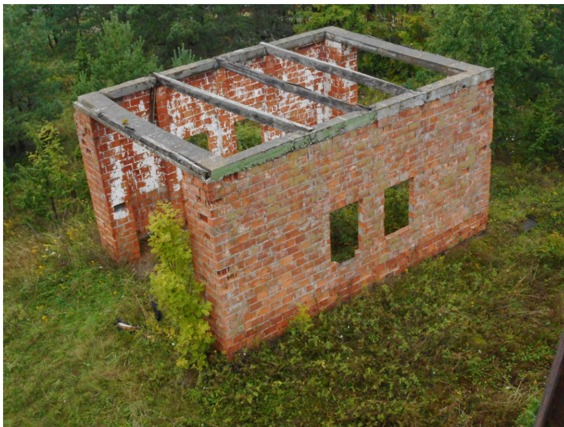
Foto 18. Prožektorihooone koos -positsiooniga (joonised 3–4, hoone 3). Prožektori relsid on suuremalt jaolt säilinud (üks rööbas on osaliselt välja kistud ja sellelt u 2 m pikkune jupp ära saetud). Katus puudub. Hoone parempoolse nurga juures trepiastmes on aastaarv 1982.
