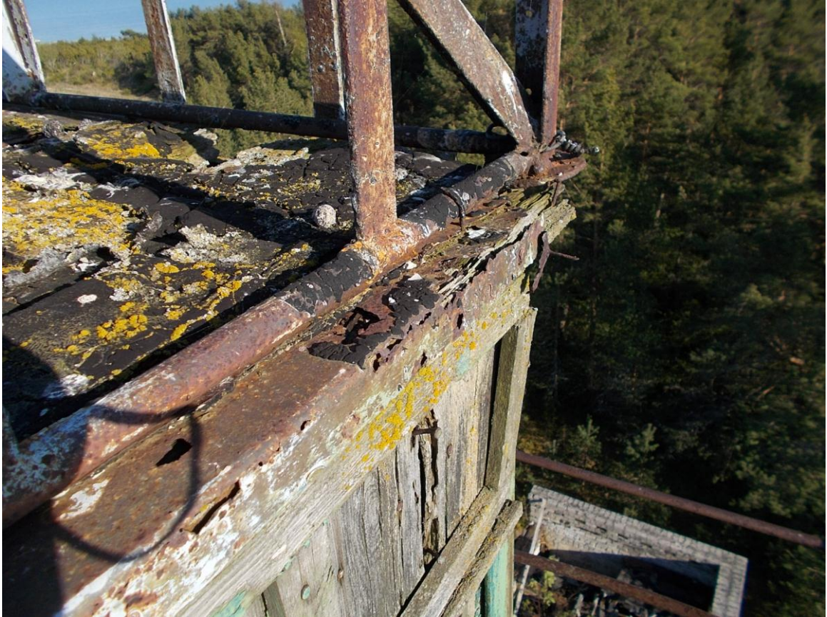
Foto 16. Tornikatusnurga detail (9.05.2016). Bituumenkatuse ja pleki ääris.
