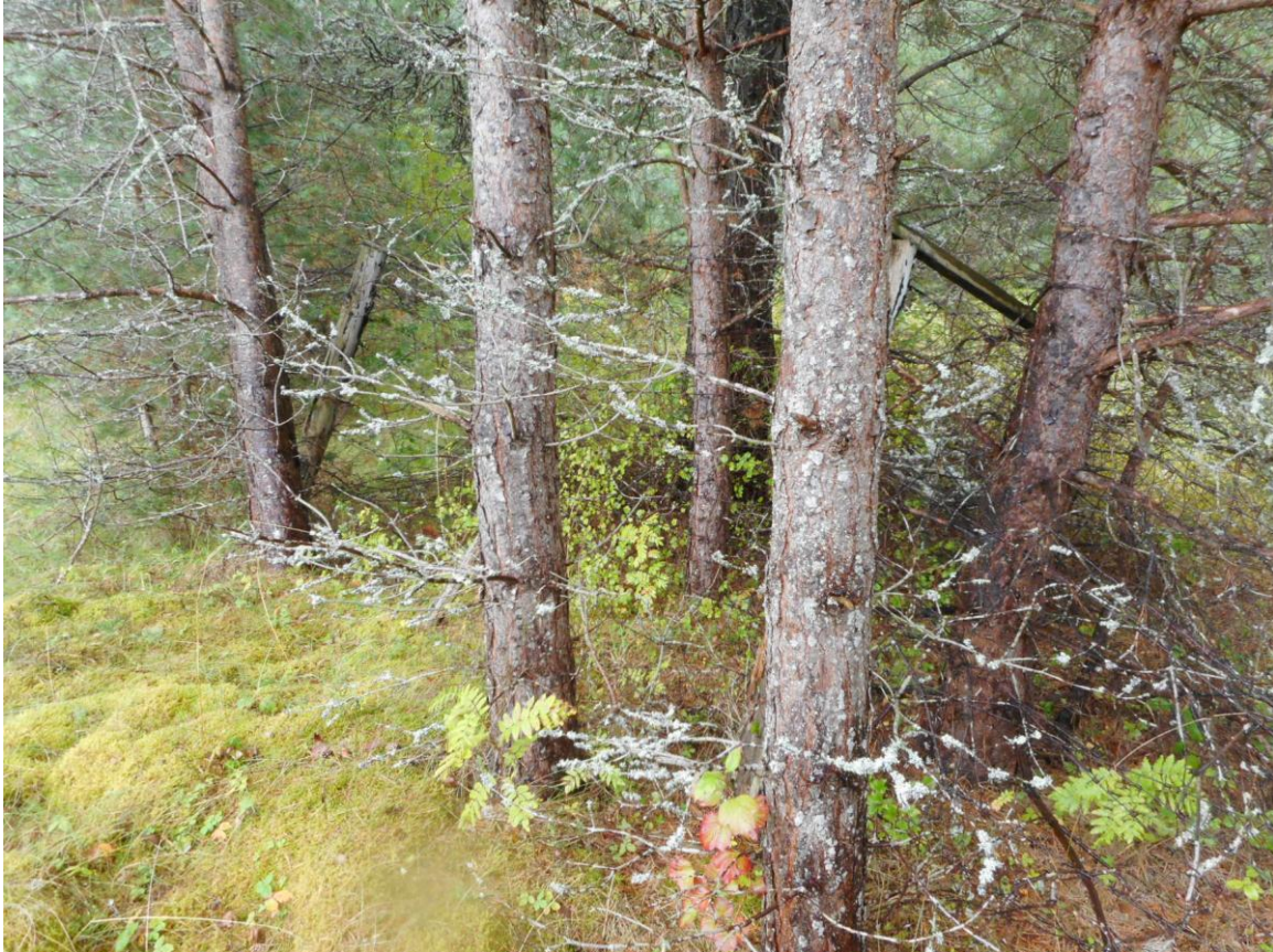
Foto 21. Piirdeaed (joonised 3–4, rajatis 5). Mitu posti koos traatidega on veel püsti — nende järgi saab aia taastada originaalkujul, kasvõi osaliselt.
