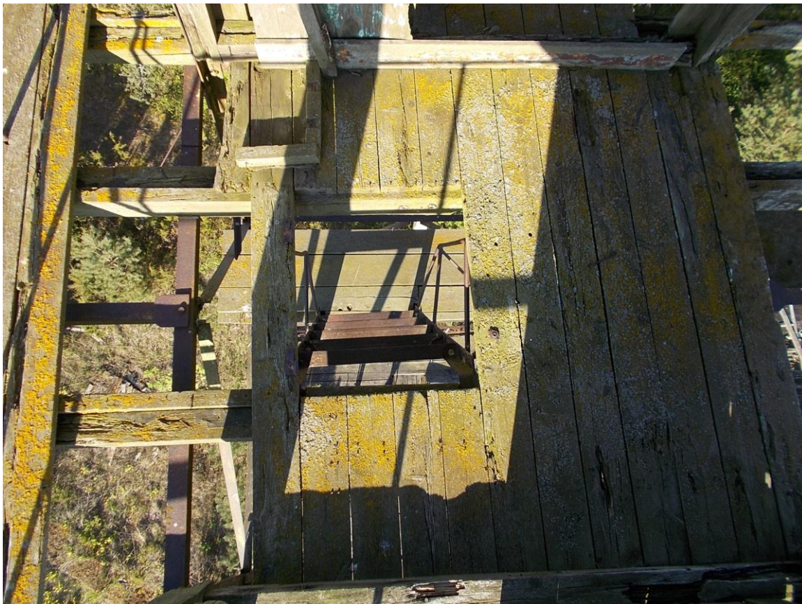
Foto 12. Tornis vaatlusruumi põrand (9.05.2016).
