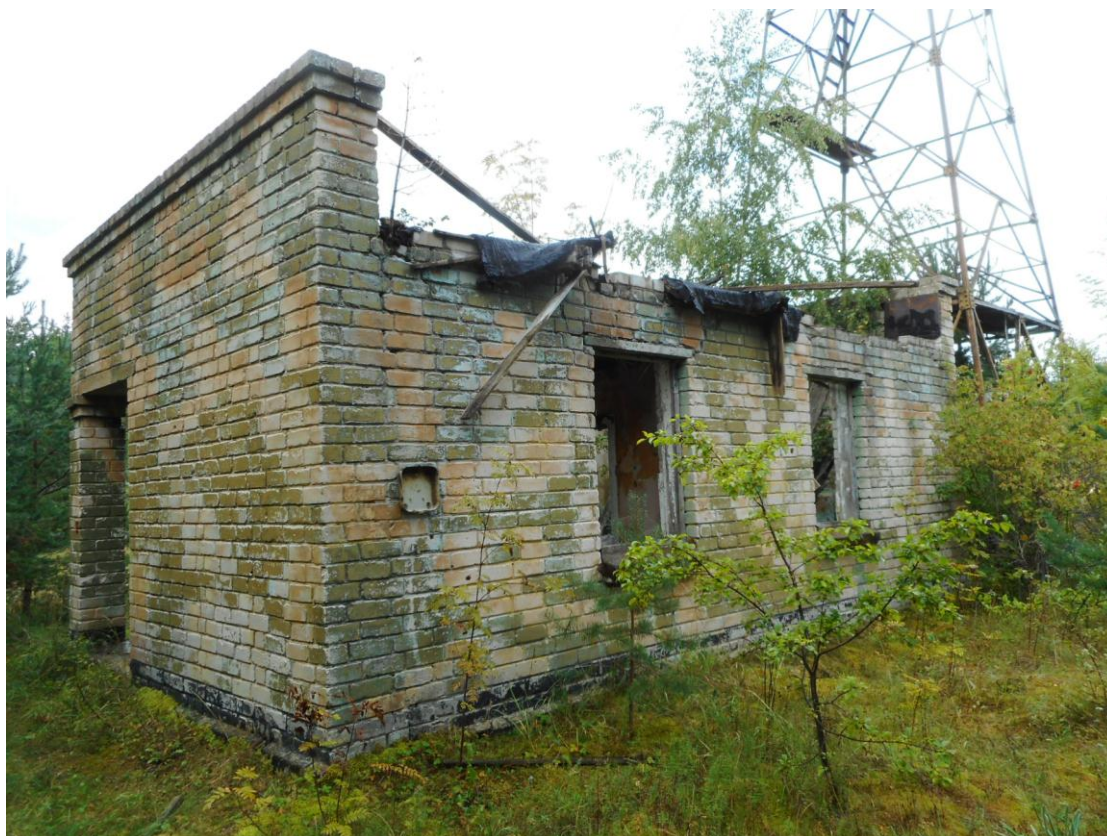
Foto 17. Operaatori- ehk tehniline hoone (joonised 3–4, hoone 1). Seintes on paar pragu, mis aga pole varisemisohtlikud. Seintel on säilinud palju siseviimistlust ja maskeerimismaalinguid. Katus osalt sisse langenud. Ehitatud enne 1976.a (seintesse kraabitud mitu aastaarvu).
