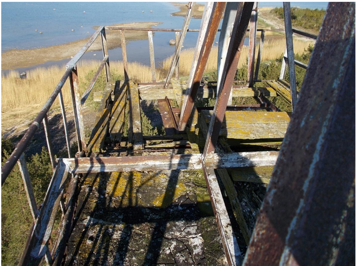
Foto 15. Radariantennialused ja nende teenindusplatvorm torni katusel (9.05.2016).
