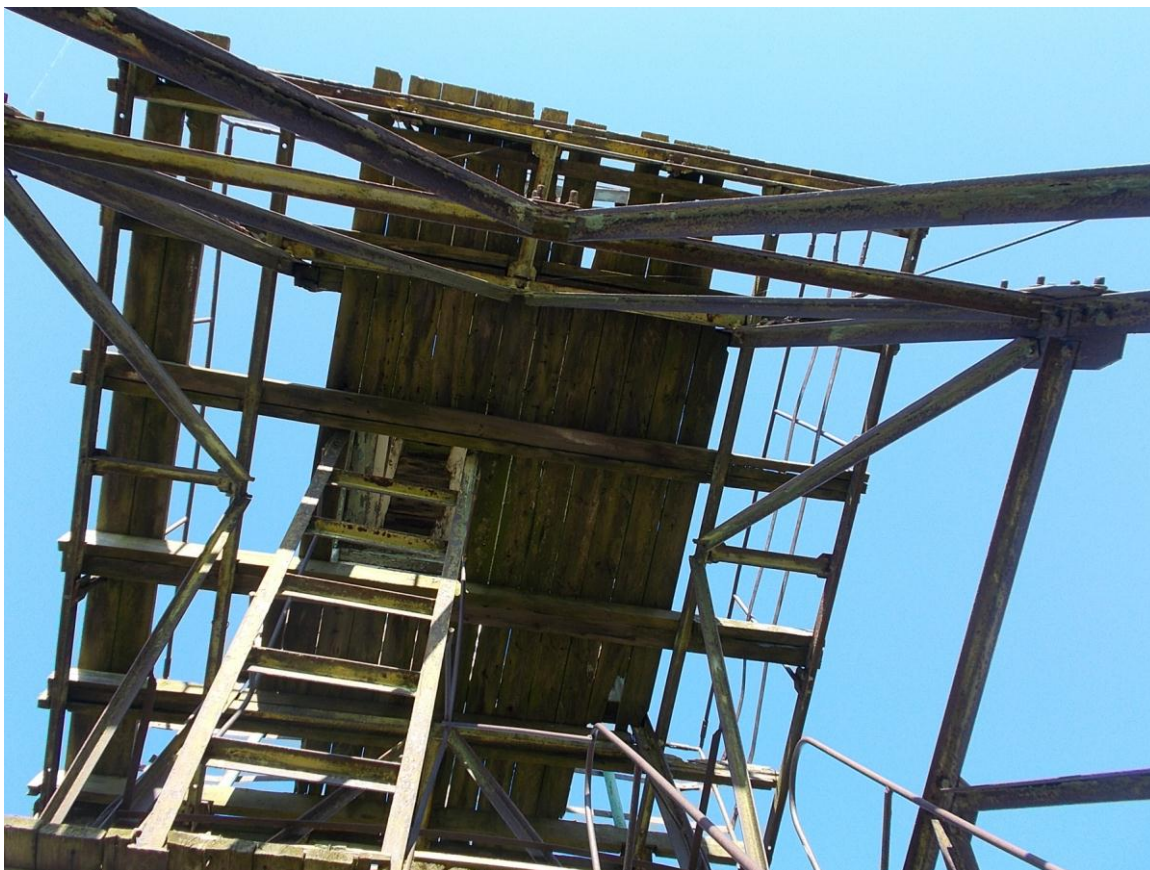
Foto 10. Tornis vaatlusruumi ning rõdu põrandad altpoolt (9.05.2016).
